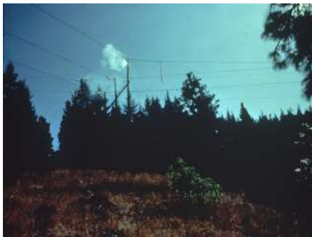
Εικόνα 11 Βλάβη ηλεκτρικού δικτύου
