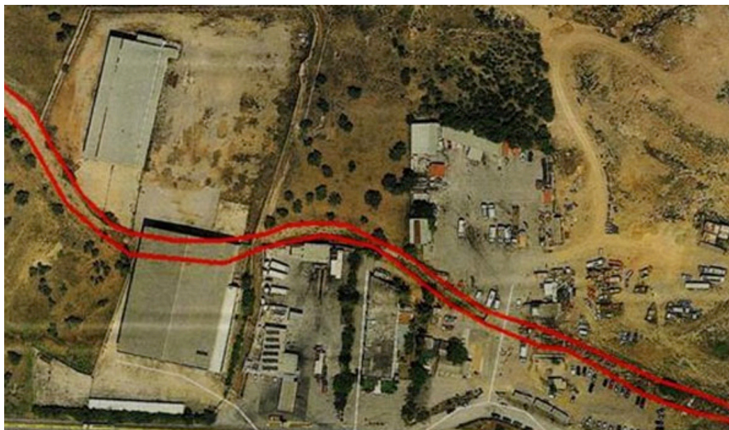
Εικόνα 6.2 Διακοπή υδατορεύματος από οικοδόμηση, Μάνδρα (Πηγή: https://dasarxeio.com/2017/11/19/51295/ )
