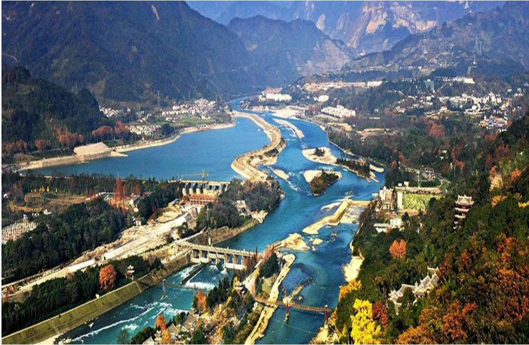
Εικόνα 1.2: Το κεντρικό τμήμα του αρδευτικού συστήματος Dujiangyan. (Πηγή: Cao et al., 2006)
