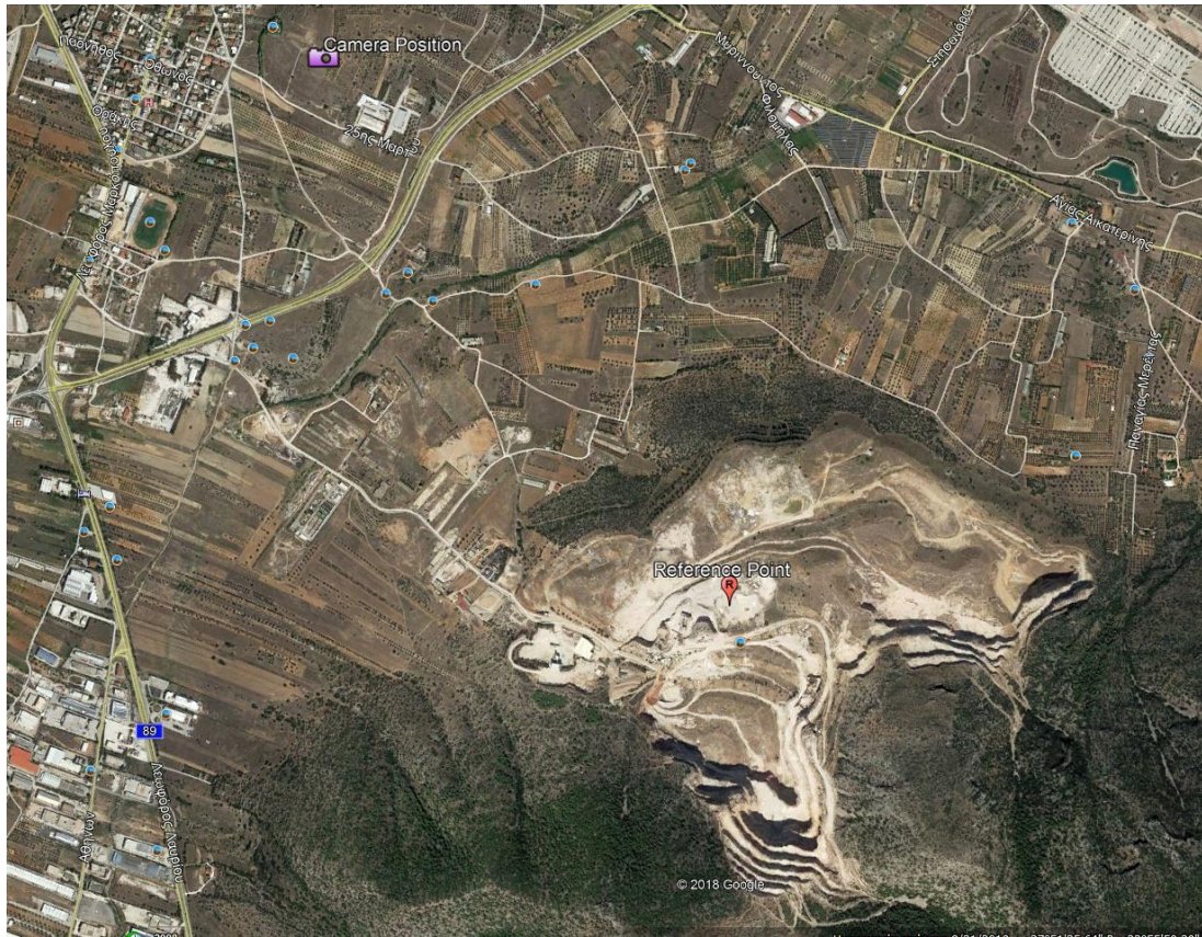
Εικόνα 6.5: Θέση σημείου λήψης φωτογραφιών με βάση ότι η εκσκαφή βρίσκεται στη θέση του σημείου αναφοράς.
