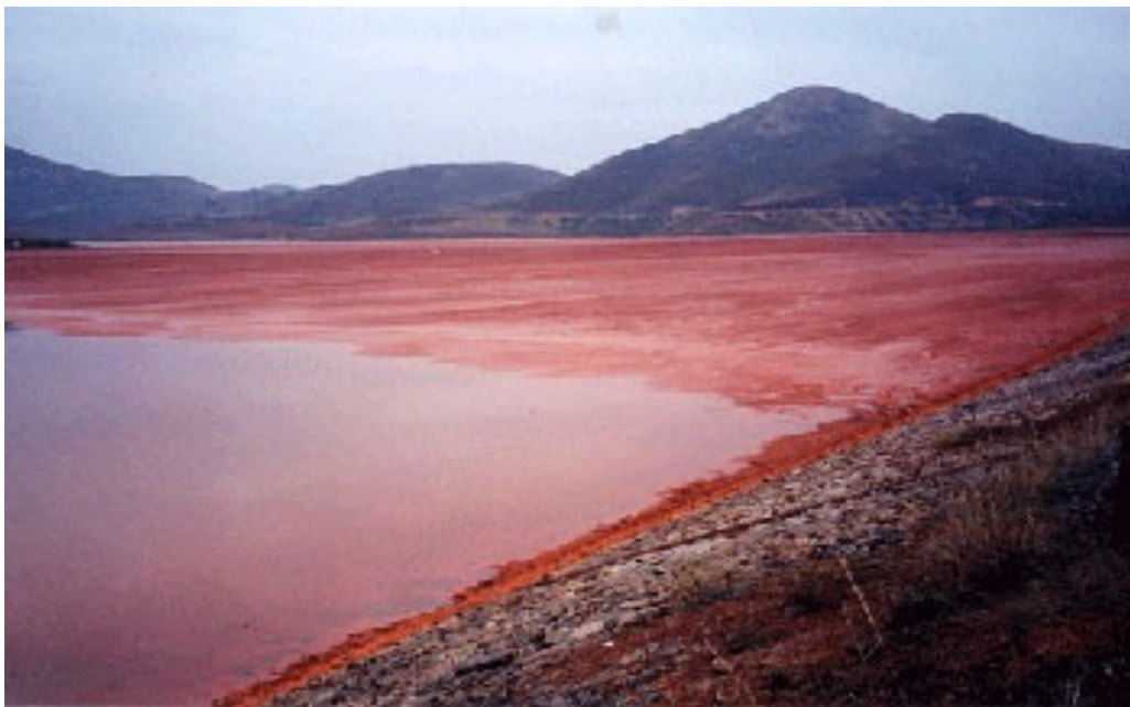
Εικόνα 1.4. Απόθεση βωξιτικών καταλοίπων σε υδατικό περιβάλλον (lagooning), συχνά υπό τη χρήση υποστρώματος φίλτρου για την αποφυγή μόλυνσης υπόγειων υδάτων. Orissa, India. [10]
