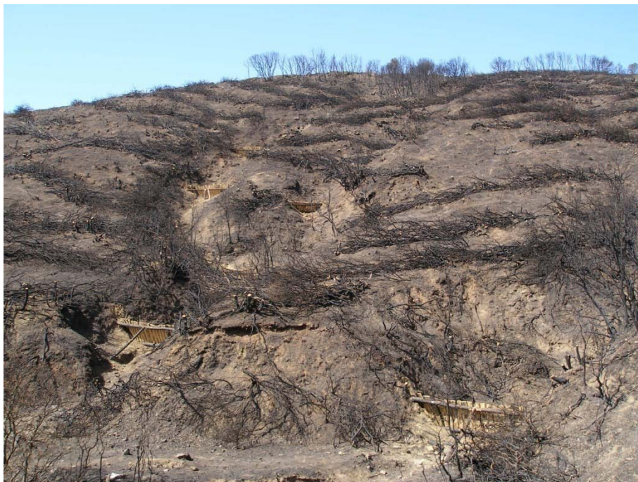
Φωτογραφία 15: Αντιπλημμυρικά έργα
