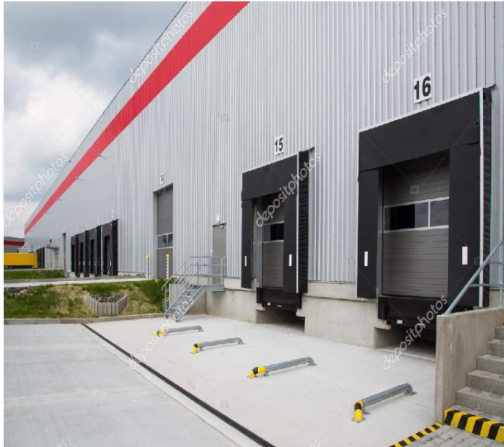
Εικόνα 69 Αποθήκη με βάση από σκυρόδεμα και κέλυφος από μεταλλική κατασκευή (Πηγή: Error! Bookmark not defined.)
