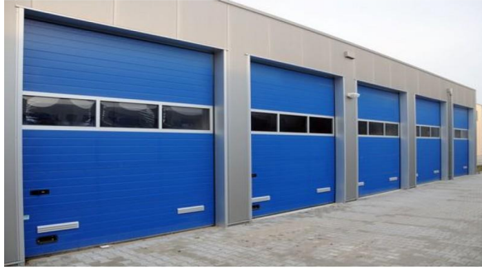
Εικόνα 93 Βιομηχανική θύρα τύπου σπαστή οροφής (Πηγή: 61)
