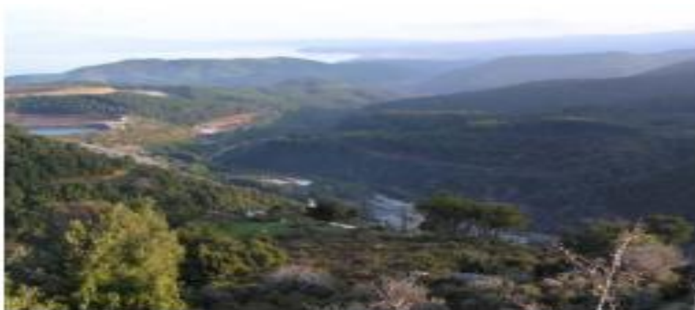
Εικόνα 1.1: Λεκάνη τελμάτων Κοκκινόλακκα (όψη από ανάντη προς κατόντη)
