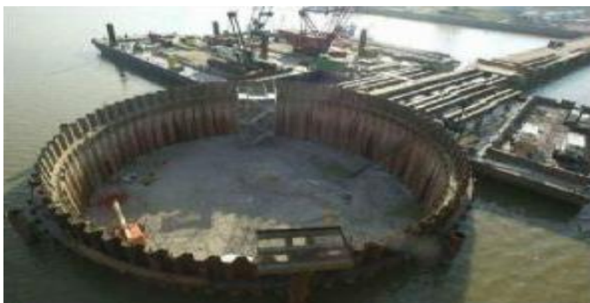
Εικόνα 3.7: Χρήση πασσαλοσανίδων για στεγάνωση του εργοταξίου (Αναστασοπούλου, 2018)
