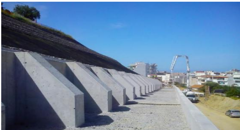
Εικόνα 3.6: Τοίχος αντιστήριξης με αντηρίδες (Αναστασοπούλου, 2018)
