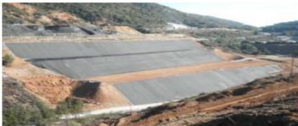
Εικόνα 1.2: Σύστημα στεγανοποίησης-κατασκευαστικές εργασίες
