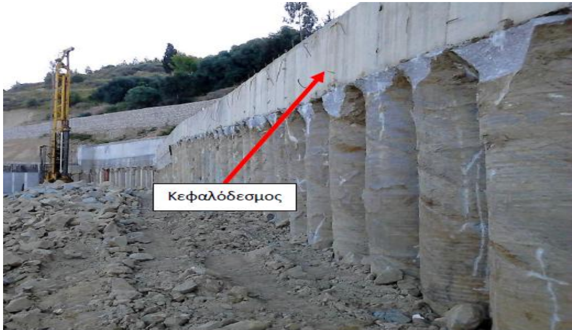
Εικόνα 3.10: Εκσκαφή εδαφών κατάντη της πασσαλοτοιχίας. Στη φωτογραφία σημειώνεται και ο κεφαλόδεσμος (Σπηλιωτοπούλου et. al.,2016)
