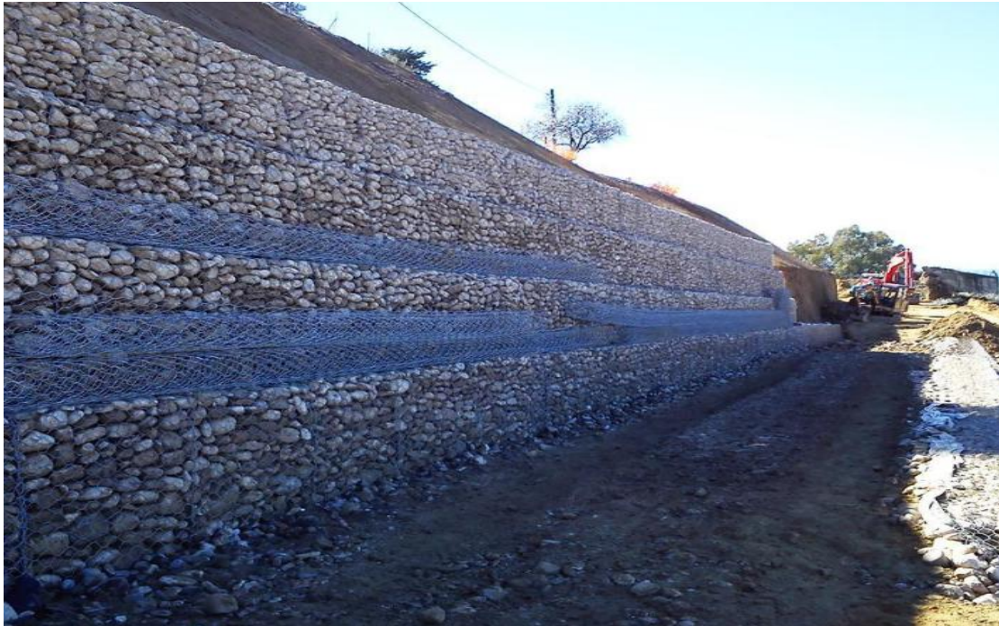
Εικόνα 3.4: Τοίχος αντιστήριξης με συρματοκιβώτια ( www.koumoulos.com , 10/2/2020)
