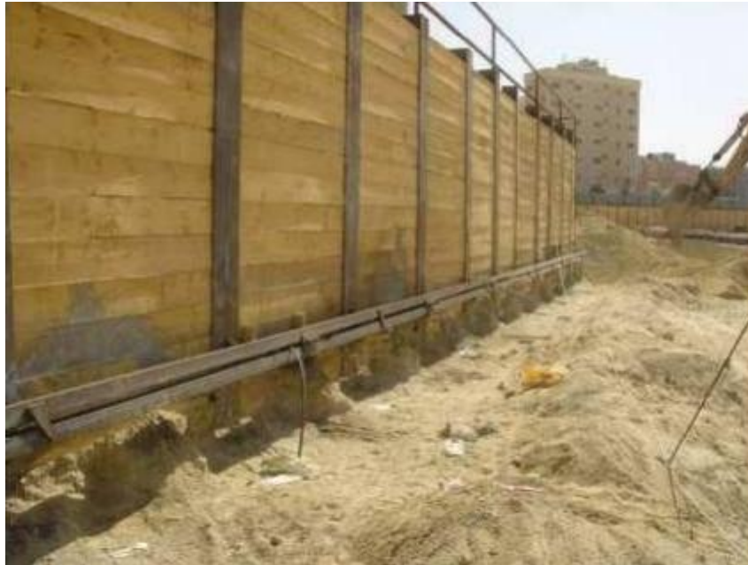
Εικόνα 3.9: Τοίχος τύπου Βερολίνου (Αναστασοπούλου, 2018)
