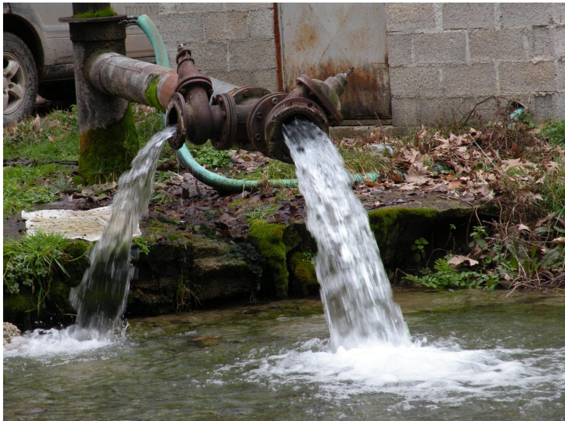
Εικόνα 6.5.3: Αρτεσιανή γεώτρηση ΑΓ59 στην περιοχή του Πραιτωρίου με αυτόματη ροή περί τα 50 \text{ m}^3/\text{h} .
