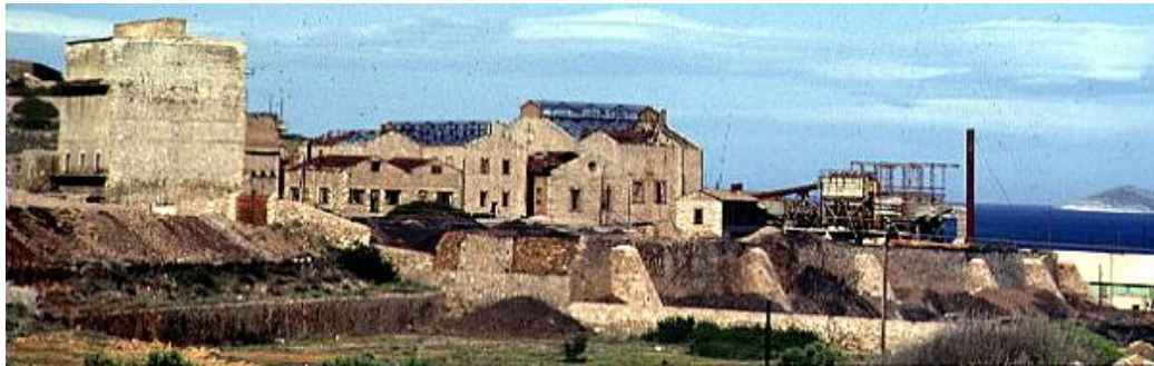
Εικόνα 8.4.19: Απόψεις των εγκαταστάσεων του Λαυρίου πριν την έναρξη των εργασιών αποκατάστασης.
