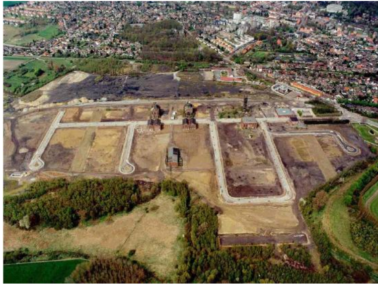
Εικόνα 8.4.4: Άποψη του χώρου μετά το πέρας των εργασιών εξυγίανσης.
