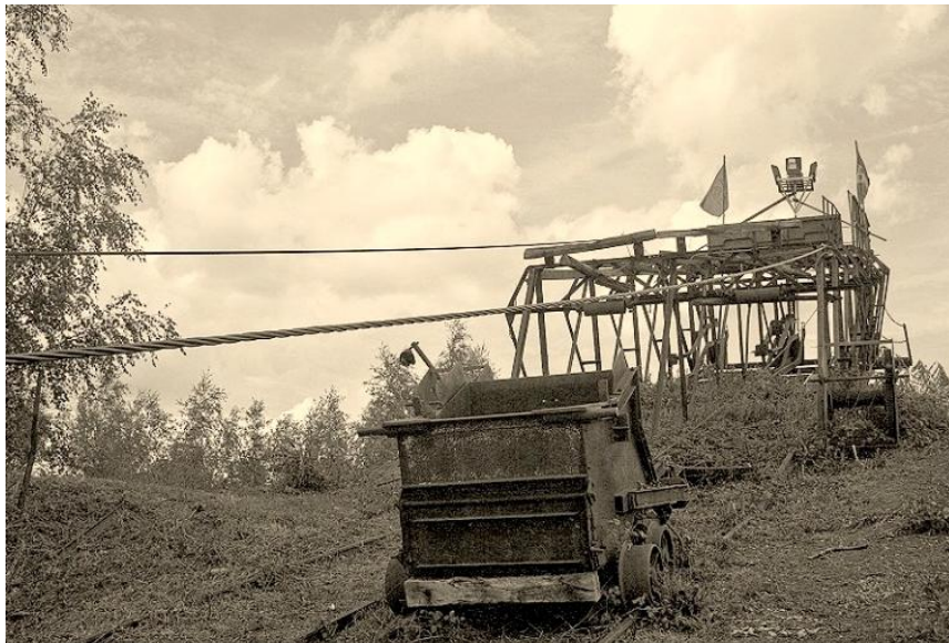
Εικόνα 8.4.7: Άποψη των παλαιών εγκαταστάσεων.
