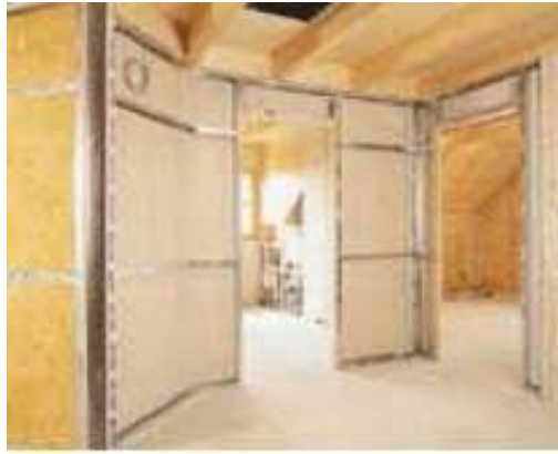
Σχήμα 1-14 Συστήματα εσωτερικής τοιχοποιίας από γυψοσανίδες
