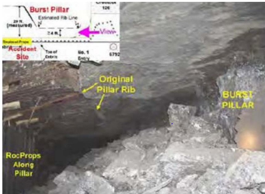
Εικόνα 8: Pillar burst (Jones et.al, 2019)
