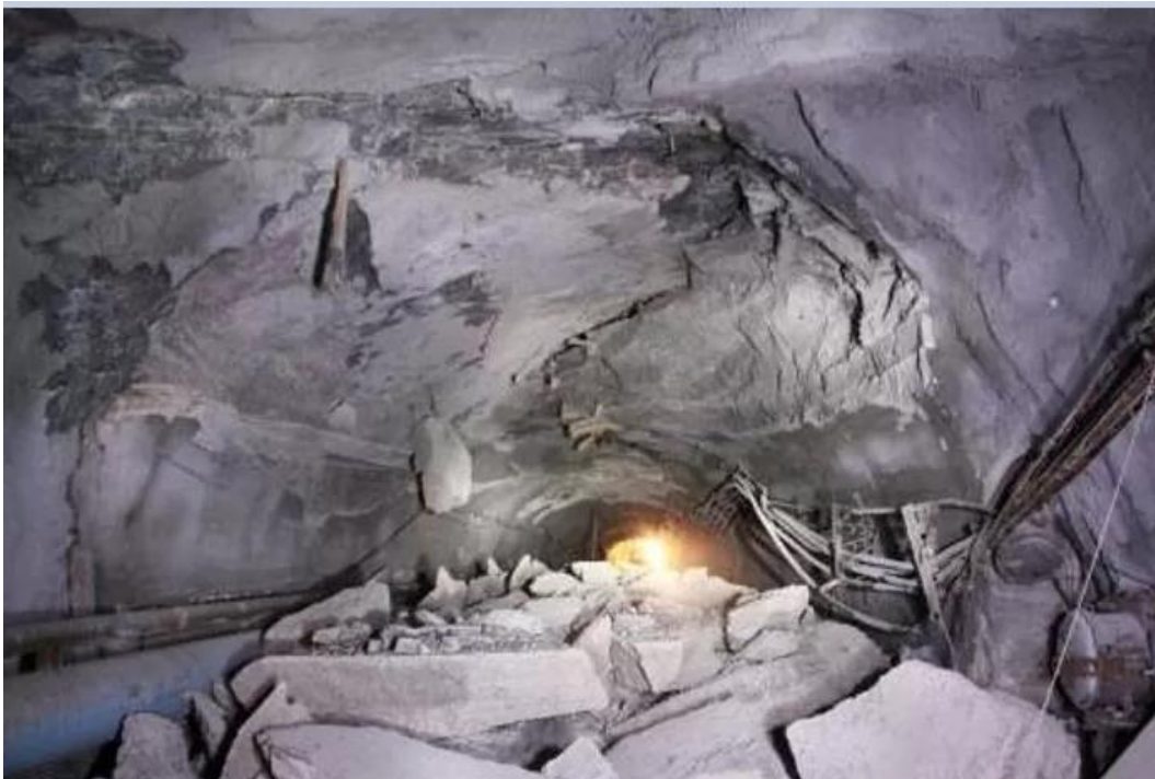
Εικόνα 1: Φαινόμενο rockburst (mirageoscience.com)
