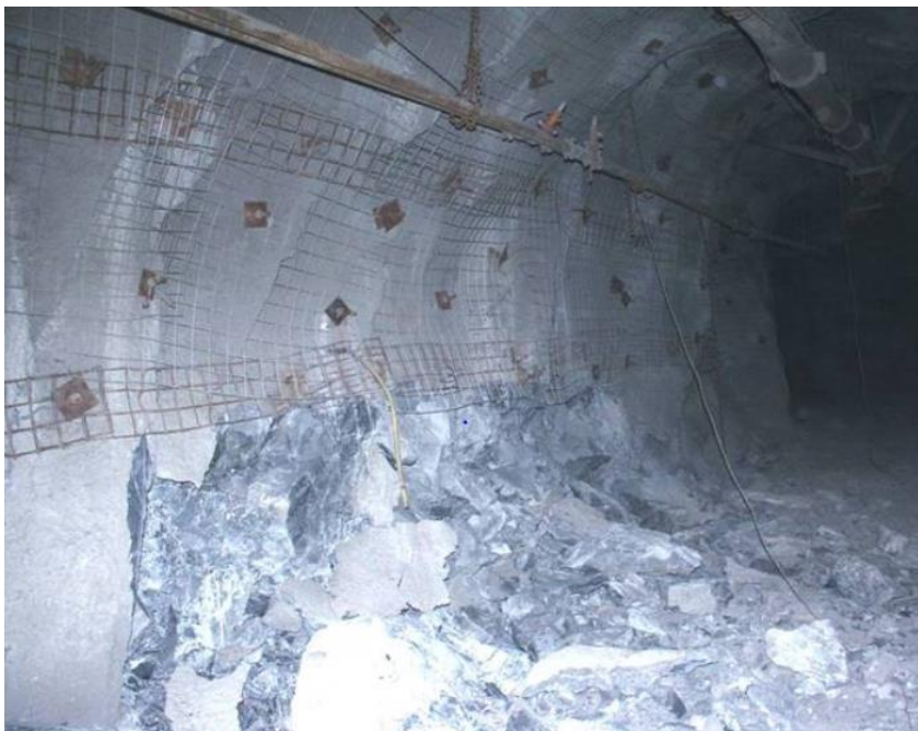
Εικόνα 6: Strainburst σε υποστηριζόμενη εκσκαφή (Kaiser, Cai, 2012)
