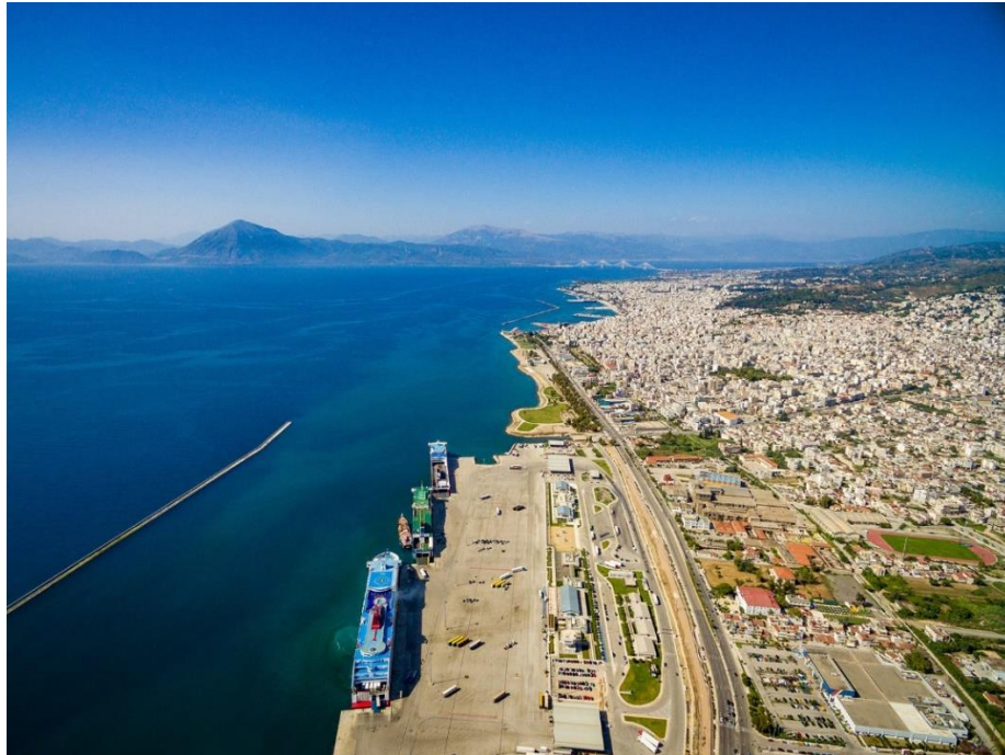
Εικόνα 7.2 Αεροφωτογραφία του νέου λιμένα Πατρών (πηγή: https://www.patrasport.gr/photo-gallery ).
