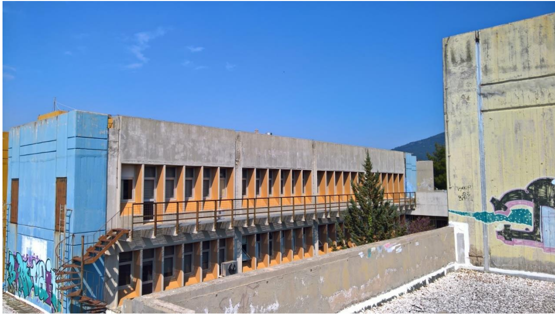
Εικόνα 2.11: Νότιο μέρος πτέρυγας εργαστηρίων
