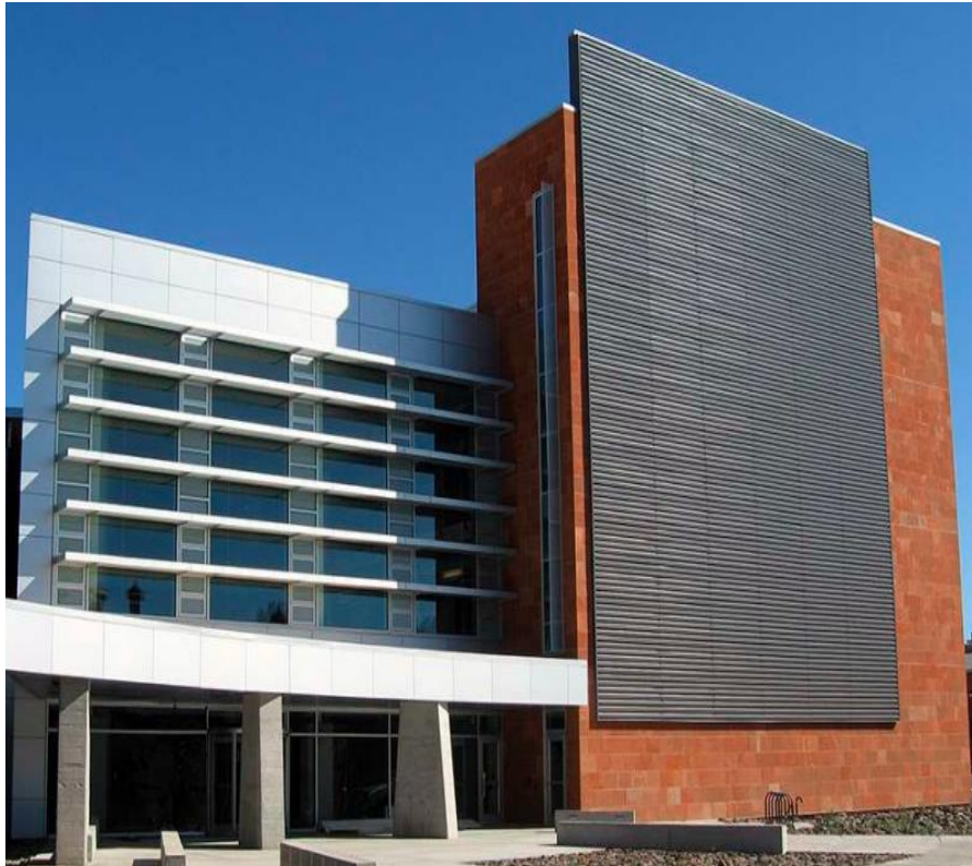
Εικόνα 2.8: Έργο ηλιακής θέρμανσης αέρα στις Ηνωμένες Πολιτείες Αμερικής - Πανεπιστήμιο στη Βόρεια Αριζόνα
