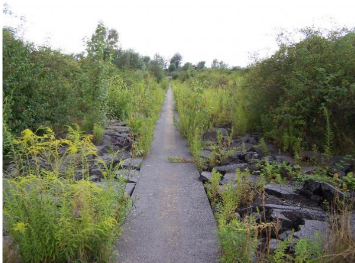
Εικόνα 17. Αεροδρόμιο Maurice Rose. Θραύση σκληρών επιφανειών και φύτευση στα κενά. Πηγή: http://wikimapia.org/1873718/Maurice-Rose-Army-Airfield .
