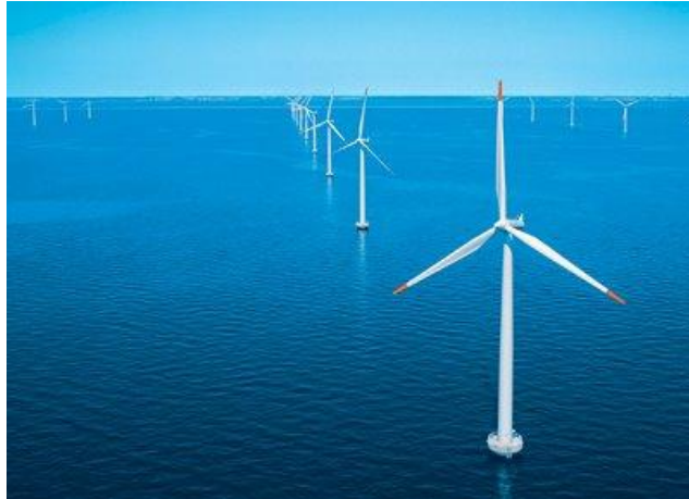
Εικόνα 40. Αιολικό Πάρκο εγκατεστημένο στη θάλασσα.
