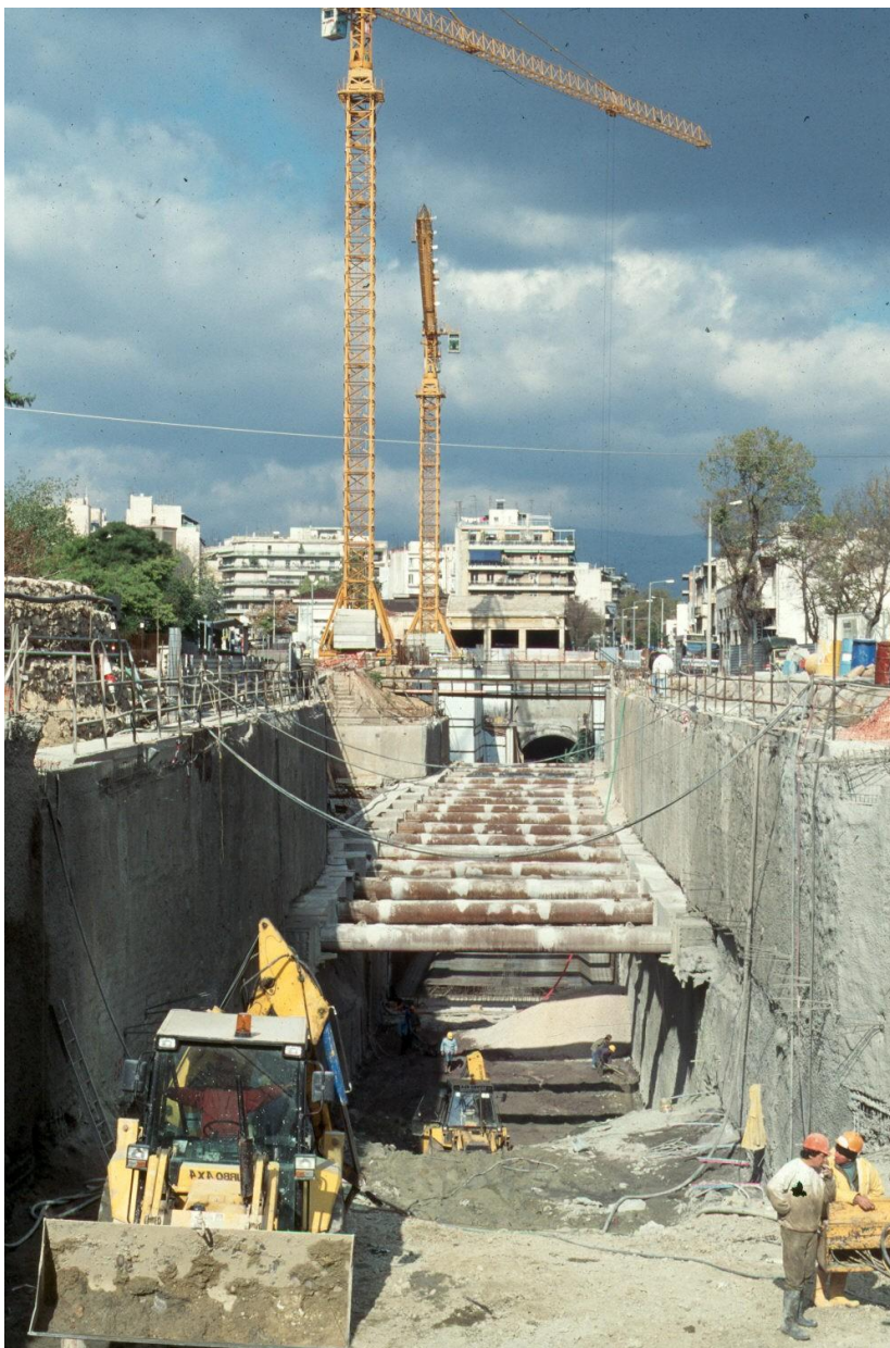
Εικόνα 4-1, Διάνοιξη σταθμου με τη μέθοδο ανοικτής εκσκαφής, Πηγή: Αττικό Μετρό
