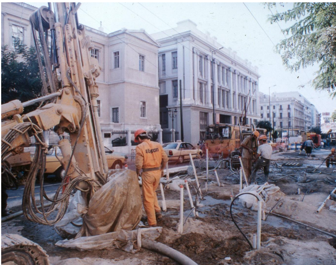
Εικόνα 4-8, Βελτίωση εδάφους λόγω εκδήλωσης καθίζησης στην οδό Πανεπιστημίου, Πηγή: Αττικό Μετρό
