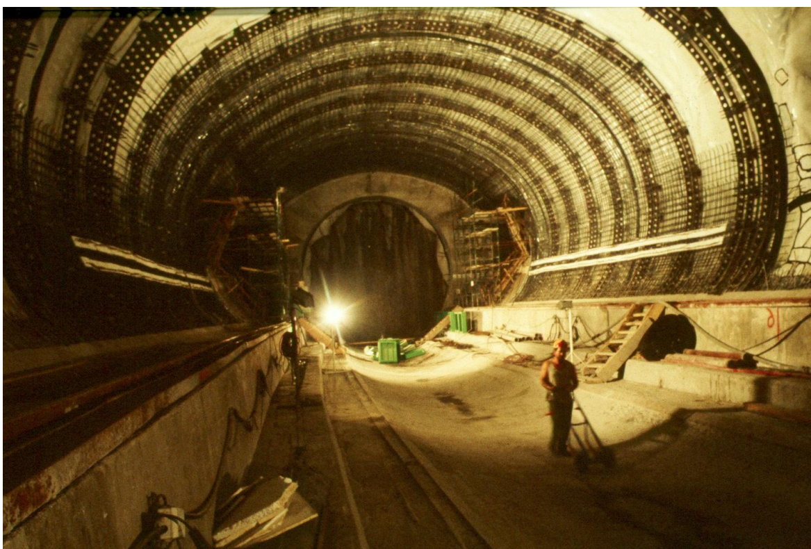
Εικόνα 4-3, Κατασκευή σταθμού με τη υπόγεια διάνοιξη, Πηγή:Αττικό Μετρό
