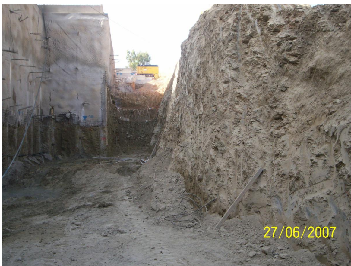
Εικόνα 4-2, Τοίχοι αντιστήριξης πρανών, Πηγή: Αττικό Μετρό
