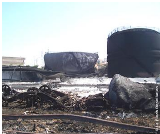
Εικόνα 2.17.: Δεξαμενές αποθήκευσης πετρελαίου στο εργοστάσιο “Jyeh” μετά τους βομβαρδισμούς (Πηγή: Le Floch Dépollution)
