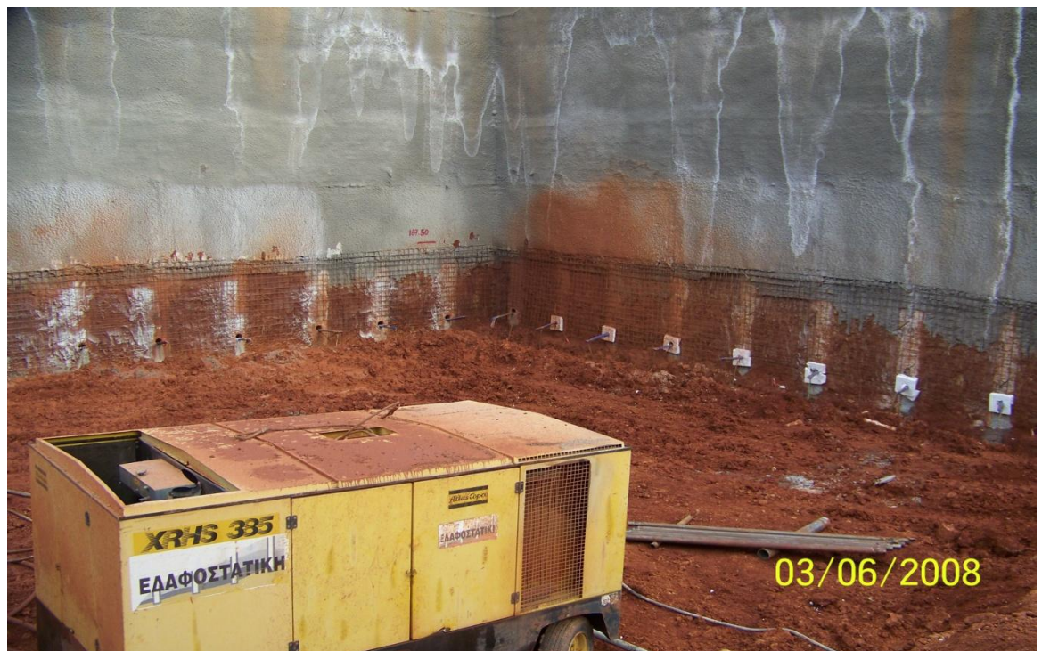
Εικόνα 4.17. Κατασκευή 3 ης σειράς αγκυριών στη δυτική πλευρά (τμήμα 2).
