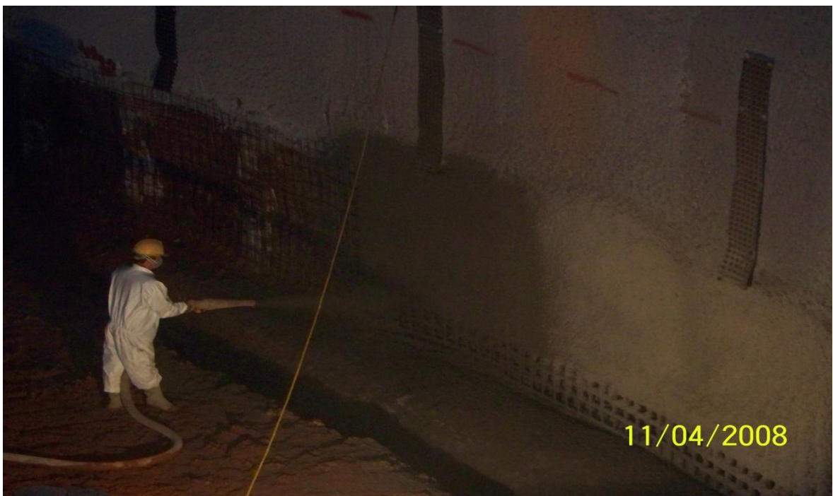
Εικόνα 4.41. Εφαρμογή εκτοξευόμενου σκυροδέματος κατά τη Β' φάση.
