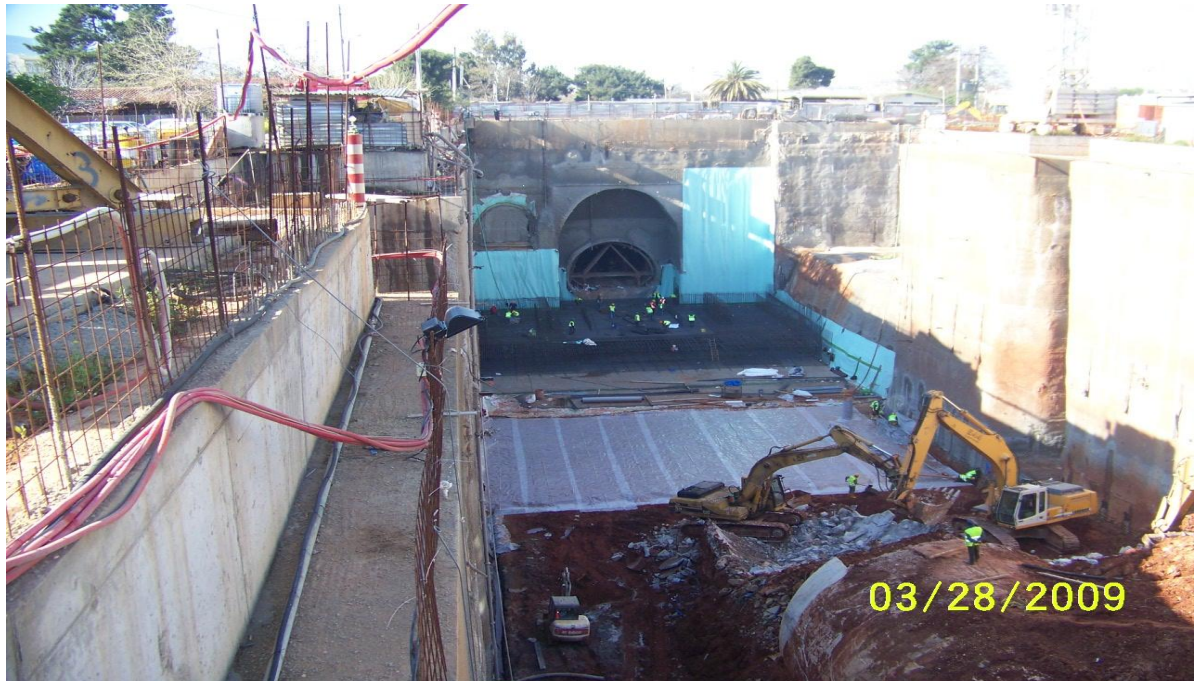
Εικόνα 4.59. Παράλληλες εργασίες στο σύνολο του ορύγματος στο Α τμήμα τοποθέτηση σιδηροπλισμού στο Β αποστράγγιση πυθμένα και στο Γ καθαίρεση σήραγγας.
