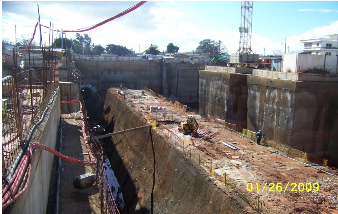
Εικόνα 4.37. Χρησιμοποίηση άνω τμήματος πρίσματος ως διαδρόμου κύλισης φορτηγών κατά τις επόμενες φάσεις.
