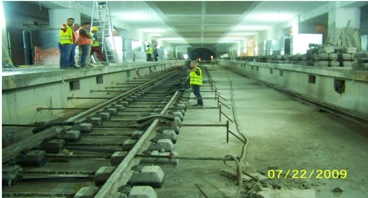
Εικόνα 5.6. Επανεγκατάσταση 1 ης σιδηροτροχιάς.
