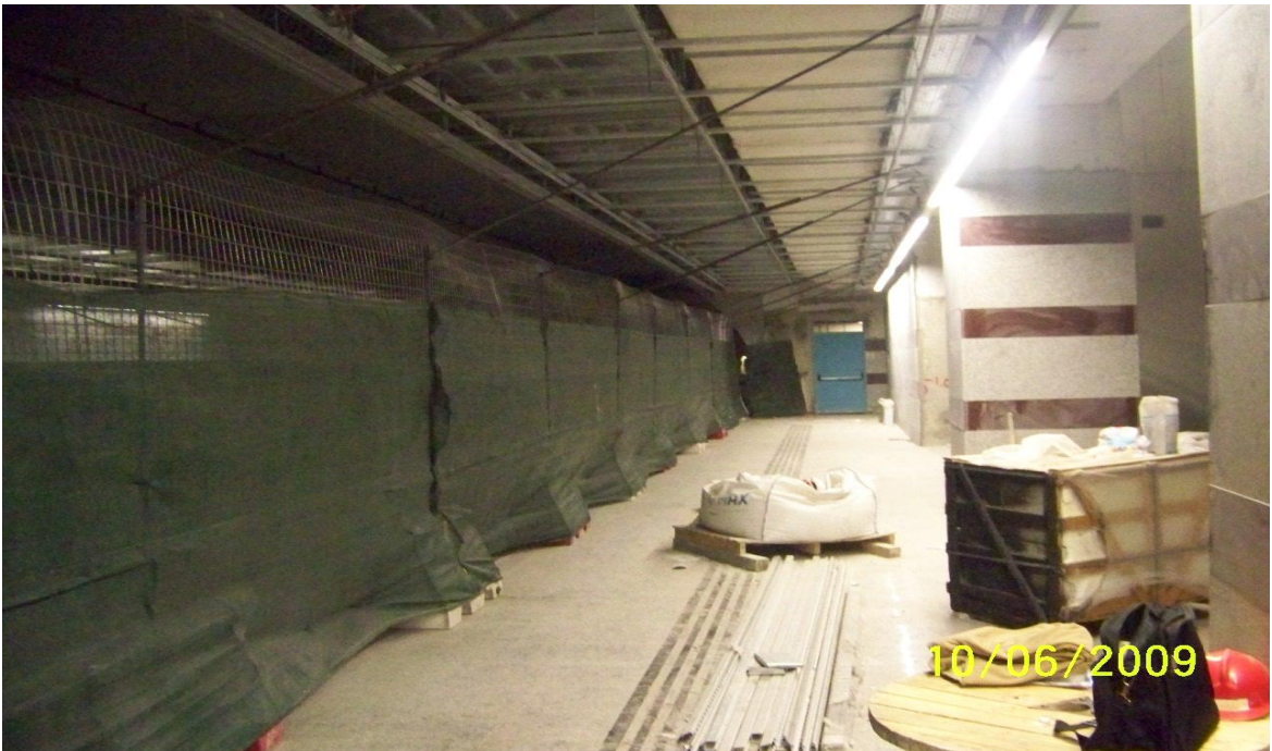
Εικόνα 5.12. Τοποθετημένα διαχωριστικά πανέλα.
