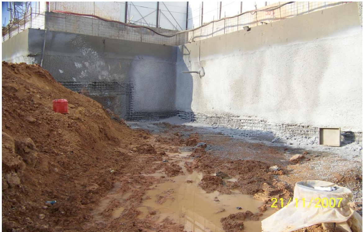
Εικόνα 4.6. Τελική μορφή μετά την εφαρμογή του εκτοξευόμενου σκυροδέματος.
