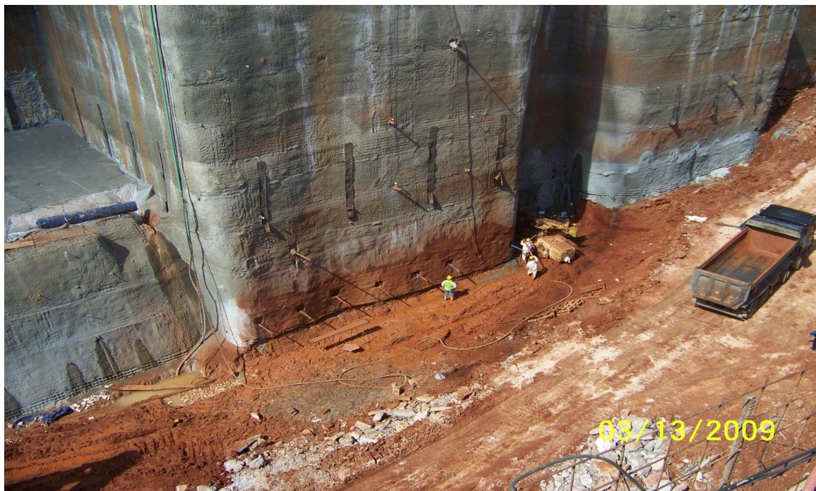
Εικόνα 4.46. Κατασκευή 5 ης σειράς αγκυρίων στη δυτική πλευρά (τμήμα 2).
