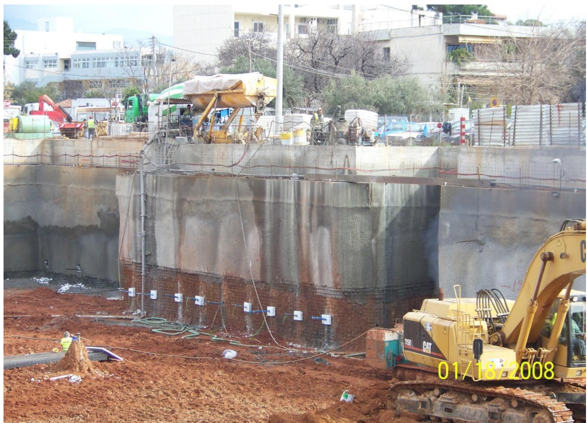
Εικόνα 4.12. Κατασκευή 2 ης σειρά αγκυριών
