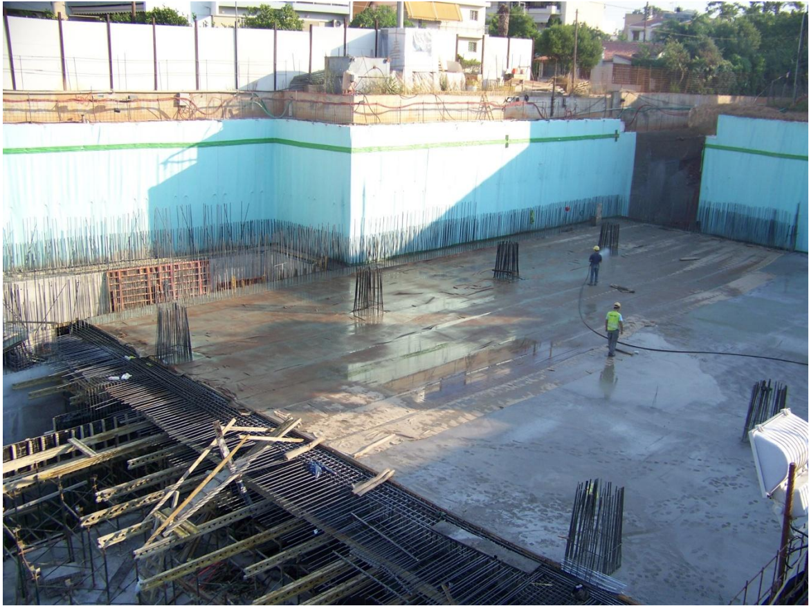
Εικόνα 5.11. Σκυροδέτηση πλάκας δαπέδου του ορόφου (-1).
