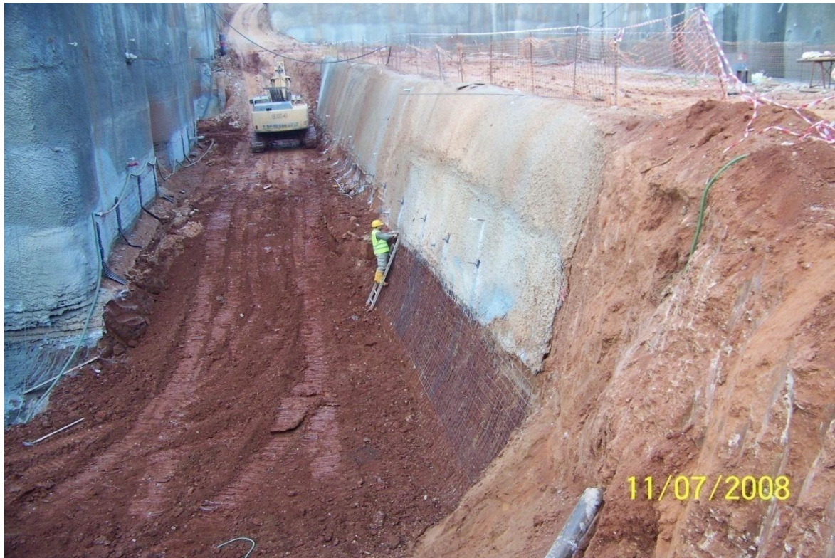
Εικόνα 4.30. Αποστραγγιστικές οπές και αγκυρία στο κεντρικό πρίσμα.
