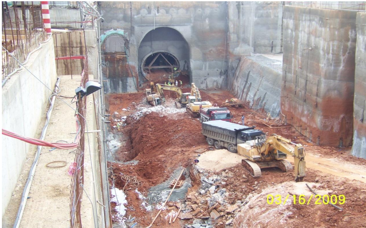
Εικόνα 4.54 Διαδικασία καθαίρεσης της σήραγγας
