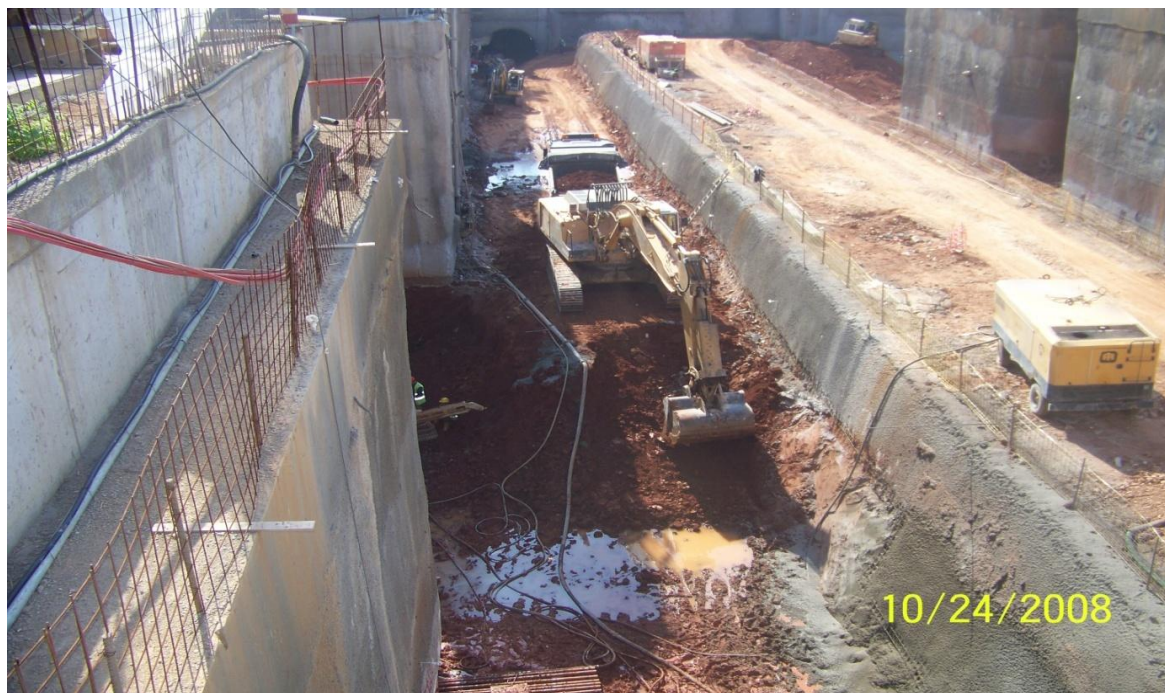
Εικόνα 4.27. Εκσκαφή 4 ης φάσης στην ανατολική πλευρά (τμήμα 1).
