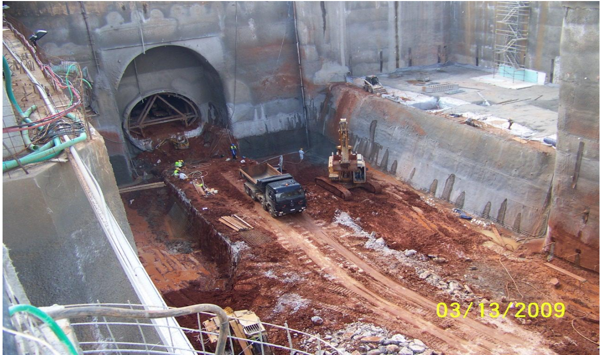
Εικόνα 4.43. Θέση μεταλλικών δακτυλίων, τελική στάθμη δυτικής εισόδου, κατασκευασμένο Ν.Φ.Ε., καθαίρεση σήραγγας.
