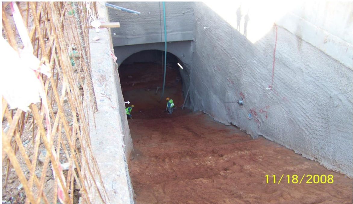
Εικόνα 4.32. Ολοκλήρωση προσωρινής αντιστήριξης cut and cover
