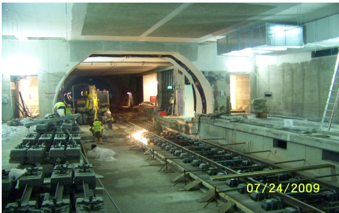
Εικόνα 5.7. Εργασίες εγκατάστασης 1 ης σιδηροτροχιάς.
