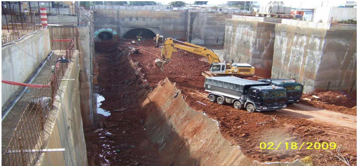
Εικόνα 4.47. Εκσκαφή άνω τμήματος πρίσματος.
