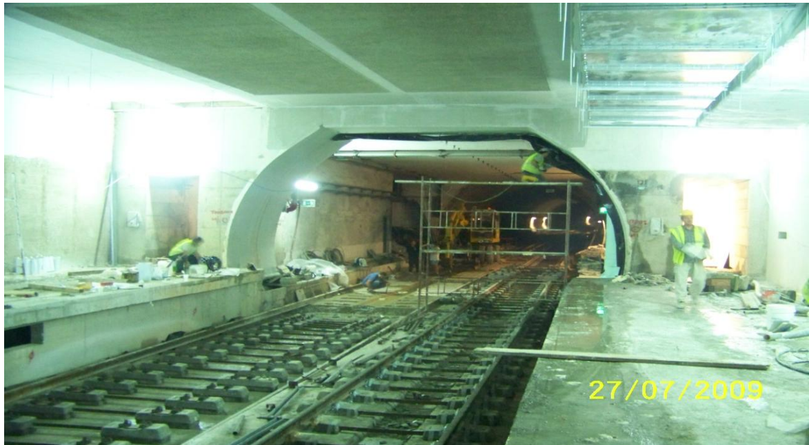
Εικόνα 5.8. Επανεγκατάσταση και των δύο σιδηροτροχιών.
