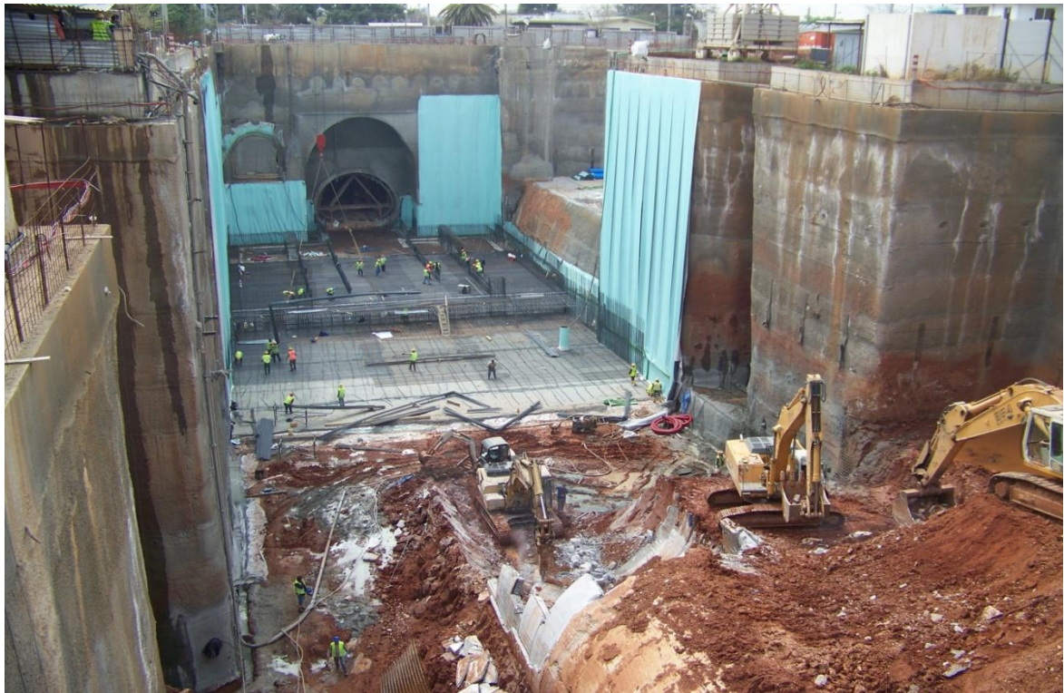
Εικόνα 4.57. Τοποθέτηση σιδηροπλισμού στο τμήμα της πλάκας θεμελίωσης.
