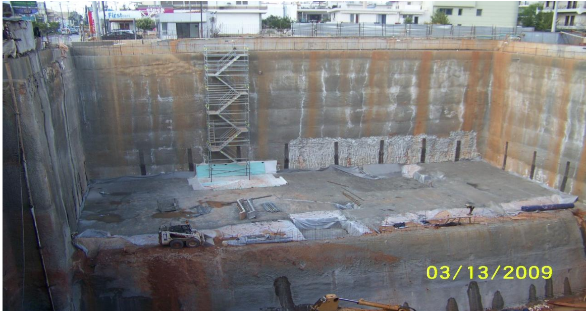
Εικόνα 4.49. Δυτική είσοδος στην οποία φαίνεται η υψομετρική διαφορά με το κεντρικό σκάμμα.
