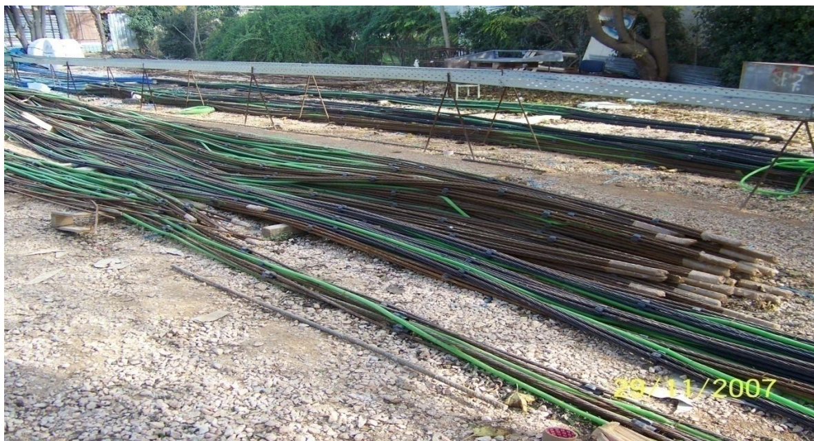
Εικόνα 4.10. Προεντεταμένα αγκυρια αποθηκευμένα στην επιφάνεια του σταθμού
