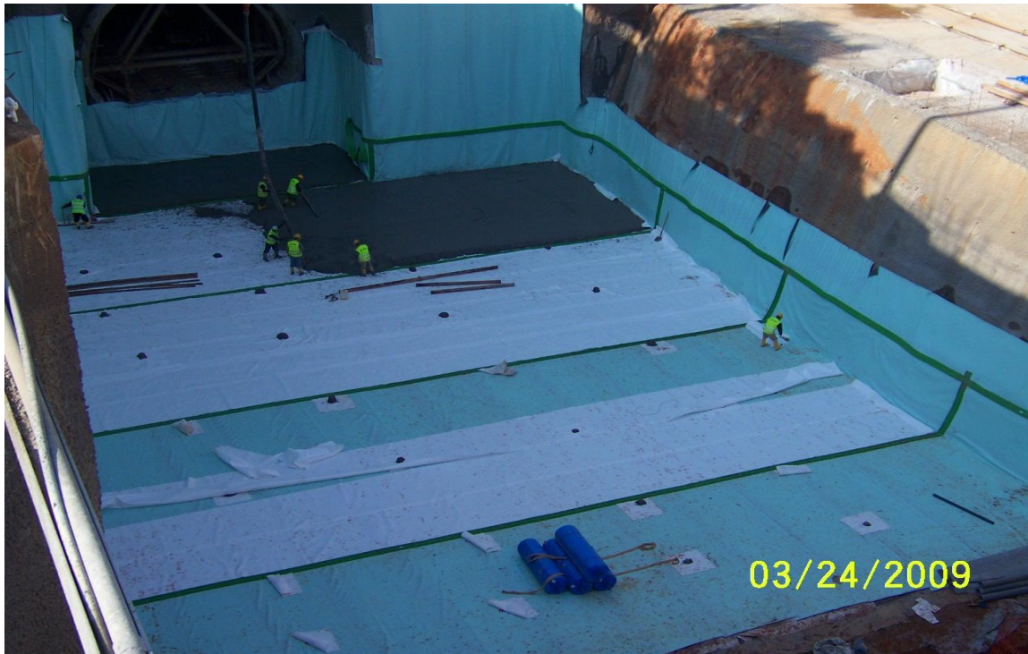
Εικόνα 4.60. Υδατοστεγάνωση δαπέδου και άοπλο σκυρόδεμα.
