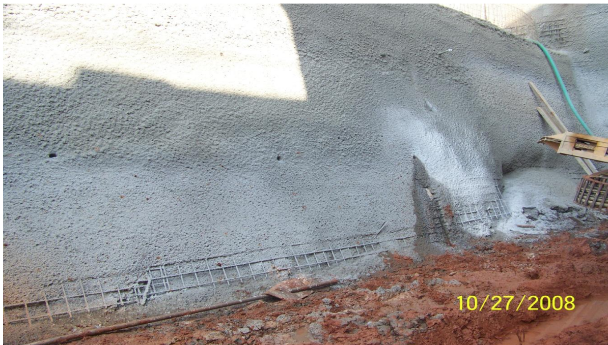
Εικόνα 4.29. Εκτοξευόμενο σκυρόδεμα οπλισμένο με δομικό πλέγμα και αγκύρια στο κεντρικό πρίσμα.
