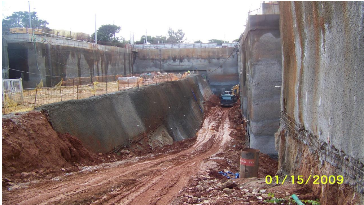
Εικόνα 4.34.Εκσκαφή 5 ης φάσης στη δυτική πλευρά (τμήμα 2).
