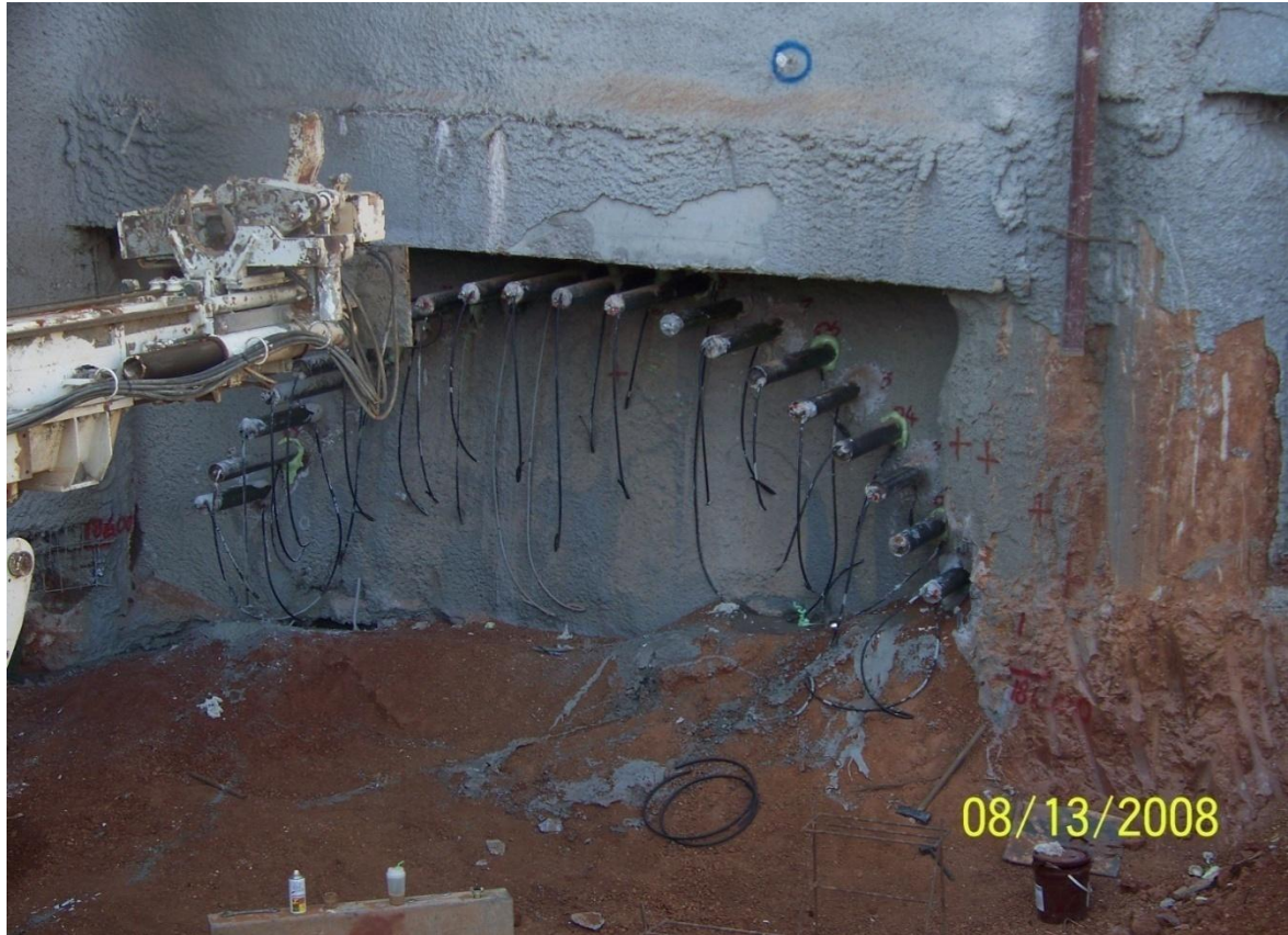
Εικόνα 4.21. Διάτρηση δοκών προπορείας για τη Νότια είσοδο.
