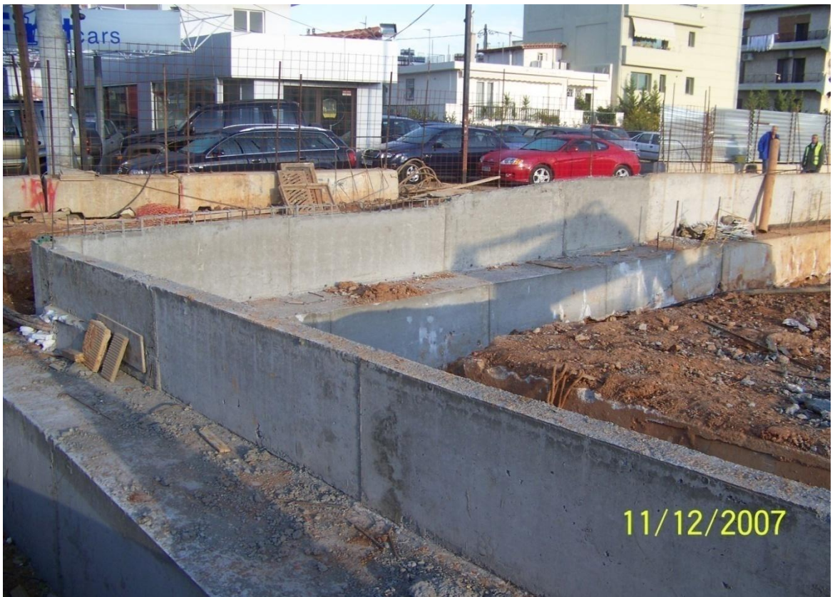
Εικόνα 4.2. Κεφαλόδεσμος και τοιχίο κεφαλόδεσμου.
