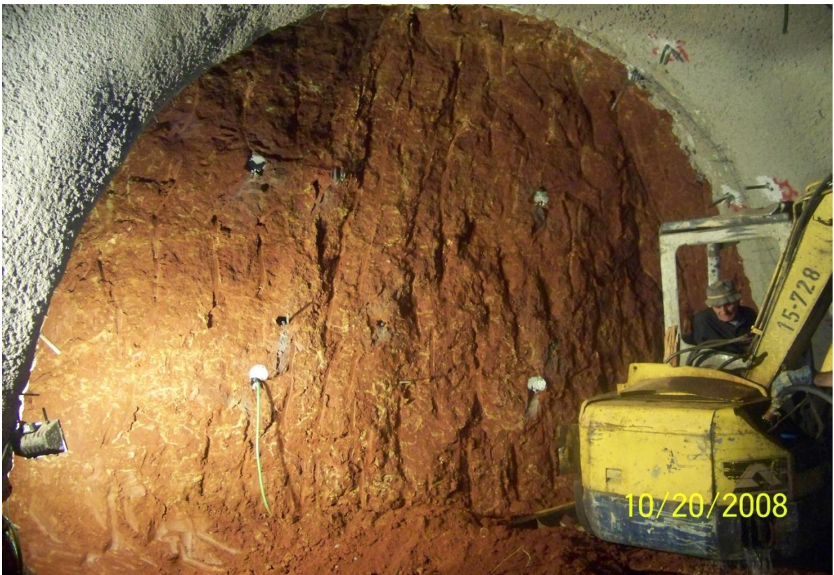
Εικόνα 4.25. Ολομέτωπη εκσκαφή Α' στάδιου.
