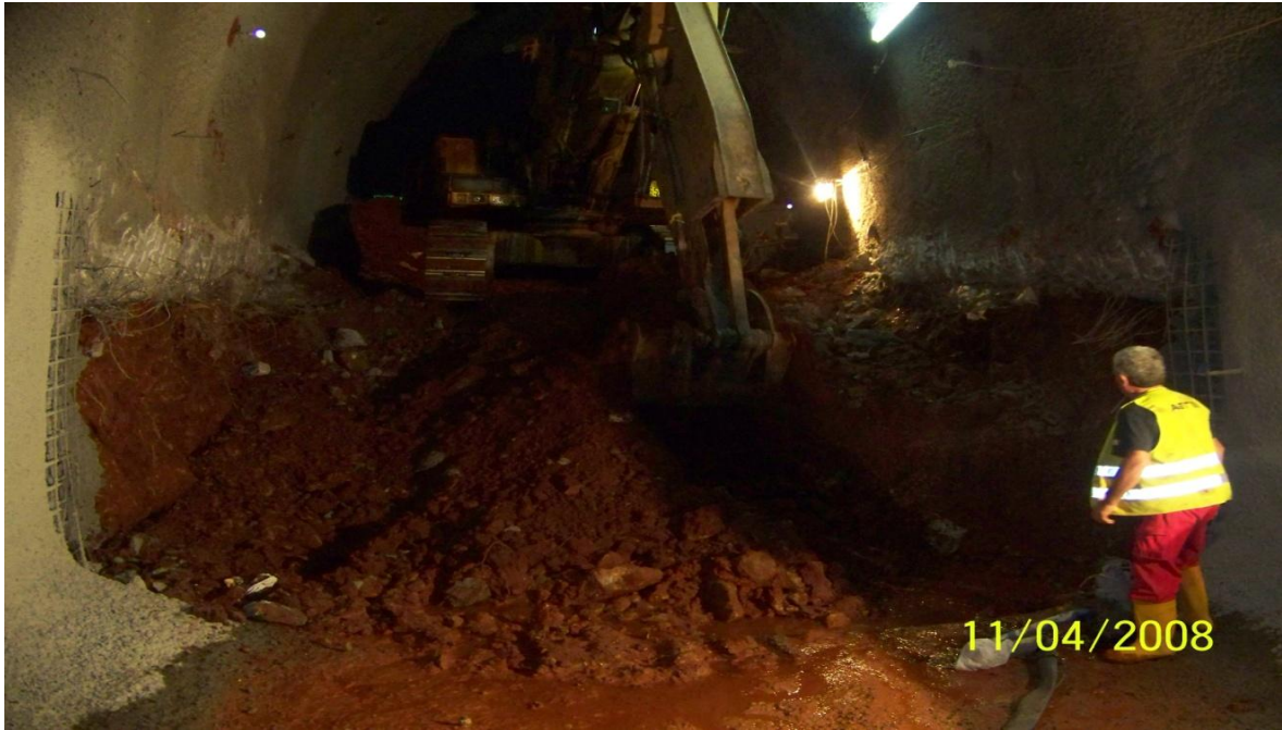
Εικόνα 4.40. εκσκαφή Β' Φάσης σήραγγας NATM.
