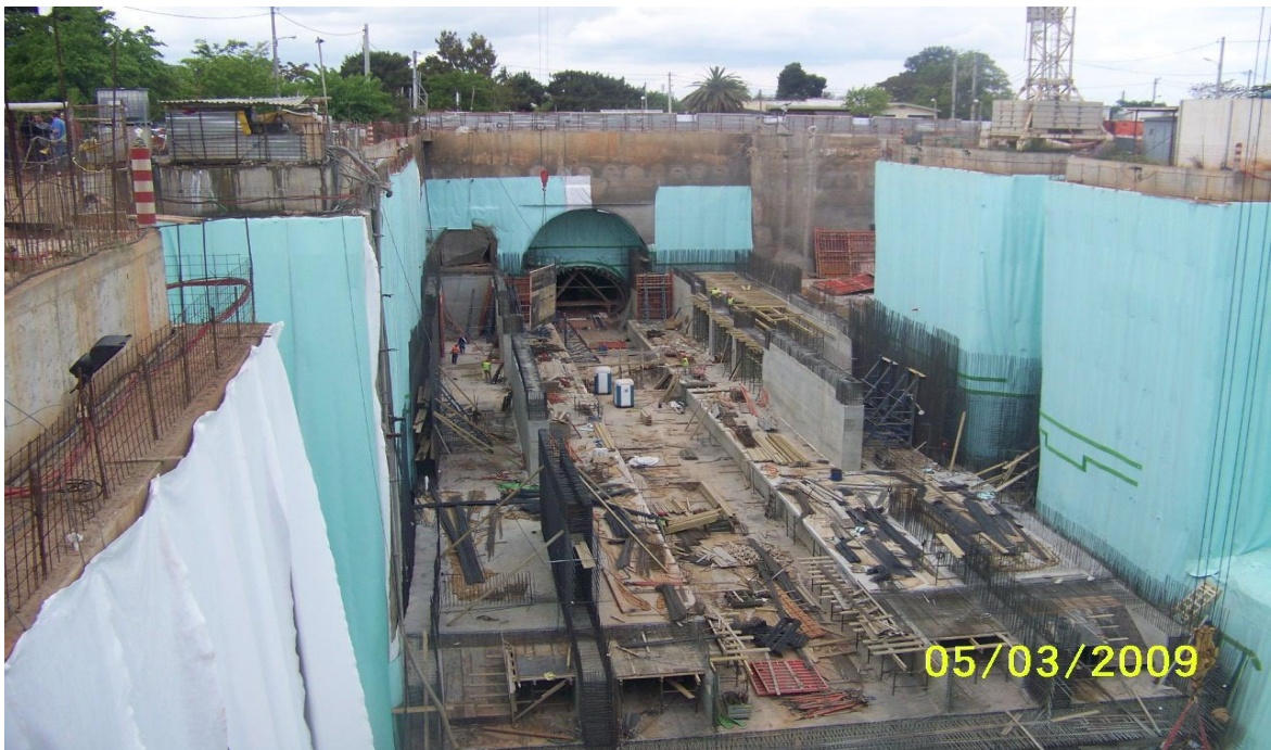
Εικόνα 5.3. Σκυροδέτηση τοιχίων έως το κάτω όριο της πλάκας έκδοσης εισιτηρίων.
