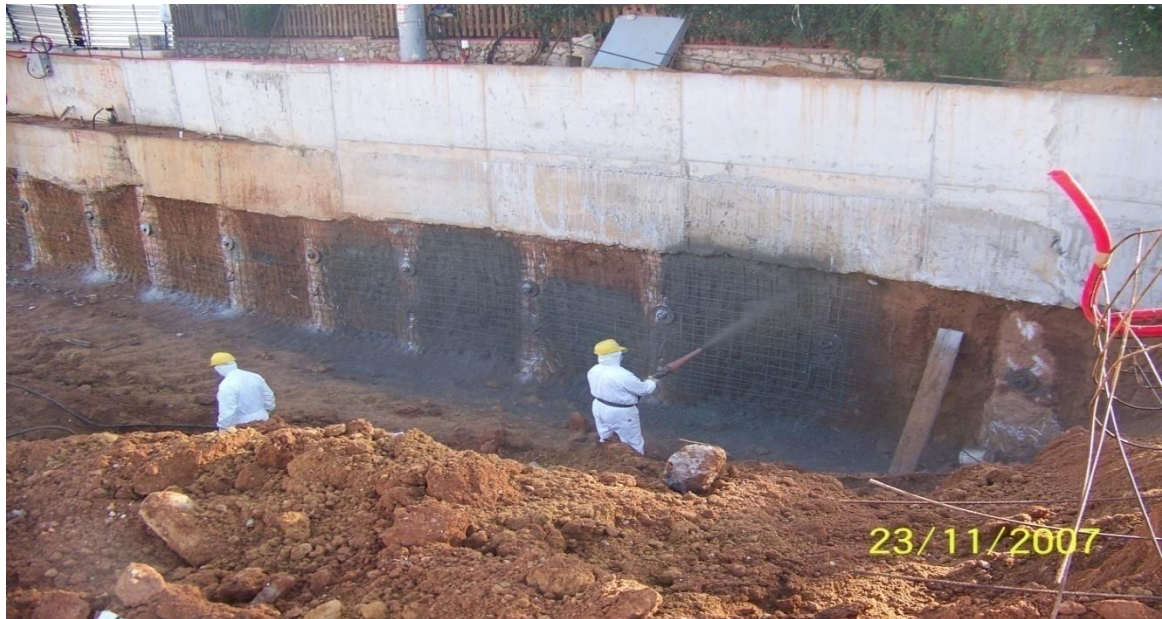
Εικόνα 4.5. Εφαρμογή εκτοξευόμενου σκυροδέματος.
