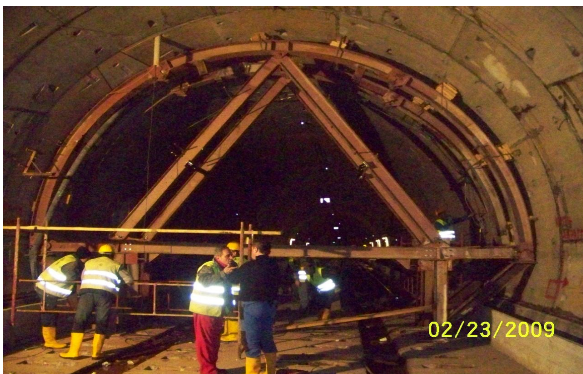
Εικόνα 4.42. Τοποθέτηση μεταλλικών δακτυλίων.
