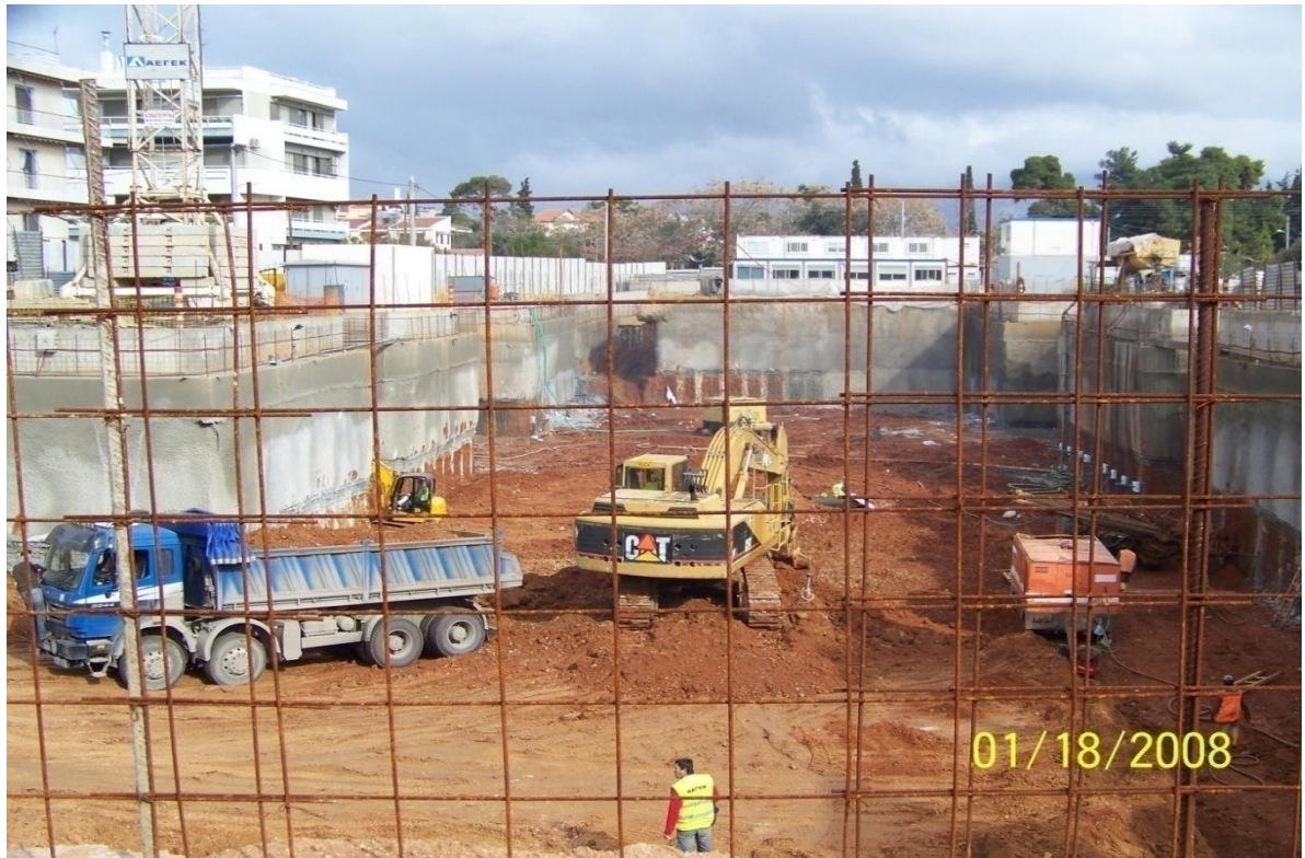
Εικόνα 4.11. 2 η Φάση εκσκαφής
