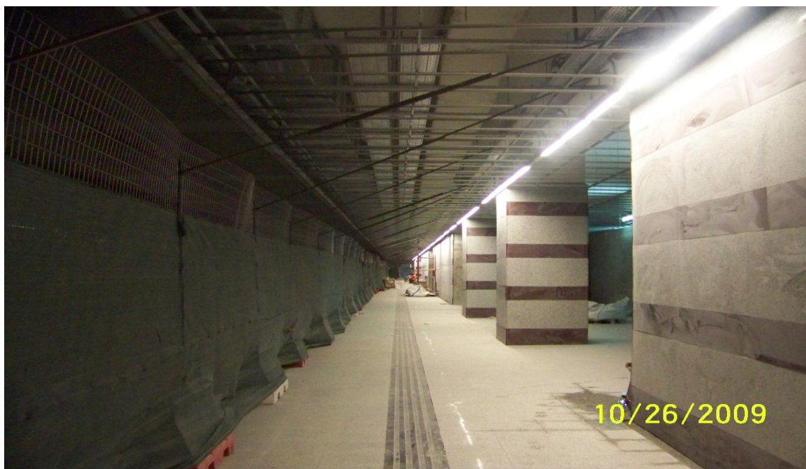
Εικόνα 5.26. Επίπεδο αποβαθρών όπου εμφανίζονται οι αποχρώσεις του γρανίτη σε δάπεδο και κολώνες.
