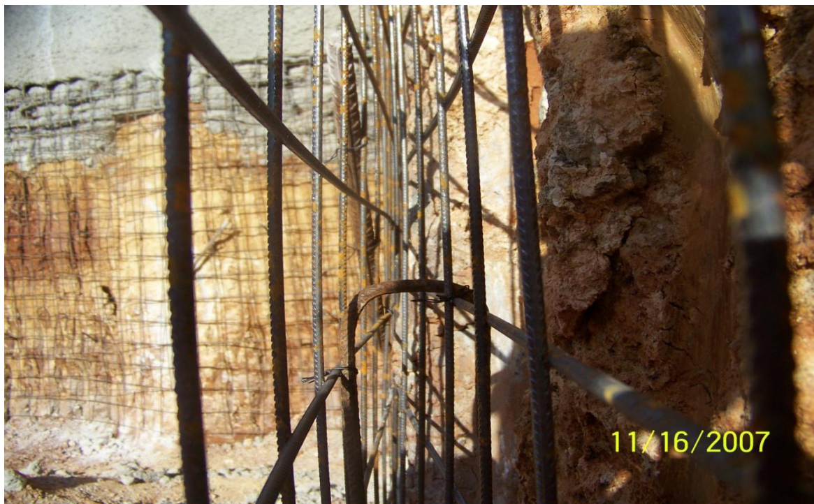
Εικόνα 4.4. Διπλό πλέγμα T188 για τον οπλισμό του τοίχου αντιστήριξης.
