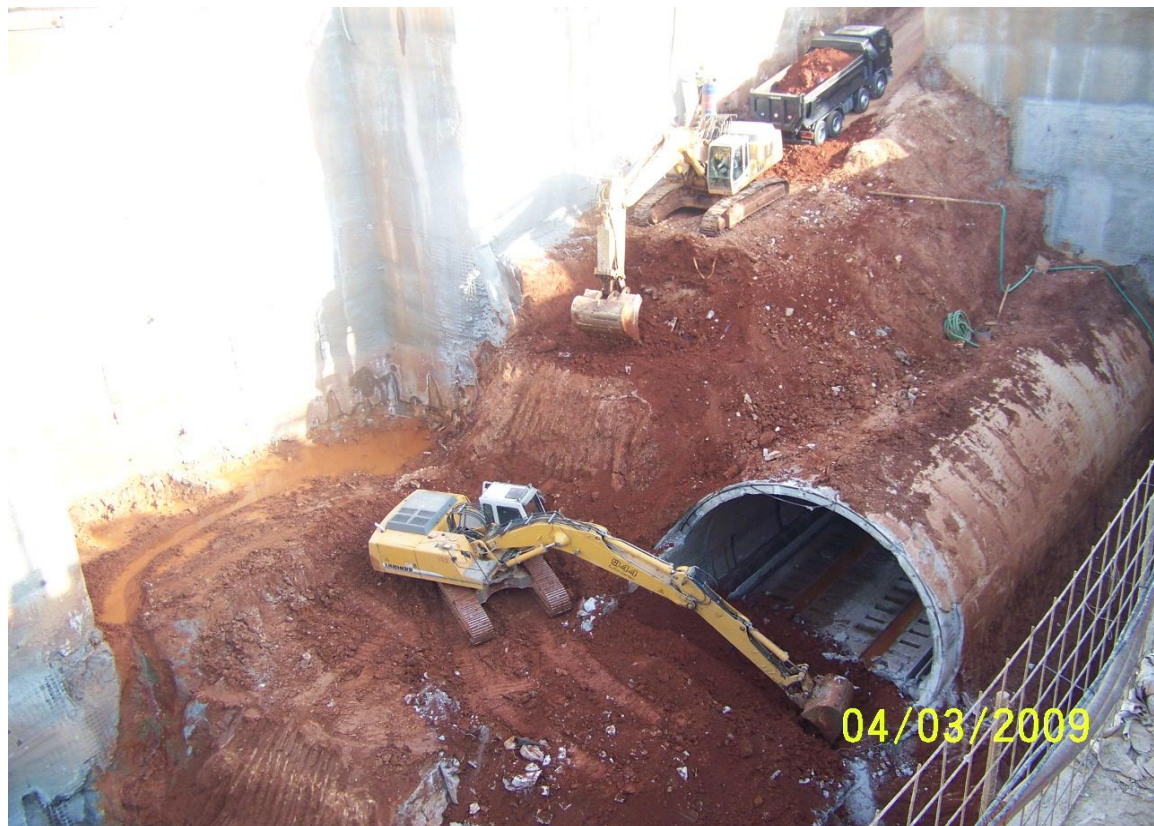
Εικόνα 4.55. Τελευταίο στάδιο καθαίρεσης της σήραγγας.
