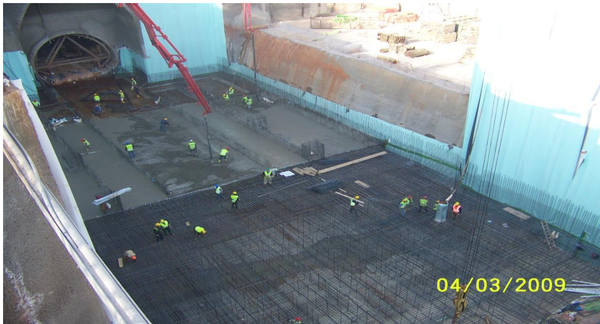
Εικόνα 5.1. Σκυροδέτηση πλάκας πυθμένα
