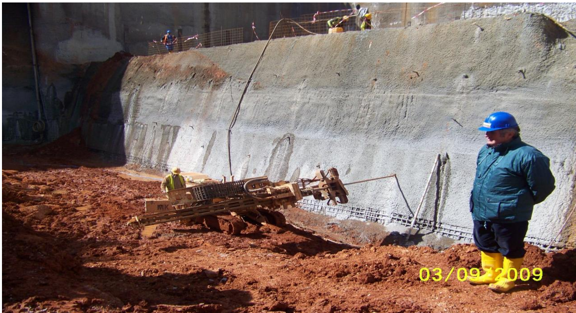
Εικόνα 4.50. Αποστραγγιστικές οπές στη δυτική είσοδο.
