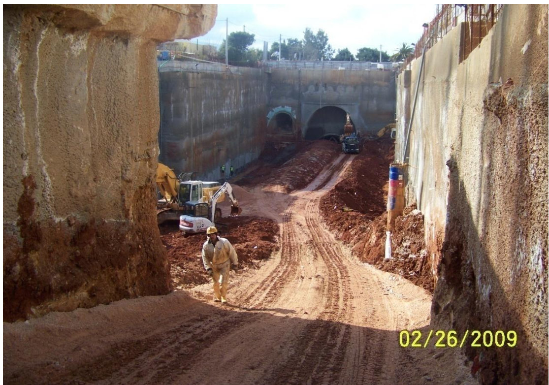
Εικόνα 4.37. Χρησιμοποίηση άνω τμήματος πρίσματος ως διαδρόμου κύλισης φορτηγών κατά τις επόμενες φάσεις.
