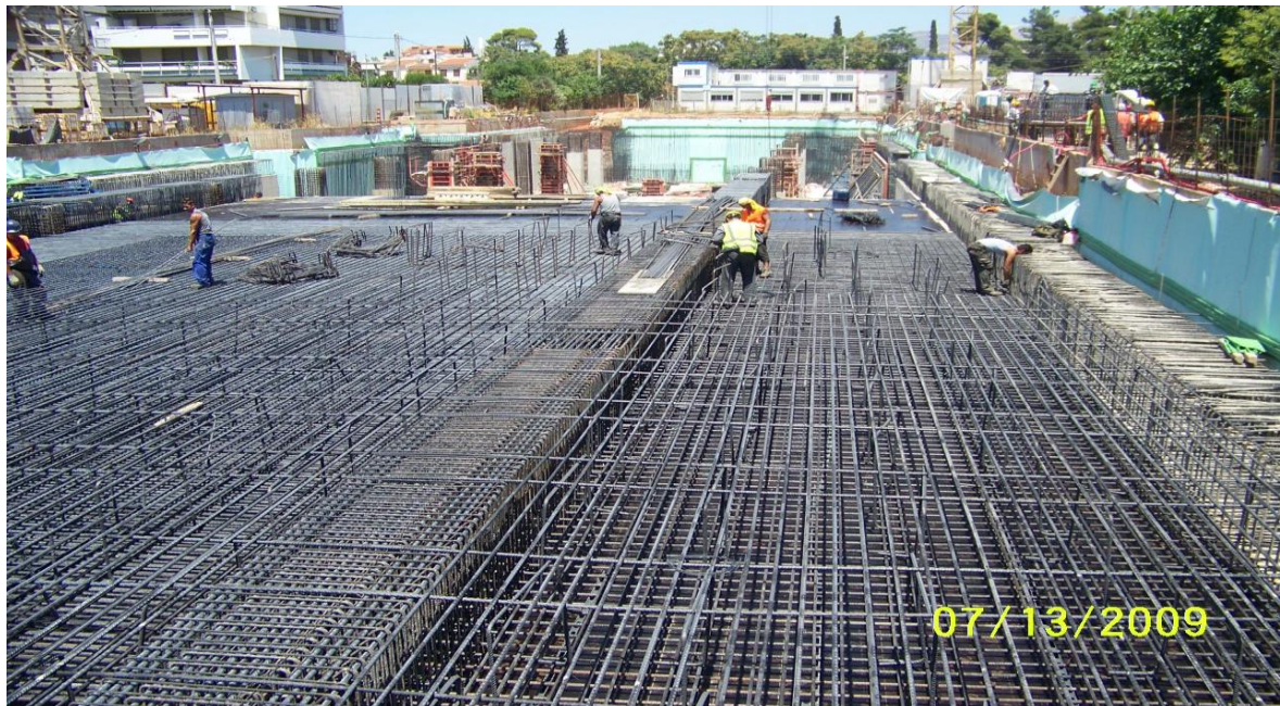
Εικόνα 5.14. Σκυροδέτηση πλάκας οροφής.
