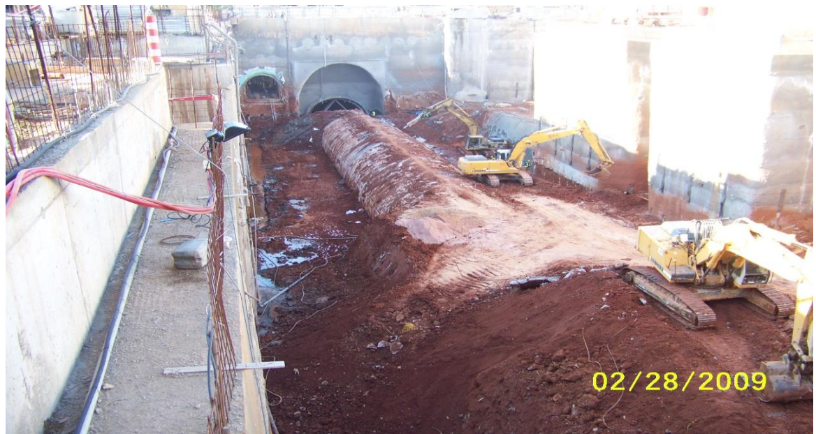
Εικόνα 4.48. Εκσκαφή έως το όριο της υφιστάμενης σήραγγας.
