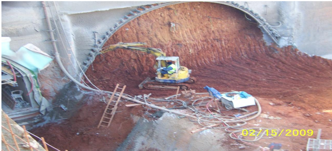
Εικόνα 4.51. Εκκίνηση εκσκαφής Ν.Φ.Ε.
