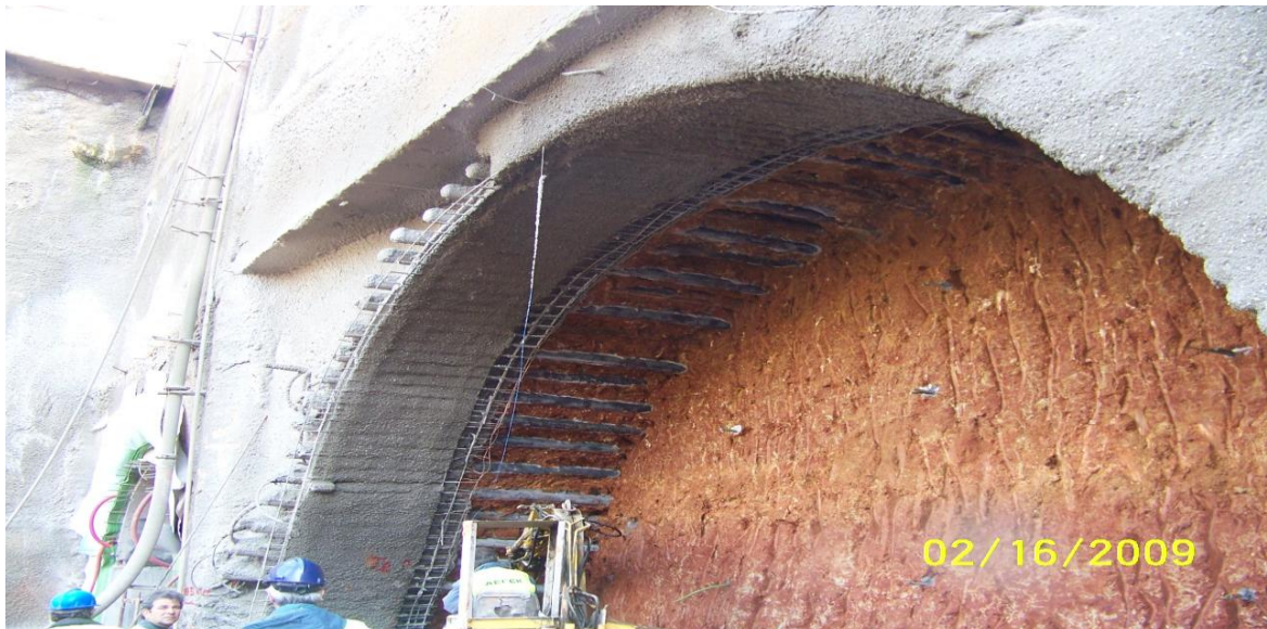
Εικόνα 4.52. 2 ο βήμα Α' φάσης για την κατασκευή του Ν.Φ.Ε.
