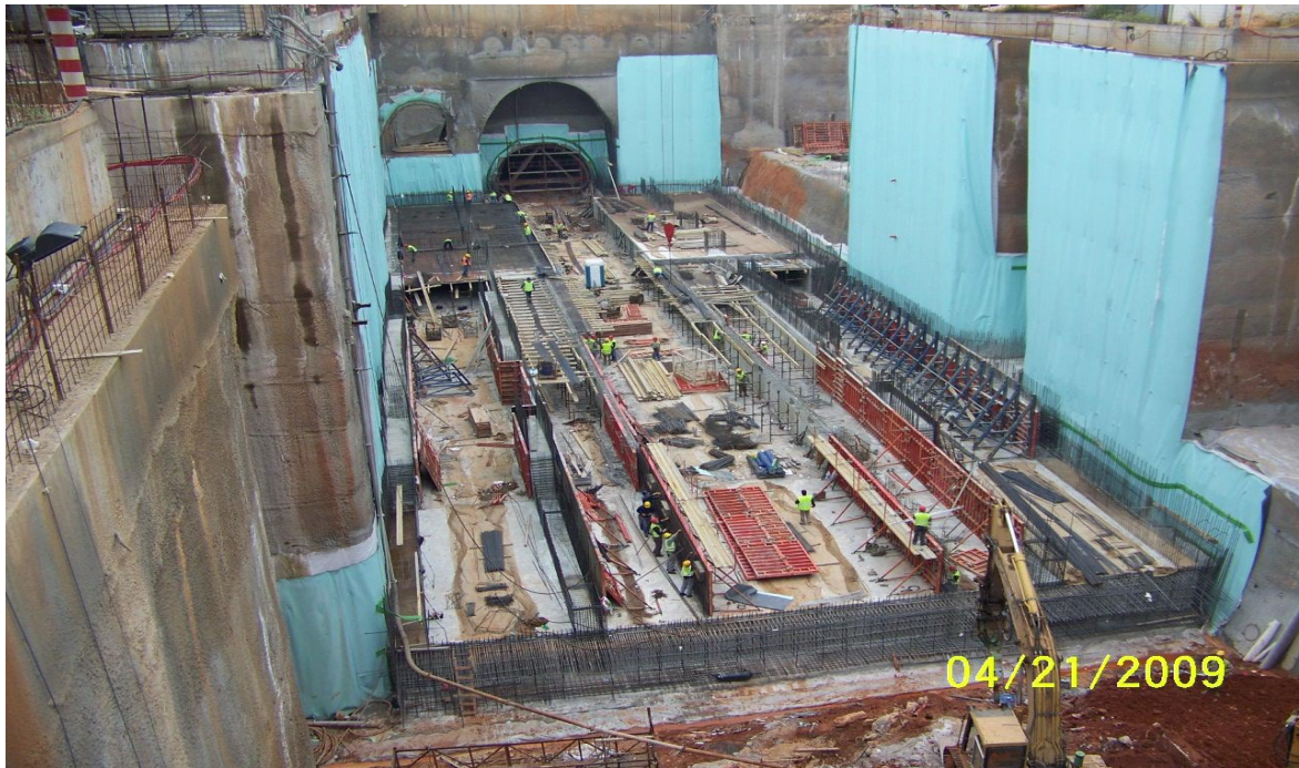
Εικόνα 5.2. Σκυροδέτηση τοιχίων και πλακών αποβάθρων στο επίπεδο των αποβάθρων.
