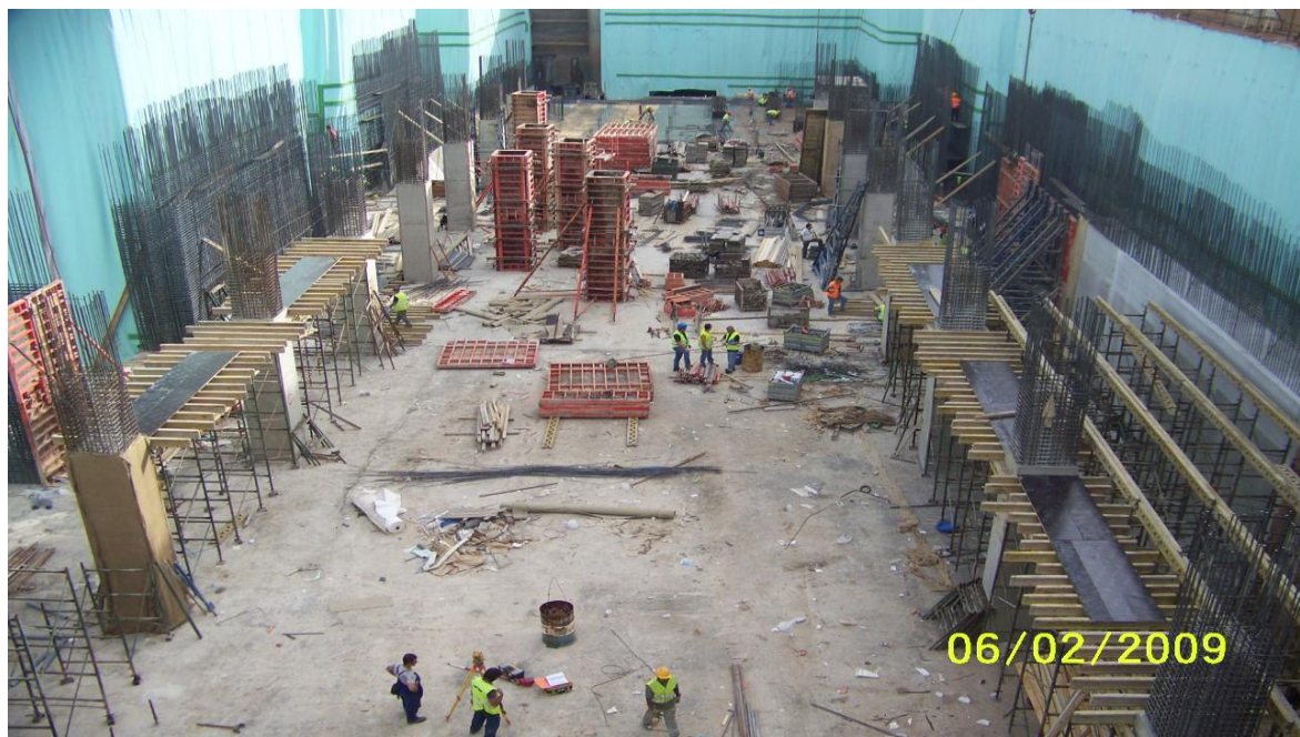
Εικόνα 5.9. Σκυροδέτηση τοιχείων και υποστυλωμάτων ορόφου (-2).
