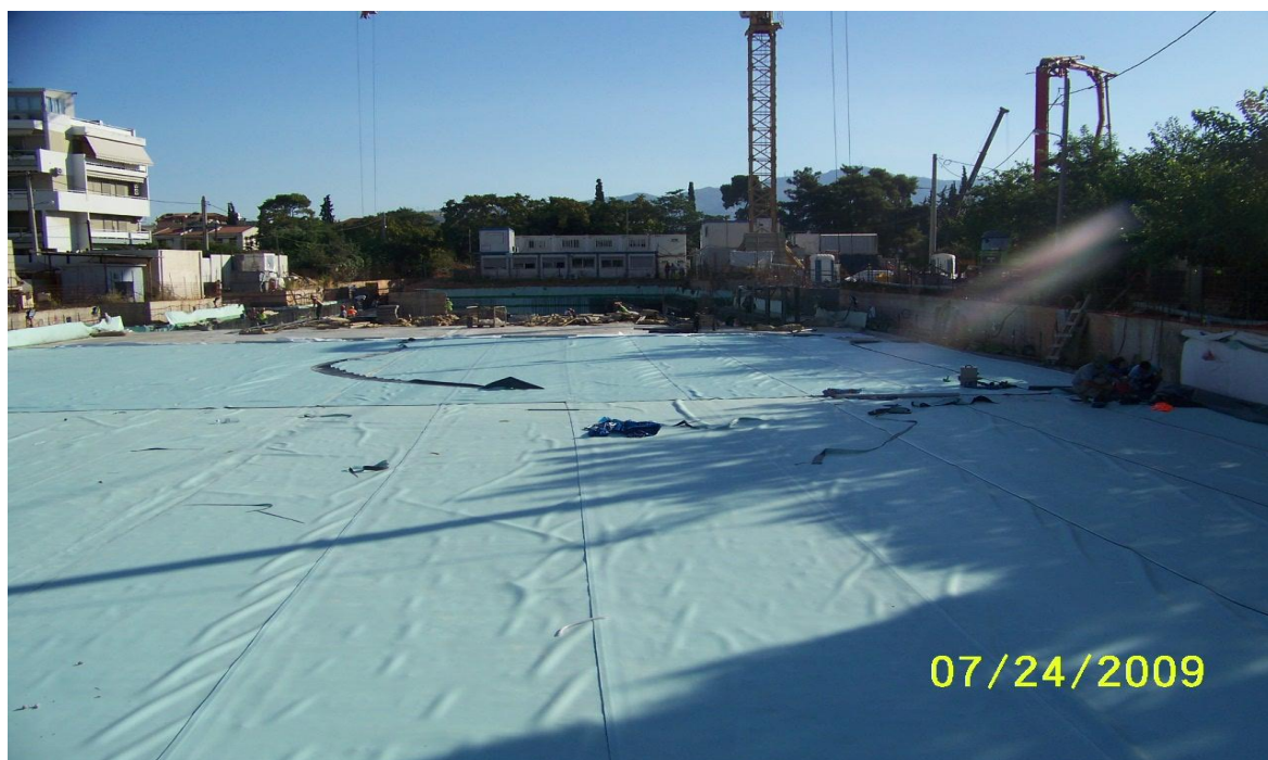
Εικόνα 5.15. Στεγάνωση πλάκας οροφής.
