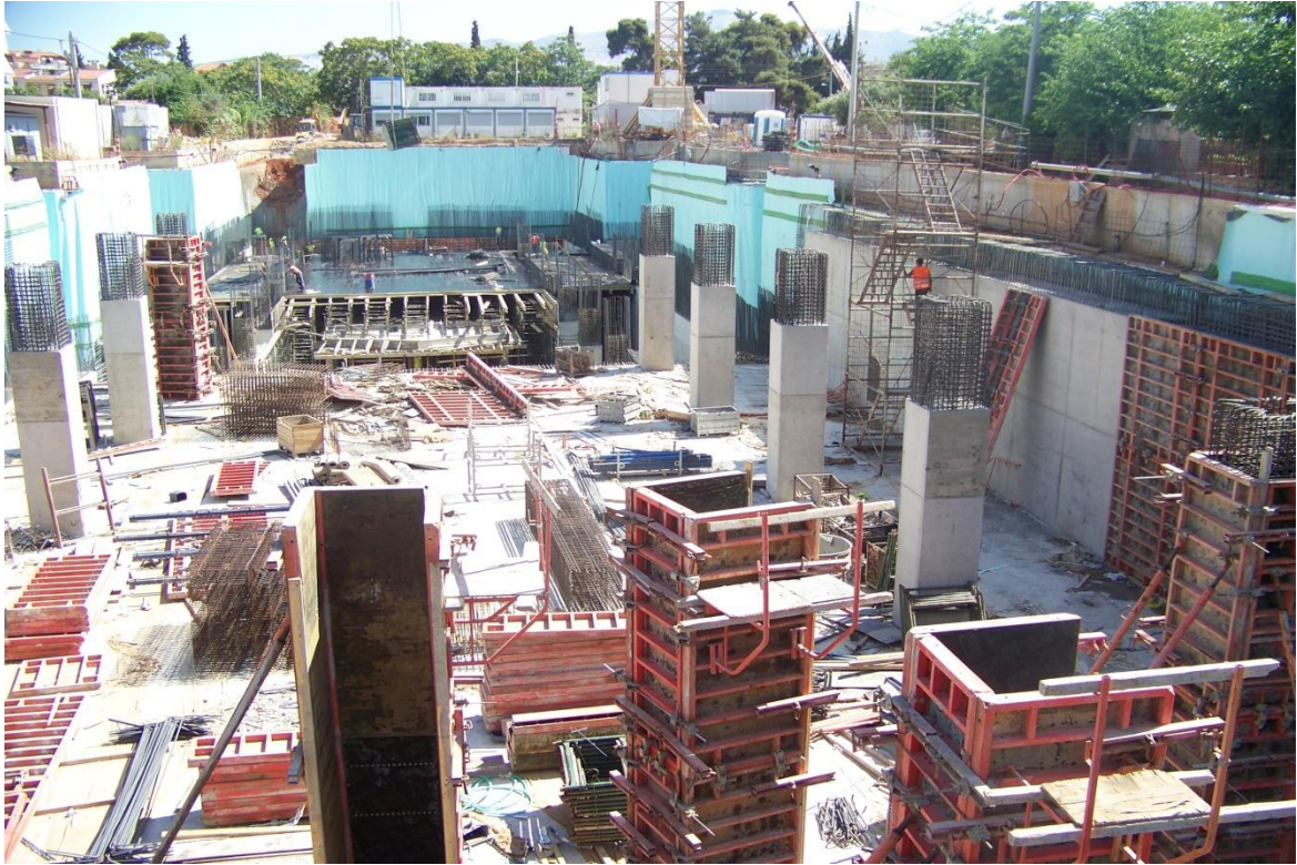
Εικόνα 5.13. Σκυροδέτηση τοιχείων και υποστηλωμάτων του ορόφου (-1).
