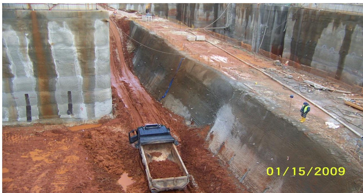
Εικόνα 4.39. Τελικό στάδιο εκσκαφής δυτικής εισόδου
