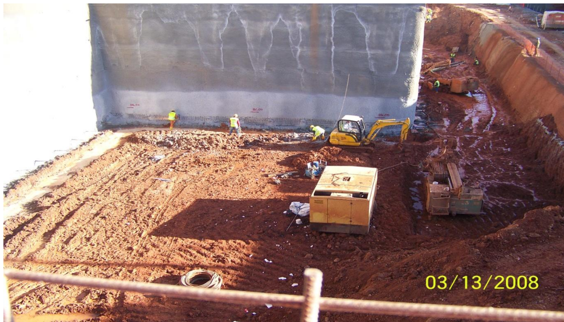
Εικόνα 4.20. Εκσκαφή στο τμήμα της δυτικής εισόδου
