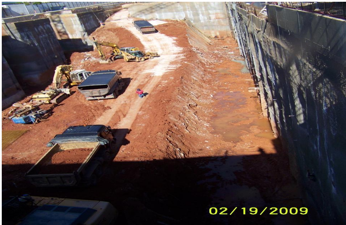
Εικόνα 4.36. Άνω τμήμα ως διάδρομος κύλισης κατά τις αρχικές φάσεις εκσκαφής.
