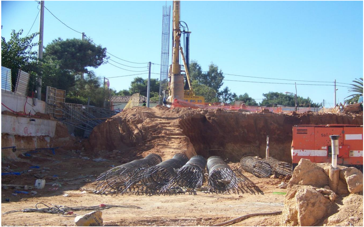
Εικόνα 4.1. Διάτρηση πασσάλων και σωροί οπλισμός πασσάλων,
