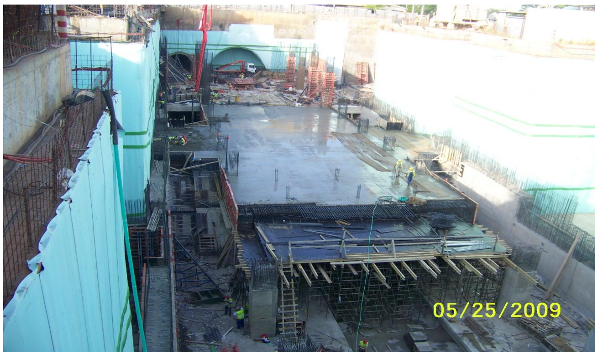
Εικόνα 5.5. Κατασκευή πλάκας έκδοσης εισιτηρίων Β' τμήμα.
