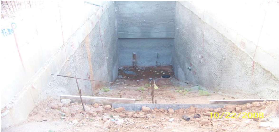
Εικόνα 4.31. Συναρμογή cut and cover με σήραγγα NATM νότιας εισόδου,
