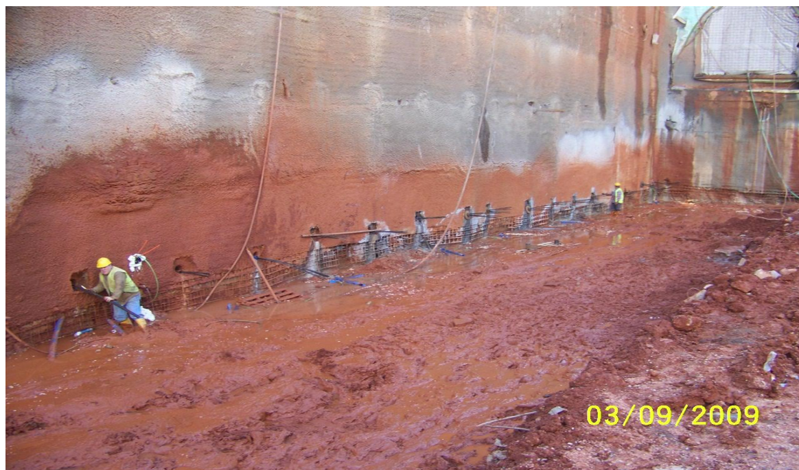
Εικόνα 4.44. Εκσκαφή 6 ης φάσης στην ανατολική πλευρά (τμήμα 1).
