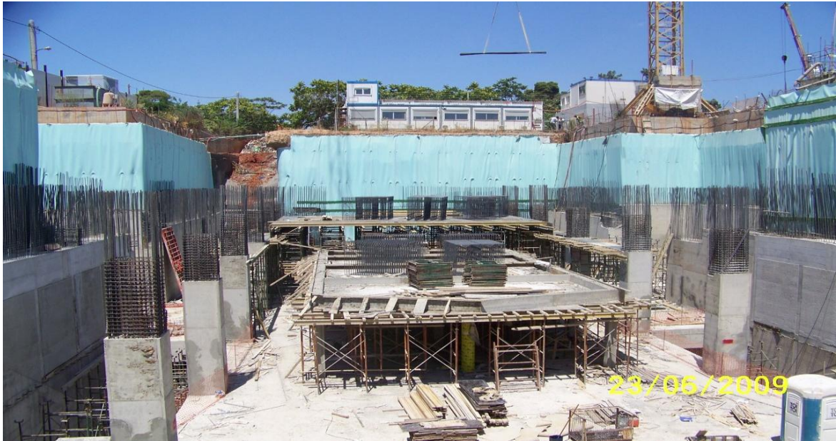
Εικόνα 5.10. Ολοκλήρωση της σκυροδέτησης των τοιχίων και υποστυλωμάτων στον όροφο (-2).
