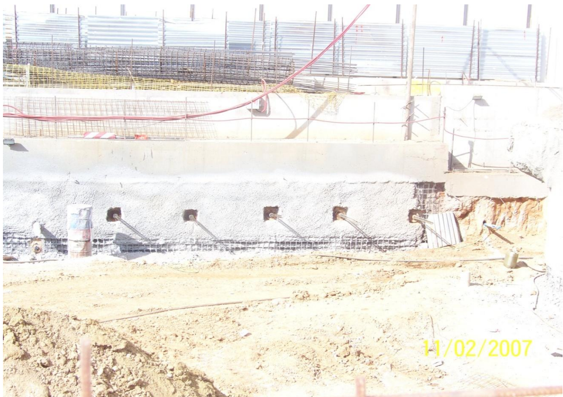
Εικόνα 4.3. Κεφαλόδεσμος και πρώτη σειρά αγκυρίων.
