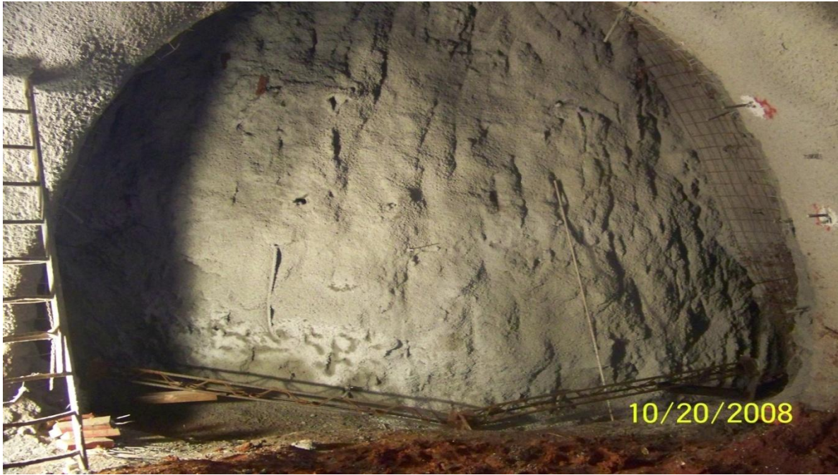
Εικόνα 4.26. «Αστάρωμα» μετώπου Α' σταδίου.
