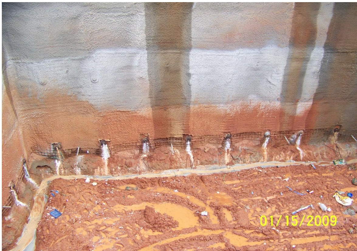
Εικόνα 4.35. Κατασκευή 4 ης σειράς αγκυρίων στη δυτική πλευρά (τμήμα 2).
