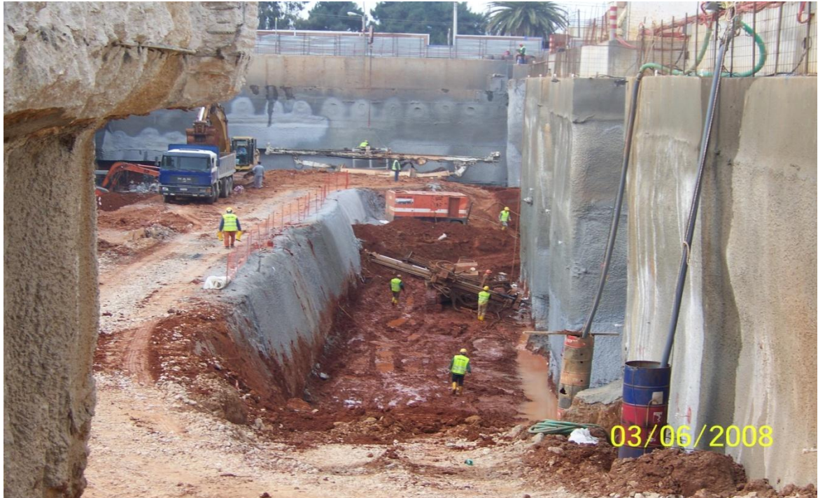
Εικόνα 4.16. Εκσκαφή 3 ης φάσης στη δυτική πλευρά (τμήμα 2).
