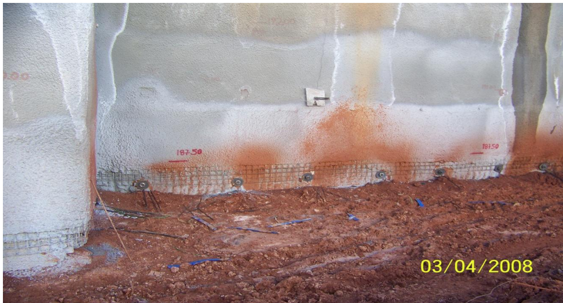
Εικόνα 4.15. Κατασκευή 3 ης σειράς αγκυριών στην ανατολική πλευρά (το τμήμα 1).
