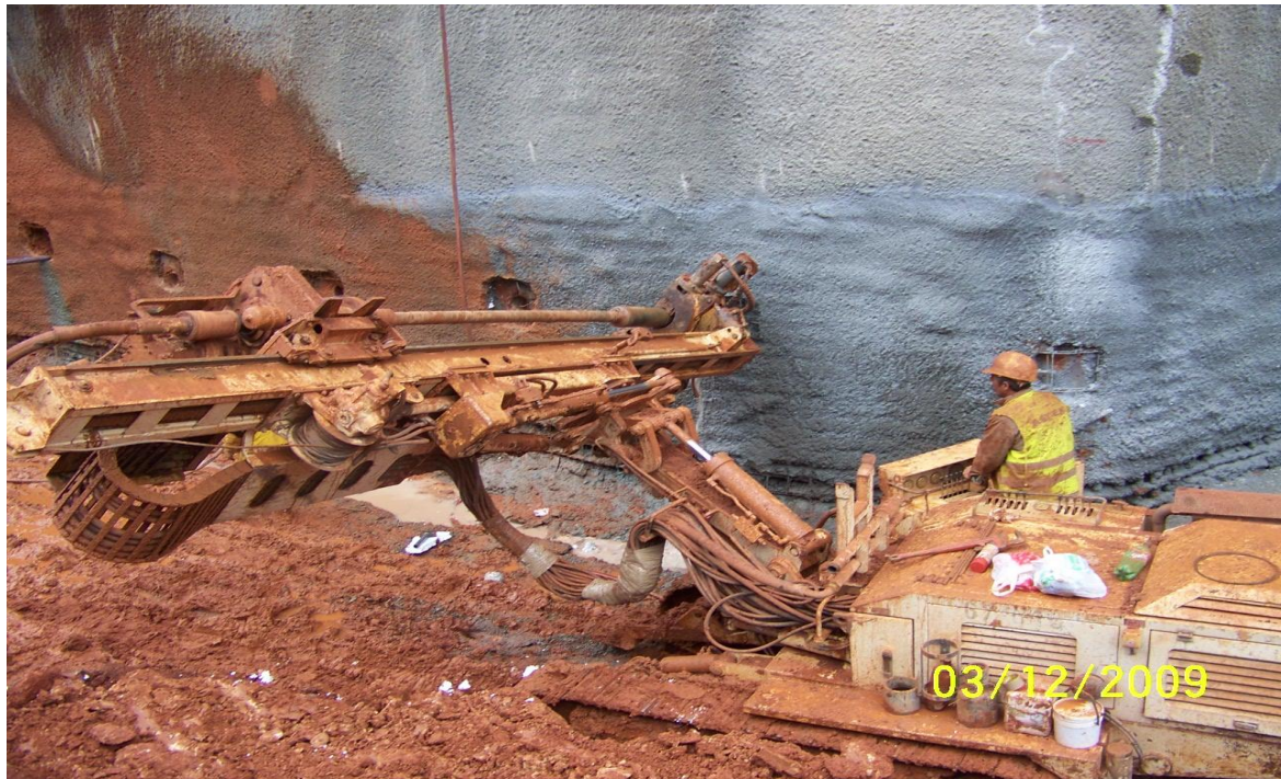
Εικόνα 4.8. Διάτρηση οπών.
