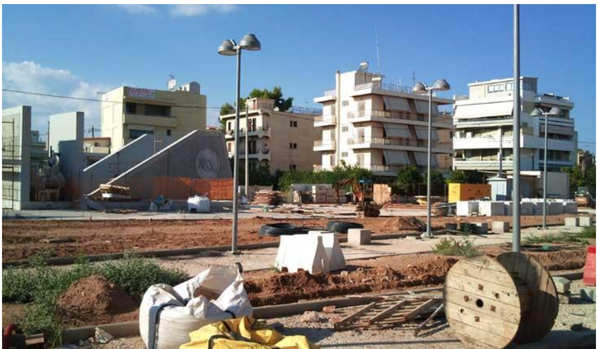
Εικόνα 5.29. Κατασκευή παρτεριών στο περιβάλλοντα χώρο.
