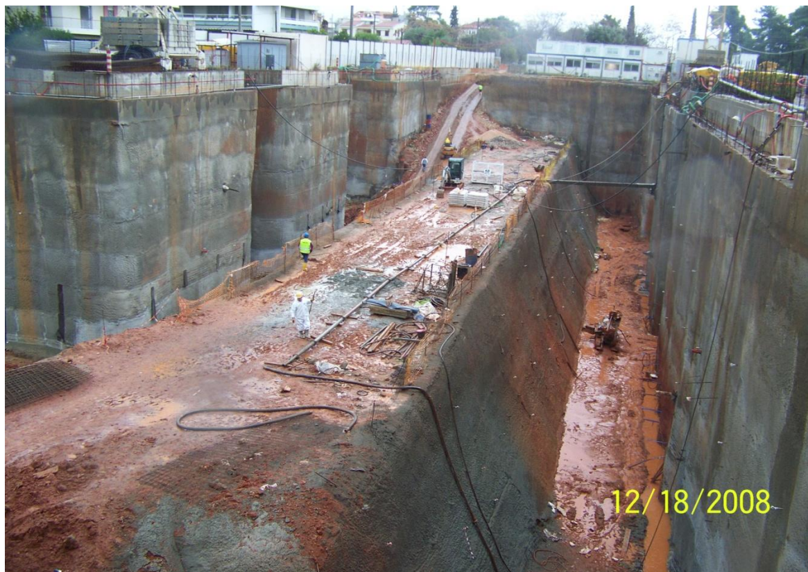
Εικόνα 4.33 Εκσκαφή 5 ης φάσης και κατασκευής 5 ης φάσης αγκυρίων στην ανατολική πλευρά.
