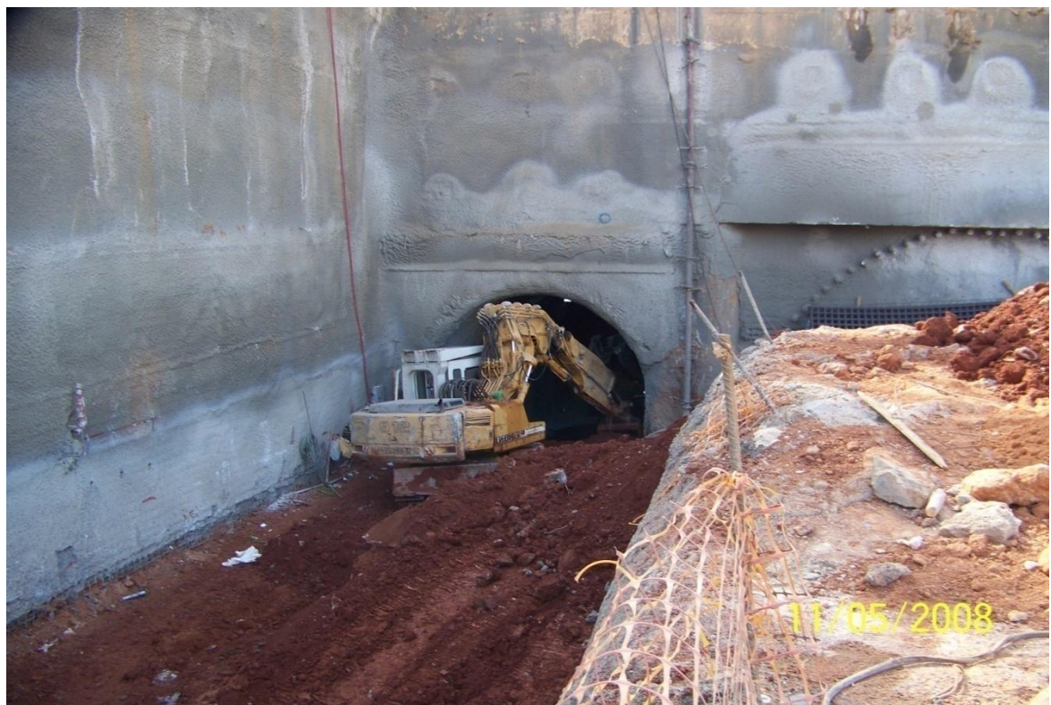
Εικόνα 4.22. Έναρξη εργασιών Α' φάσης.
