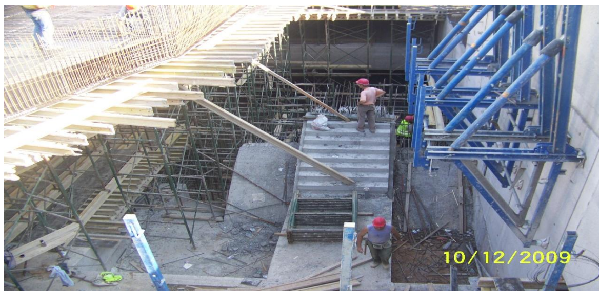
Εικόνα 5.16. Σκυροδέτηση σκάλων που είχαν παραληφθεί.
