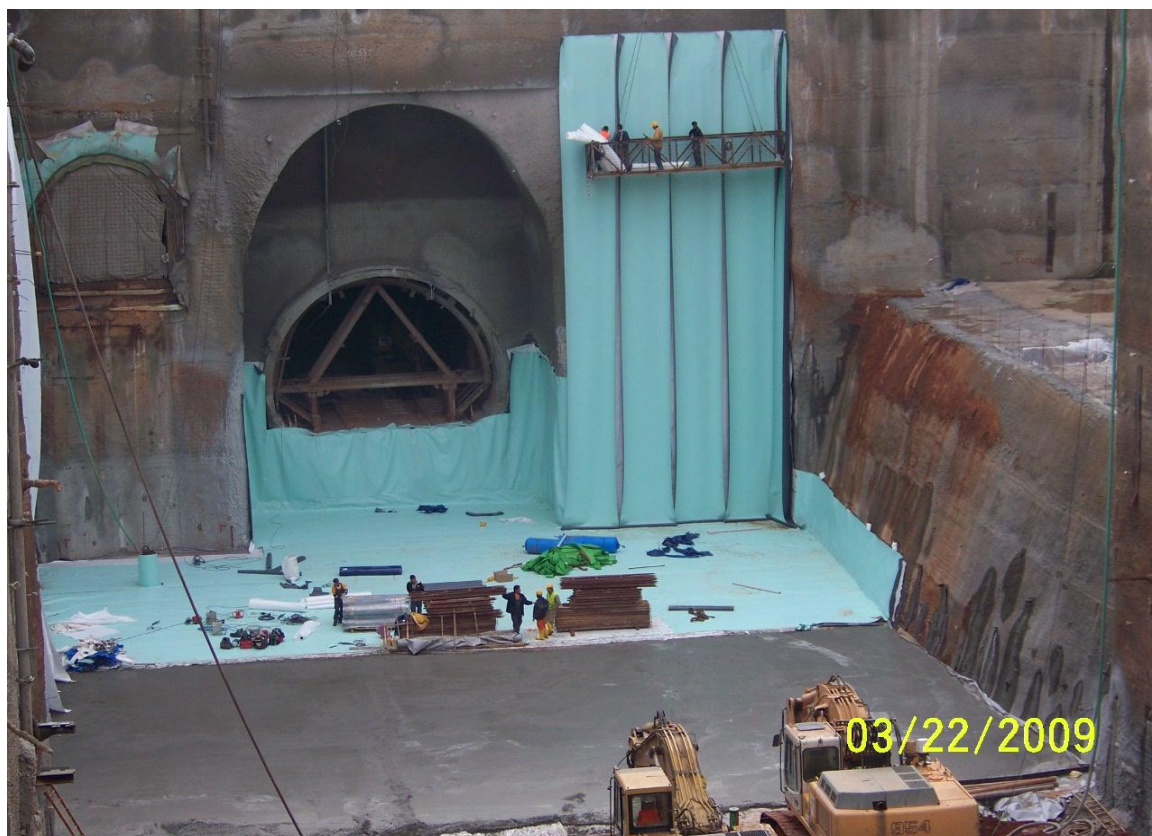
Εικόνα 4.61. Τοποθέτηση μεμβρανών υδατοστεγάνωσης στα τοιχία του ορύγματος.
