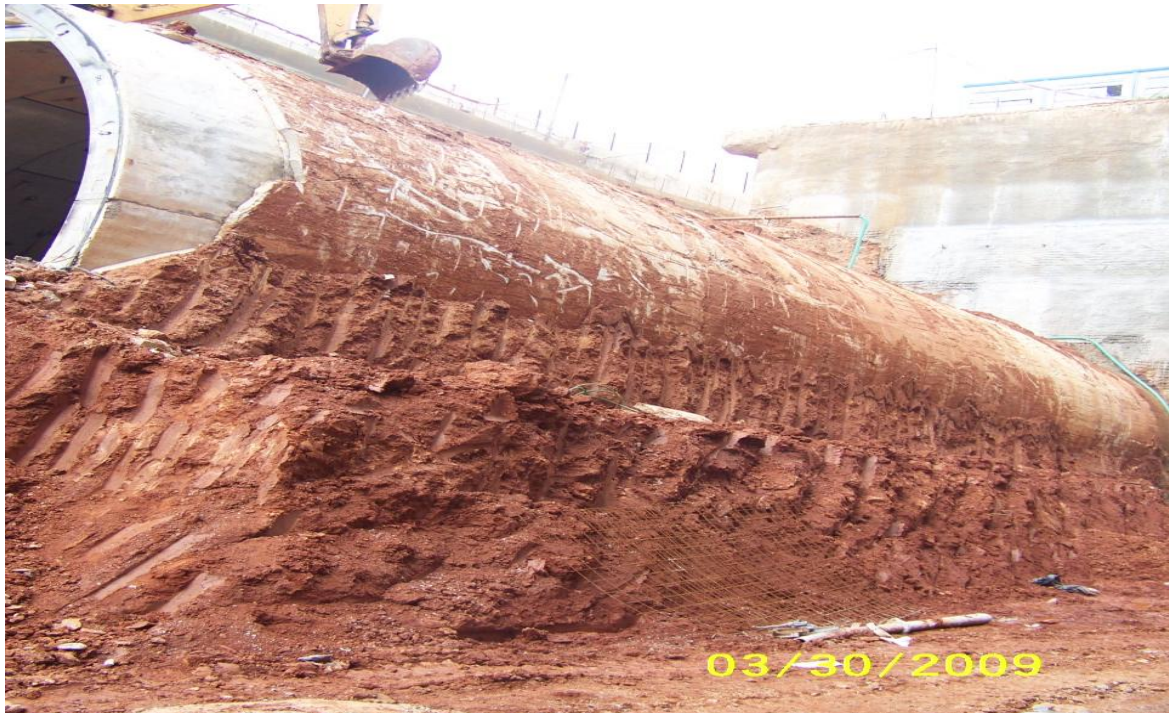
Εικόνα 4.56. Κάτω μέρος υφιστάμενης σήραγγας.
