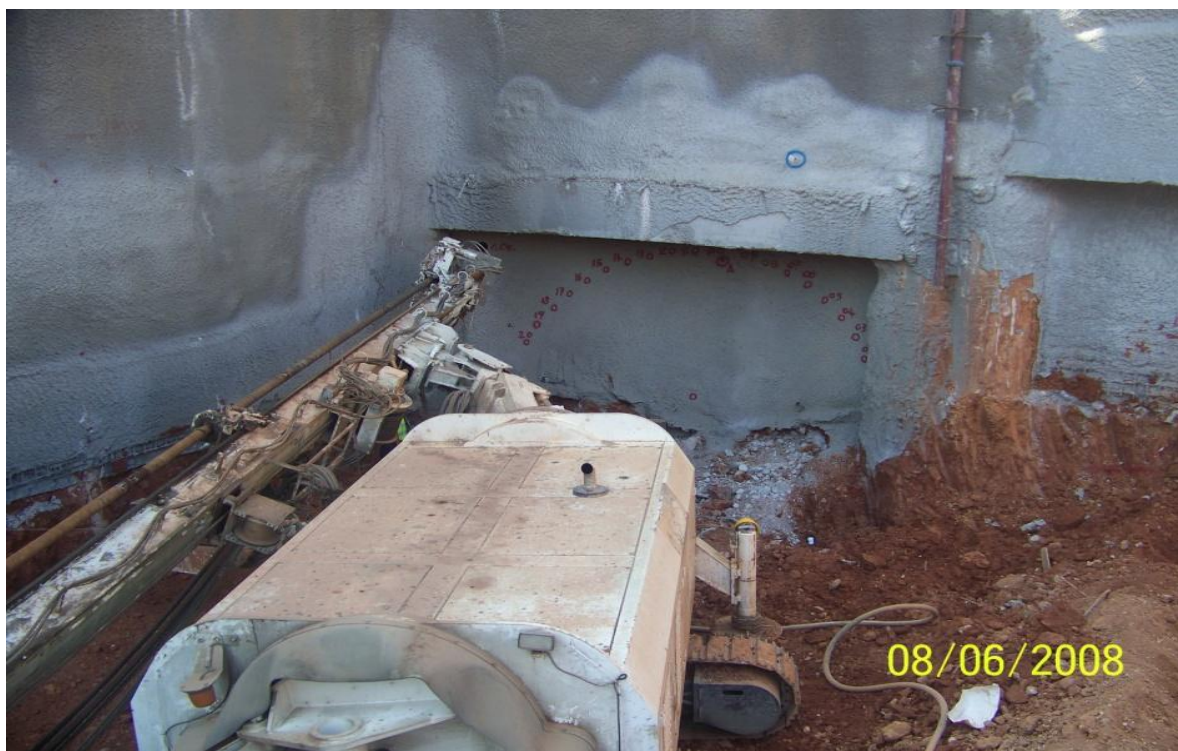
Εικόνα 4.23.Υδραυλικό διατρητικό μηχάνημα για τη διάτρηση των οπών των δοκών προπορείας.
