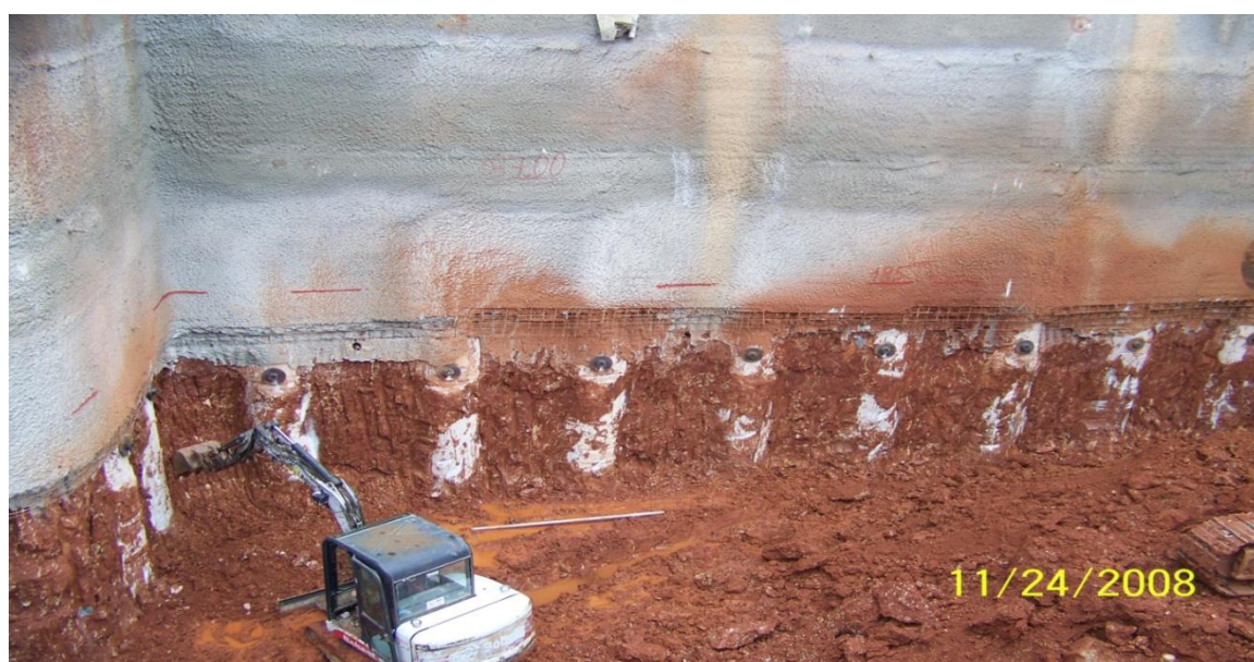
Εικόνα 4.28. Κατασκευή 4 ης σειράς αγκυριών στην ανατολική πλευρά (τμήμα 1).
