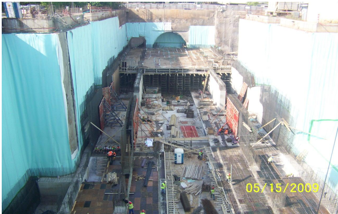
Εικόνα 5.4. Κατασκευή πλάκας του επιπέδου έκδοσης εισιτηρίων.
