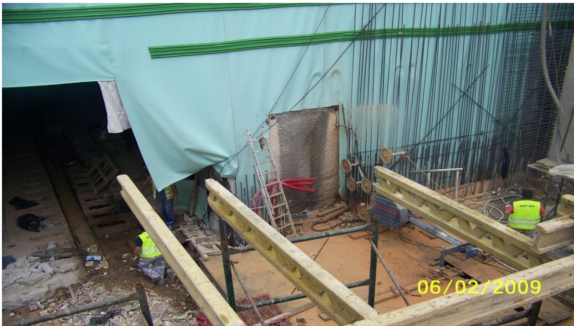
Εικόνα 5.17. Δημιουργία ανοίγματος στο επίπεδο -3 για τη σύνδεση με το υπάρχον φρέαρ με τη μέθοδο της συρματοκοπής στην ανατολική πλευρά.
