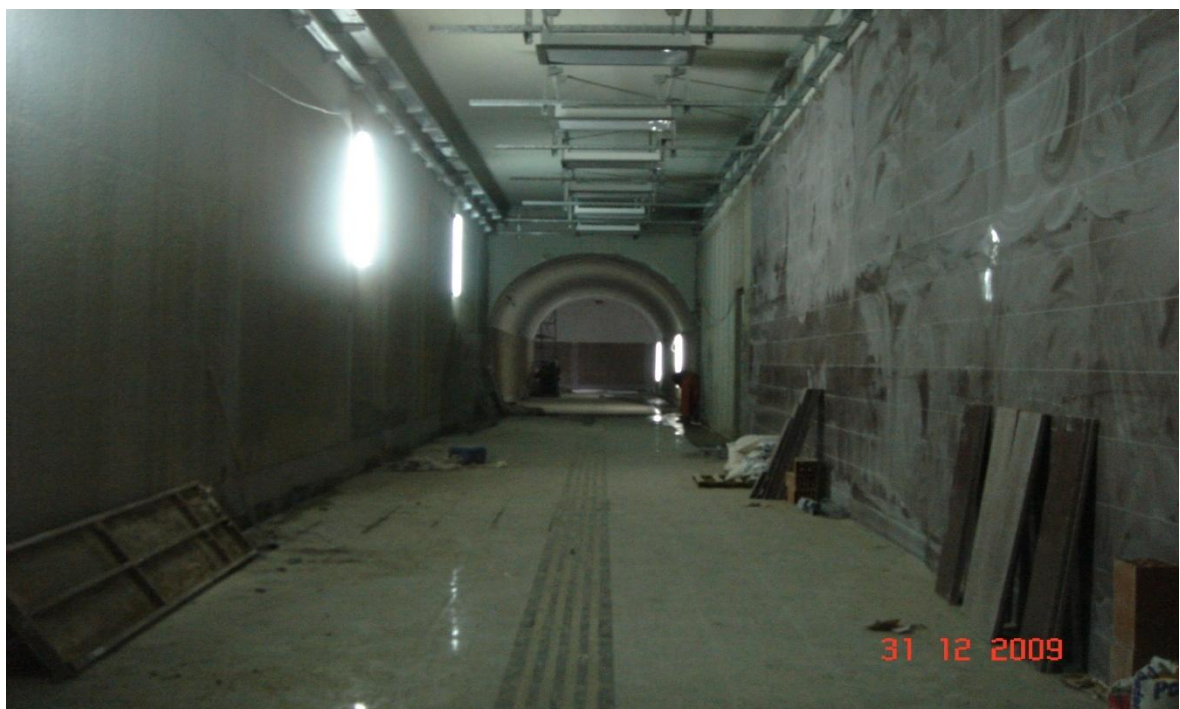
Εικόνα 5.20. Σήραγγα που περνάει κάτω από την οδό της αγία Παρασκευής και κατασκευάστηκε με τη μέθοδο της NATM.
