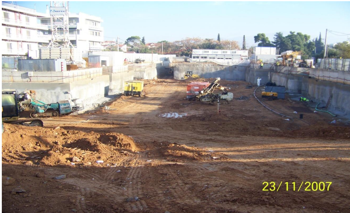
Εικόνα 4.7. Ολοκλήρωση 1 ης φάσης εκσκαφής.
