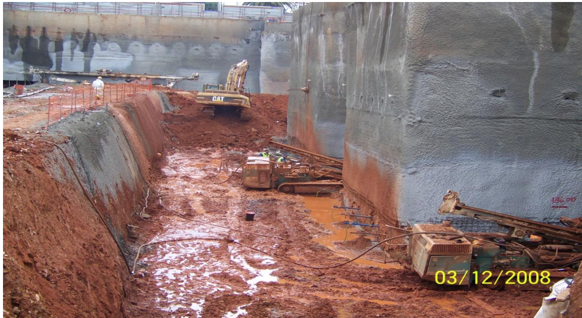
Εικόνα 4.14. Εκσκαφή 3 ης φάσης στην ανατολική πλευρά (τμήμα 1).
