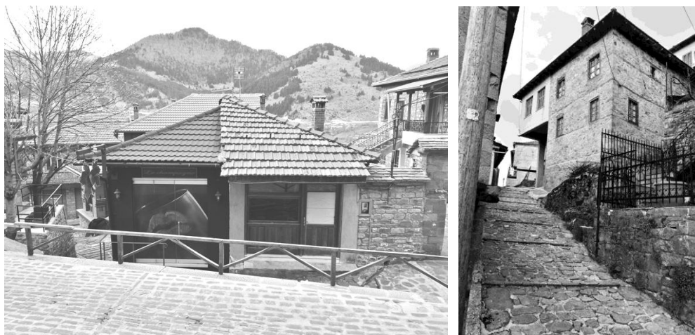
Εικόνα 18: Αριστερά: Διαφορετική επιλογή επικάλυψης στέγης για το ίδιο κέλυφος. Η δυνατότητα δόθηκε χάριν στο ιδιοκτησιακό καθεστώς. Το τελικό αποτέλεσμα της όψης του κελύφους είναι τελείως ασύνδετο με το περιβάλλον. Δεξιά: Προσθήκη κατ' επέκταση σε υφιστάμενο κτίσμα στον δεύτερο όροφο και επιλογή αντιστήριξης με υπερβολικά ψηλά δομικό στοιχείο.
