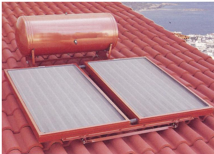
Εικόνα 20: Χρήση χρωματισμού στο σύστημα ηλιακού θερμοσίφωνα σε κεραμοσκεπή.
