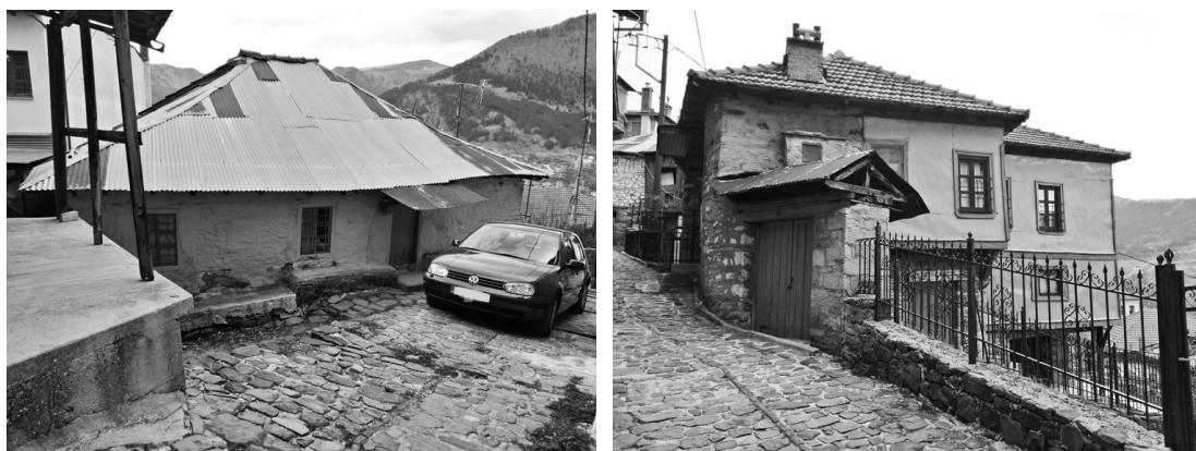
Εικόνα 17: Αριστερά: Στέγη με επικάλυψη από λαμαρίνα σε γκρί χρώμα, Δεξιά: Παλαιά κατοικία με τοίχο καλυμμένο με λαμαρίνα για μόνωση.
