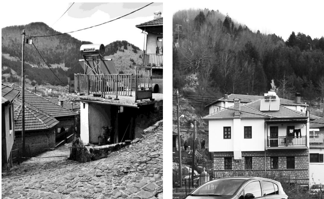
Εικόνα 14: Αριστερά: Τοποθέτηση μεταλλικής κατασκευής στον ακάλυπτο χώρο κατοικίας στο Μέτσοβο με οπτική από κοινόχρηστο δρόμο, Δεξιά: Τοποθέτηση δεξαμενής αποθήκευσης ζεστού νερού σε κεραμοσκεπή σε κατοικία του Μετσόβου.
