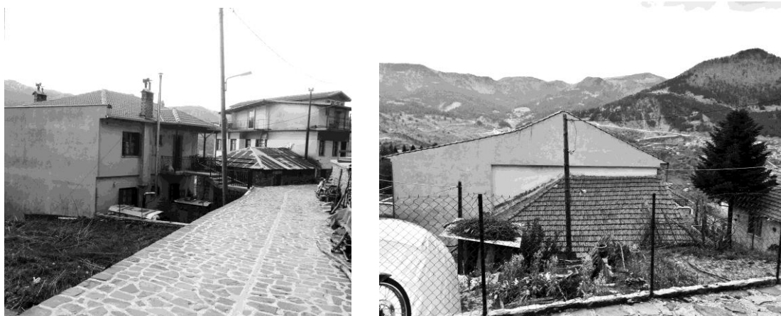
Εικόνα 15: Εφαρμογή άρθρου 14 (θέση κτιρίου και εγκαταστάσεων) του ΝΟΚ 4067/ 2012 περί εφαρμογής του κτιρίου στο όριο του οικοπέδου δίχως την δυνατότητα κατασκευής αστράχας και την δημιουργία 'τυφλών' τοίχων.
