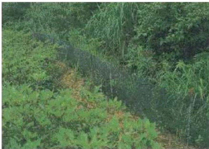
Εικόνα 36: Τοποθέτηση ειδικών φρακτών για την περίφραξη του έργου.
