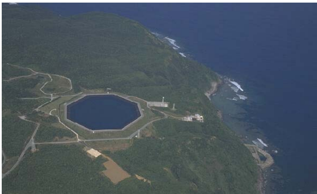
Εικόνα 16: Αεροφωτογραφία του έργου. Διακρίνεται η υδροληψία, ο άνω ταμιευτήρας και οι οδοί προσπέλασης.
