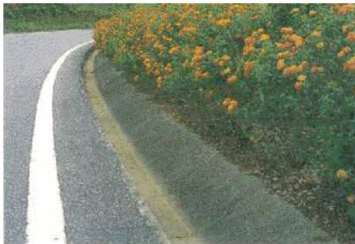
Εικόνα 37: Επικλινές τοίχωμα παραπλεύρως του δρόμου.
