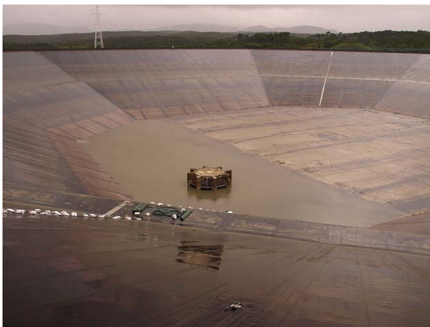
Εικόνα 23: Φωτογραφία του άνω ταμιευτήρα με μηδενική πλήρωση. Διακρίνεται το είδος της υδροληψίας.
