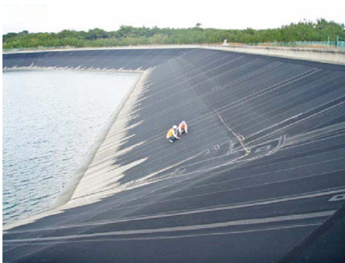
Εικόνα 22: Φωτογραφία του άνω ταμιευτήρα κατά την ολοκλήρωση της κατασκευής του.
