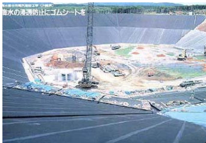
Εικόνα 20: Κατασκευή του άνω ταμιευτήρα.
