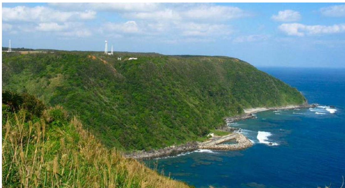
Εικόνα 29: Φωτογραφία του έργου όπου διακρίνεται η γραμμή διασύνδεσης.
