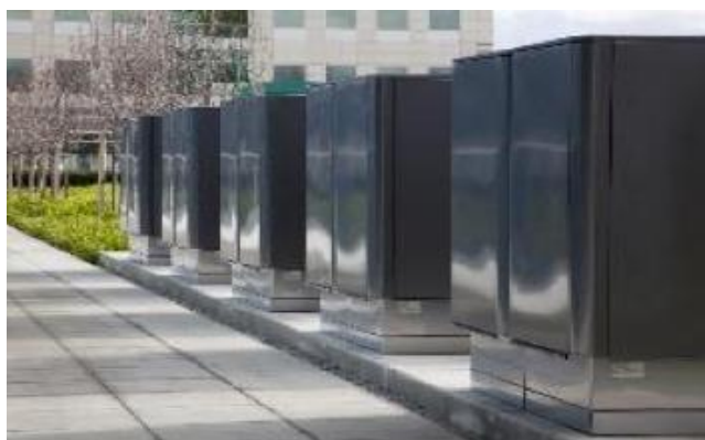
Εικόνα 4.8: Κυψελίδες καυσίμου στερεού οξειδίου στις εγκαταστάσεις της NASA (89)
