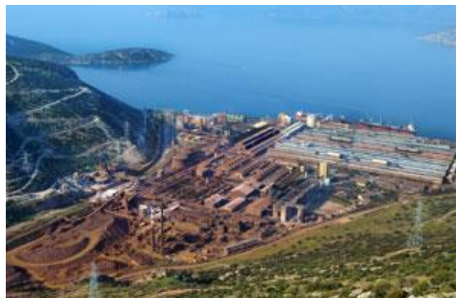
Εικόνα 3.5: Εγκαταστάσεις της ελληνικής βιομηχανίας αλουμινίου ‘ΜΥΤΙΛΗΝΑΙΟΣ Α.Ε.’ (57)
