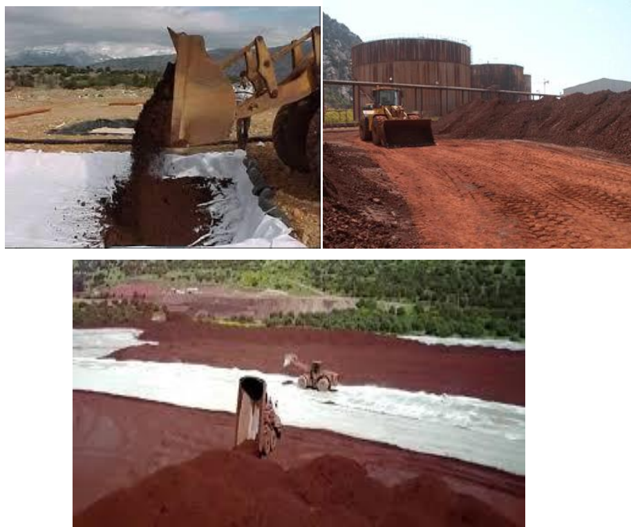
Εικόνα 3.2: Στεγανή στοίβαξη ερυθράς ιλύος στο χώρο απόθεσης (55)
