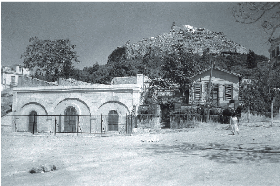
Εικόνα 8: Αδριάνειος Δεξαμενή στο Κολωνάκι, έτος 1936 (Πηγή: ΕΥΔΑΠ)
