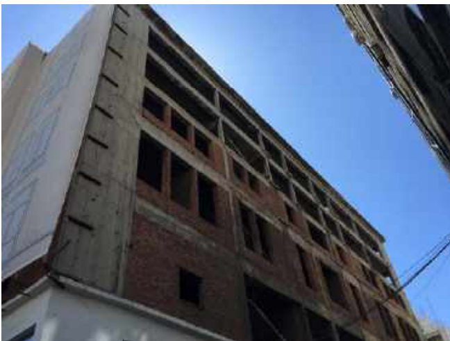
Εικόνα 1.16: Πλήρωση εξωτερικών τοιχών από οπτοπλινθοδομή (όψη οδού Κολοκοτρώνη).
