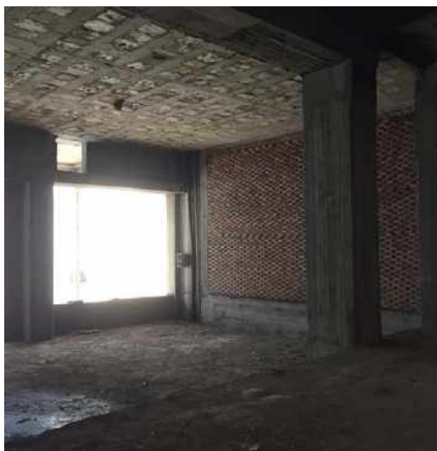
Εικόνες 1.9 & 1.10: Εσωτερικός χώρος ισόγειου από τη λεωφόρο Ηρώων Πολυτεχνείου. Διαχωρισμός χώρων με σποκπλινθοδομή.
