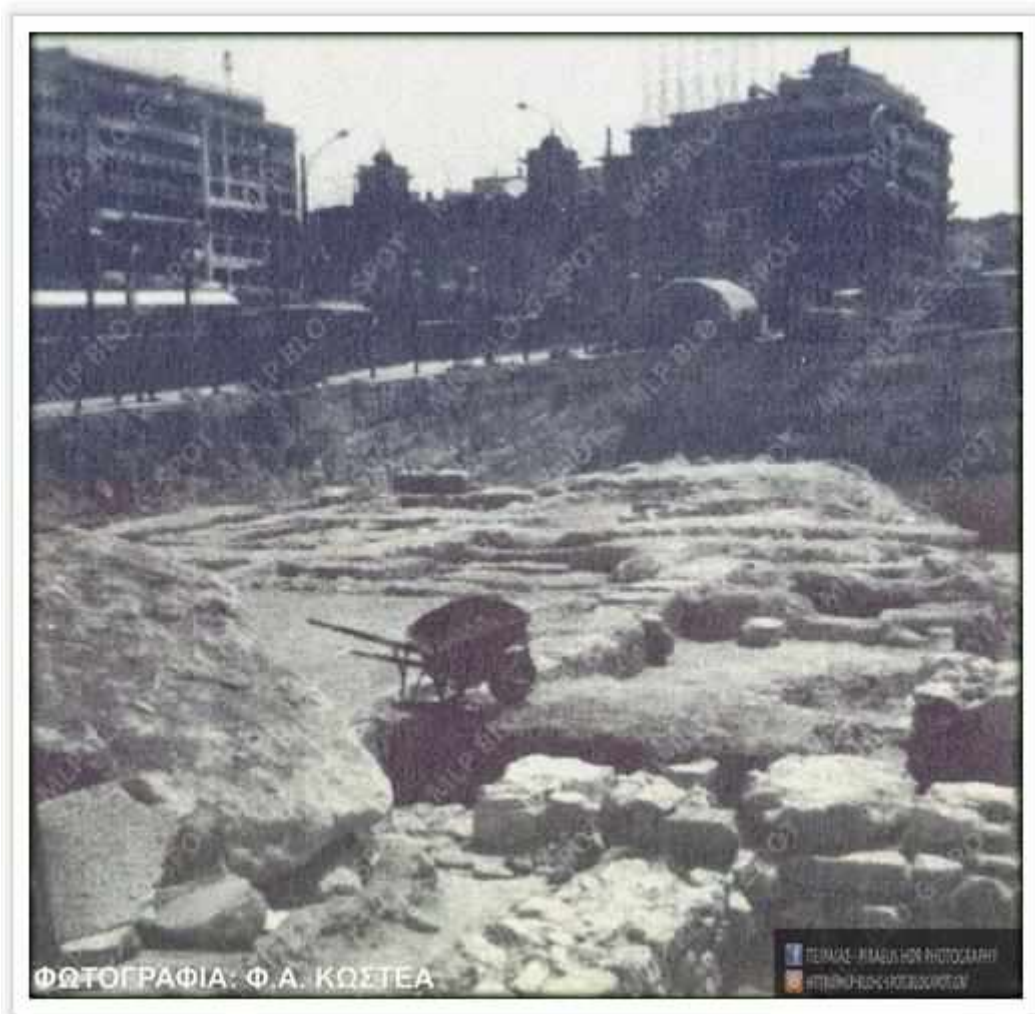
Εικόνα 1.14: Εύρεση αρχαίων κατά την εκσκαφή για την ανέγερση του παρόντος κτιρίου (προέλευση από άρθρο του διαδικτύου στη σελίδα http://mlp-blo-g-spot.blogspot.gr/2010/09/blog-post_02.html Αθήνα 2 Σεπτεμβρίου 2010).
