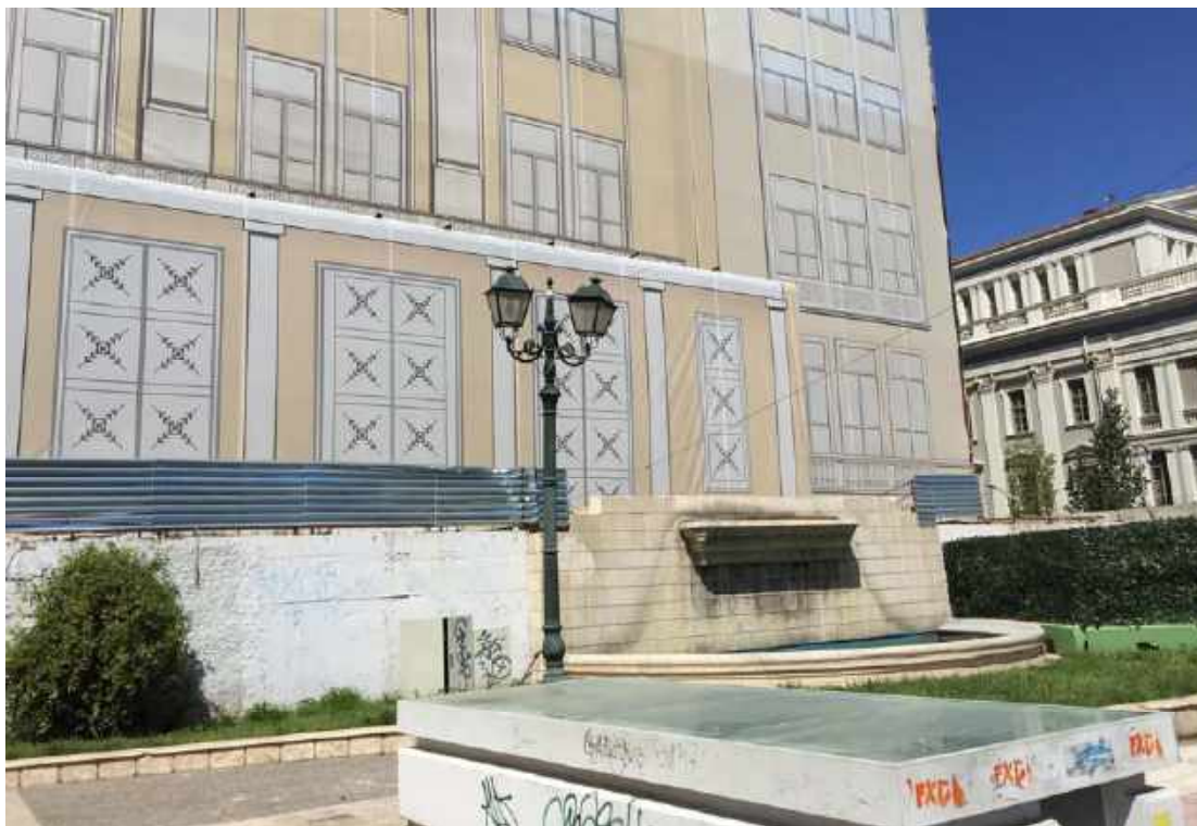
Εικόνα 1.8: Υπερνωμένο ισόγειο από τη λεωφόρο Ηρώων Πολυτεχνείου. Υπάρχει συντριβάνι στη θέση που είχαν αρχικά σχεδιαστεί σκαλοπάτια για την κεντρική πρόσβαση στο κτίριο
