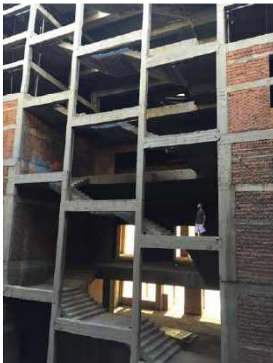
Εικόνα 1.19: Κλίμακα στην καρδιά του κτιρίου.
