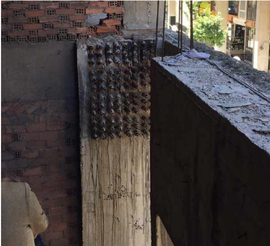
Εικόνα 1.15: Προεντεταμένη δοκός στο βόρειο τμήμα του κτιρίου.
