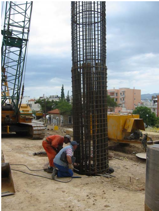
Εικόνα 4.8: Πάσσαλοι με κεφαλόδεσμο και αγκύρια για τον Προαστιακό στους Αγίους Αναργύρους ΠΗΓΗ : NAMA Α.Ε.
