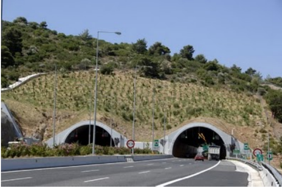
Εικόνα 2.13: Σήραγγα στην Αττική Οδό στην περιφερειακή Υμηττού
