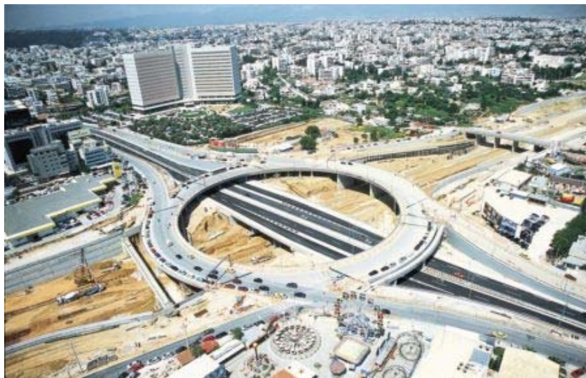
Εικόνα 2.28: Δαχτυλίδι Κηφισίας κατά την κατασκευή ΠΗΓΗ: basf-cc.gr
