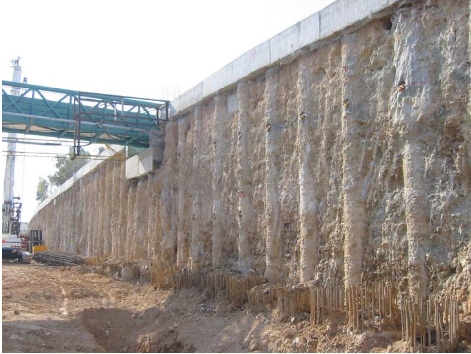
Εικόνα 4.8: Πάσσαλοι με κεφαλόδεσμο και αγκύρια για τον Προαστιακό στους Αγίους Αναργύρους ΠΗΓΗ : NAMA Α.Ε.
