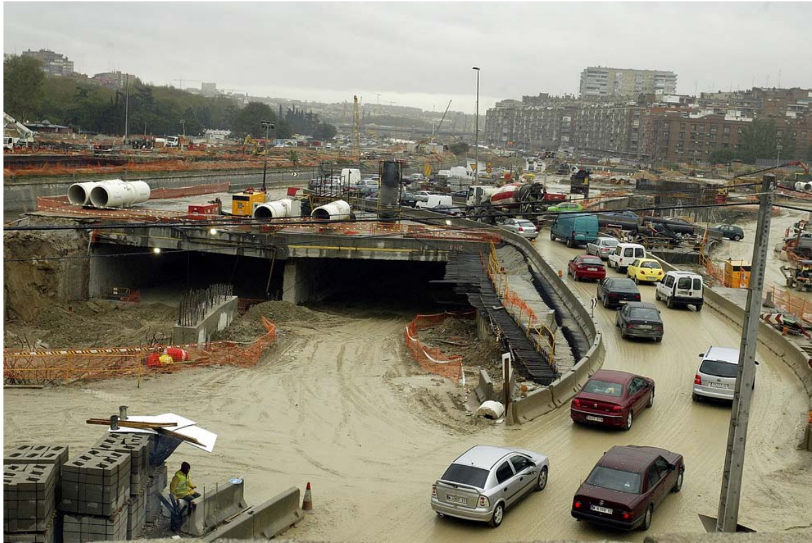
Εικόνα 2.20: Φάση κατασκευής στον Μ30 ΠΗΓΗ: sustainablecitiescollective.com
