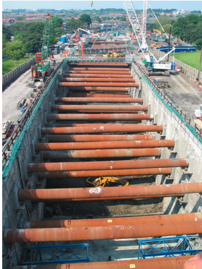
Εικόνα 2.25: Dublin Port-αντιστήριξη με αντηρίδες ΠΗΓΗ: dublinporttunnel.ie
