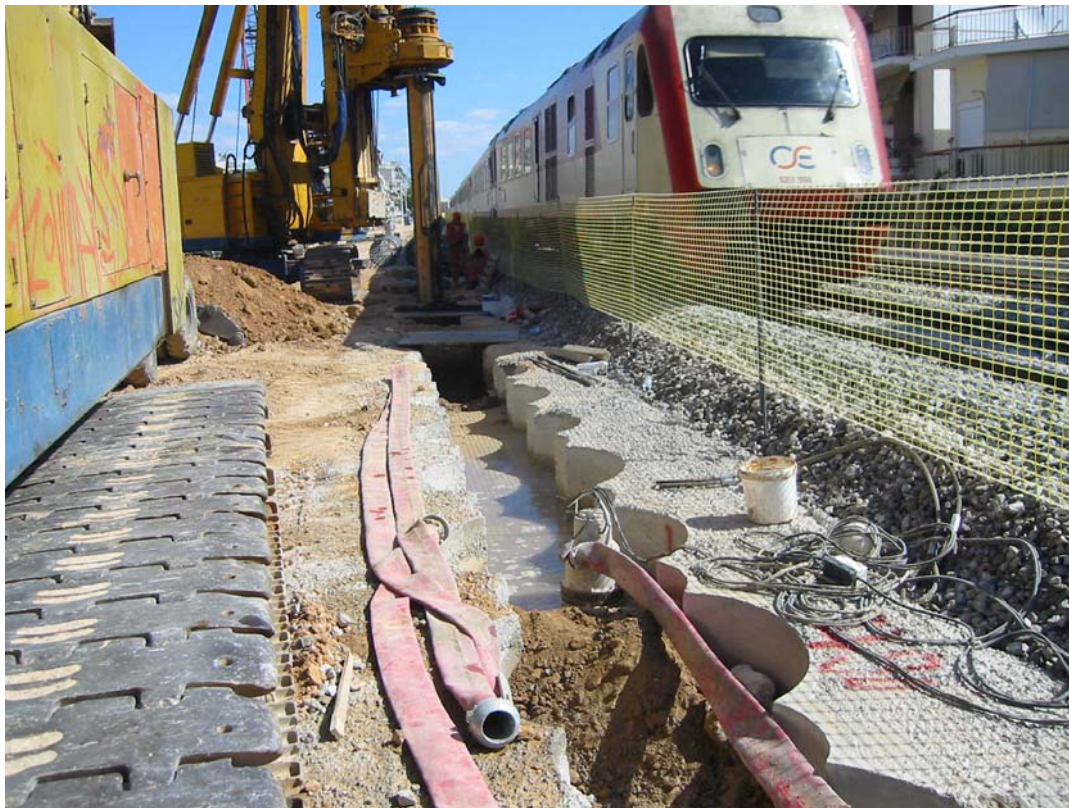
Εικόνα 4.7: Αλληλοτεμνόμενοι πάσσαλοι για τον Προαστιακό στους Αγίους Αναργύρους ΠΗΓΗ : NAMA Α.Ε.
