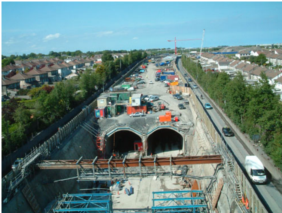
Εικόνα 2.24: Dublin Port-Cut n Cover
