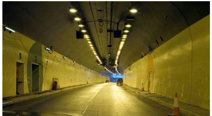
Εικόνα 2.23: Dublin Port tunnel ΠΗΓΗ: dublinporttunnel.ie
