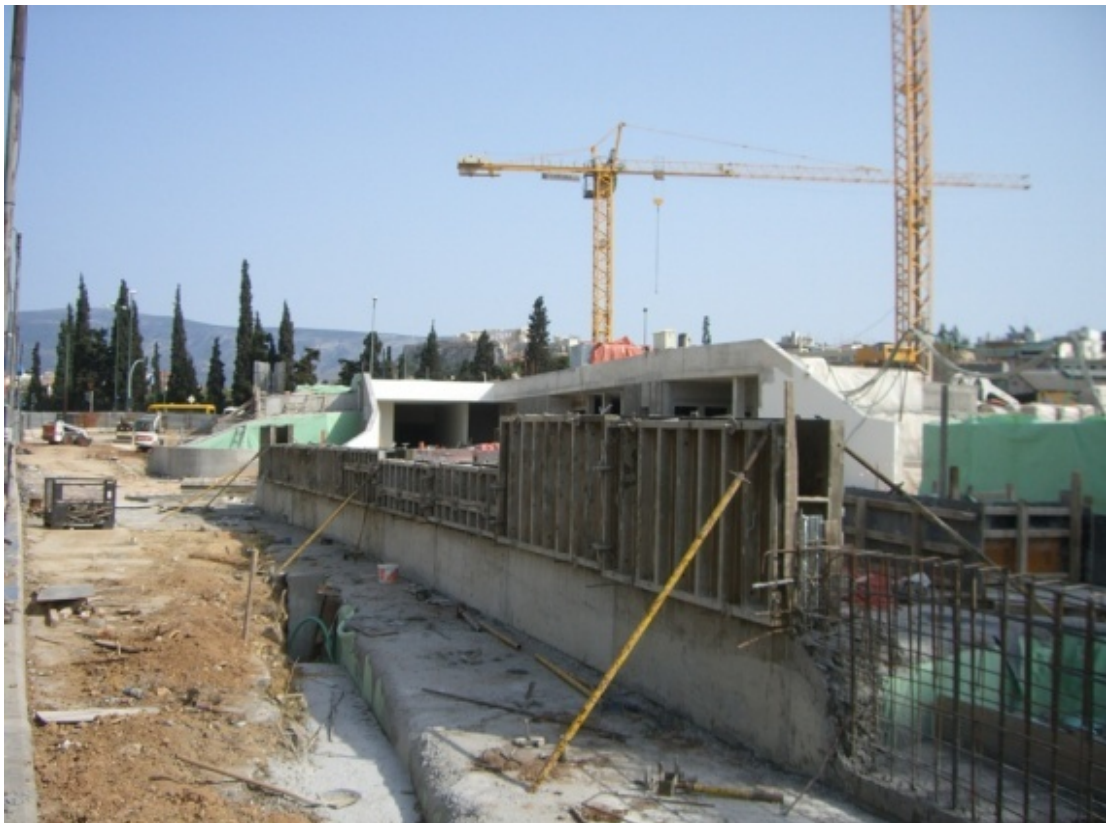
Εικόνα 3.13: Ο υπό κατασκευή χώρος στάθμευσης της Αττικό Μετρό
