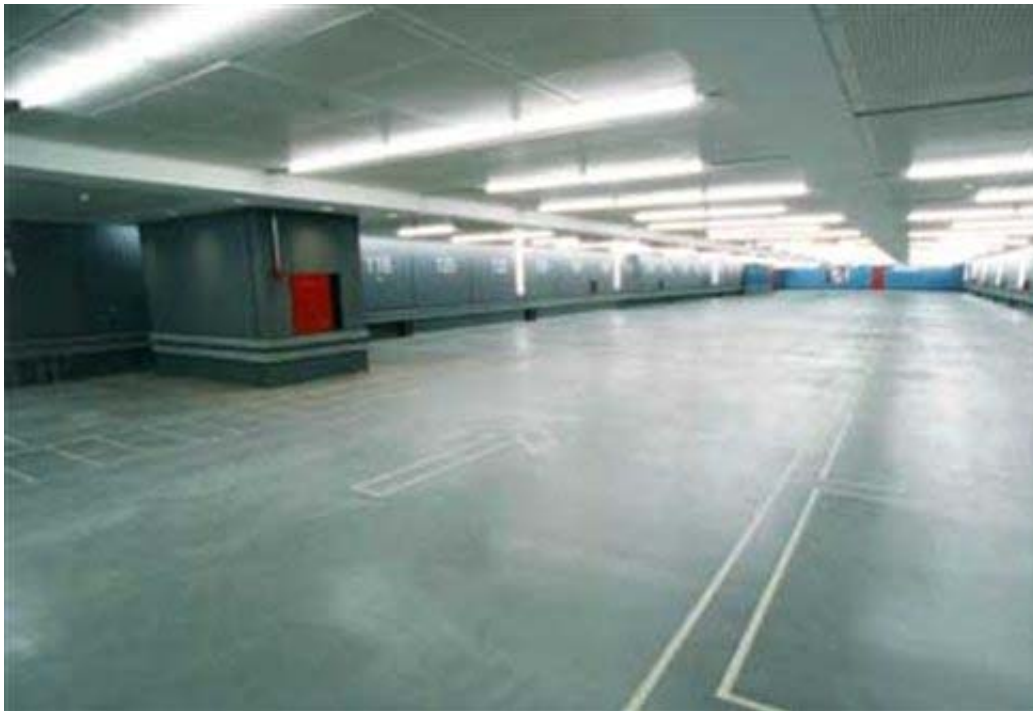
Εικόνα 2.10: Υπόγειο Parking στο Μέγαρο Μουσικής ΠΗΓΗ: www.in.gr
