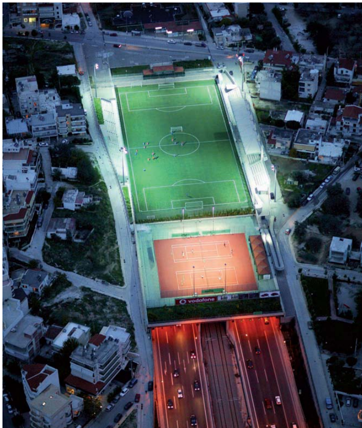
Εικόνα 2.32: Καλυμμένο τμήμα Ηρακλείου ΠΗΓΗ: aodos.gr
