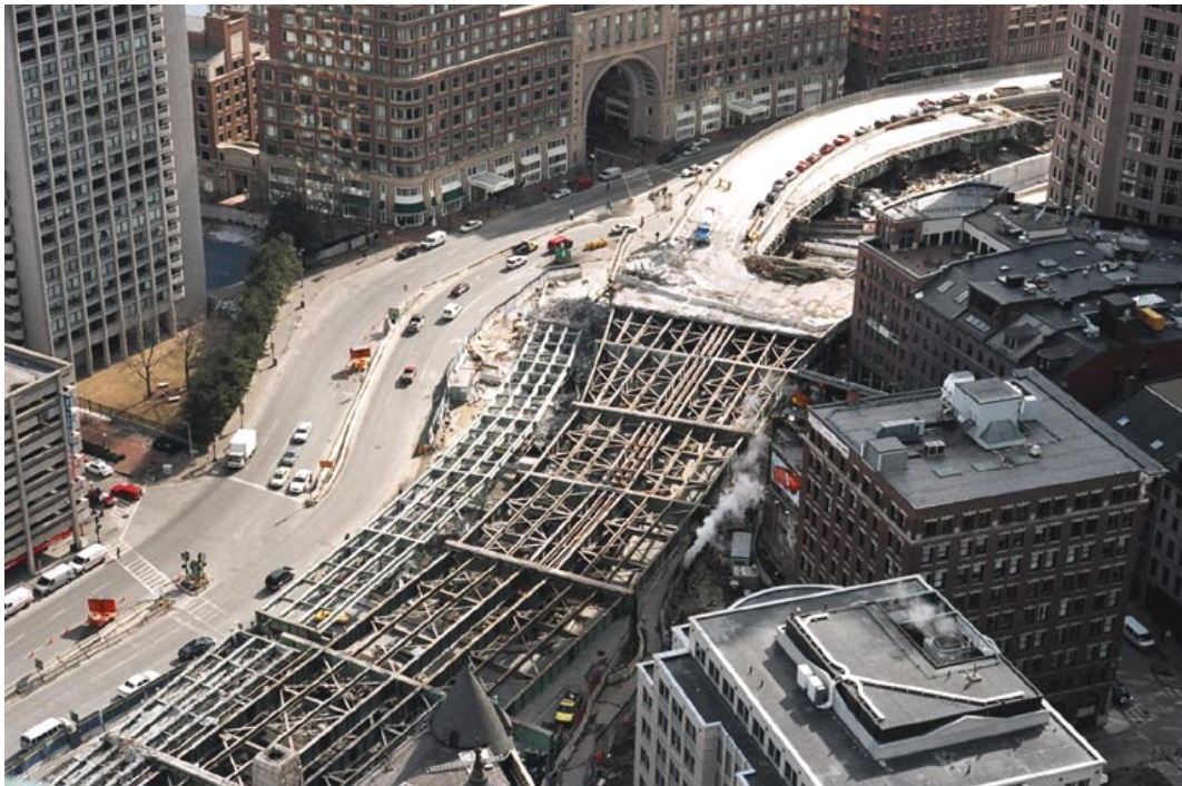
Εικόνα 2.15: Εικόνα του έργου κατά την διάρκεια κατασκευής, CA/T ΠΗΓΗ: pinkunderbelly.wordpress.com
