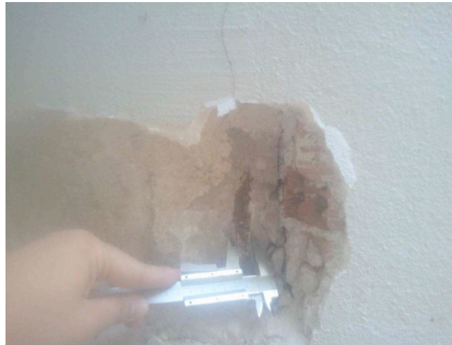
Εικόνα 4.6 Αποκάλυψη οπλισμού
