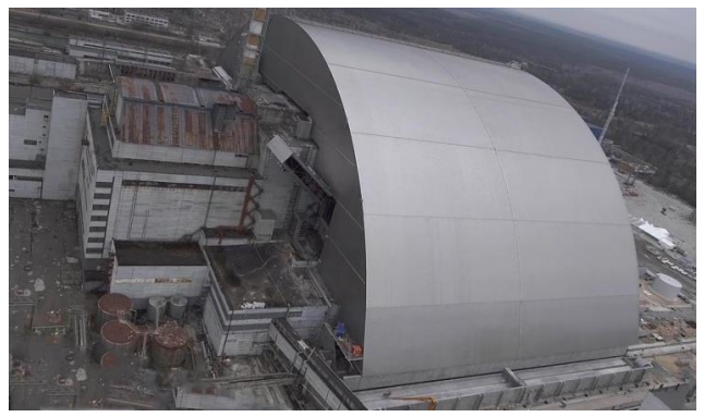
Εικόνα 1.4: Η καινούργια κατασκευή, τοποθετημένη και σε πλήρη λειτουργία [4]
