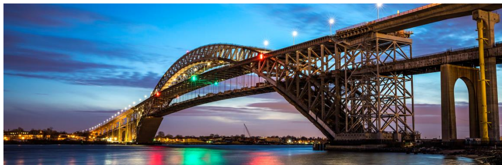
Εικόνα 1.7: Η γέφυρα Bayonne πριν την καθαίρεση του αρχικού καταστρώματος [7]
