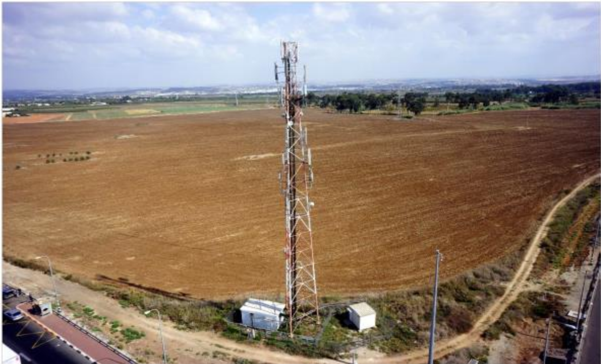
Εικόνα 4.9: Πύργος κινητής τηλεφωνίας στο Ισραήλ
