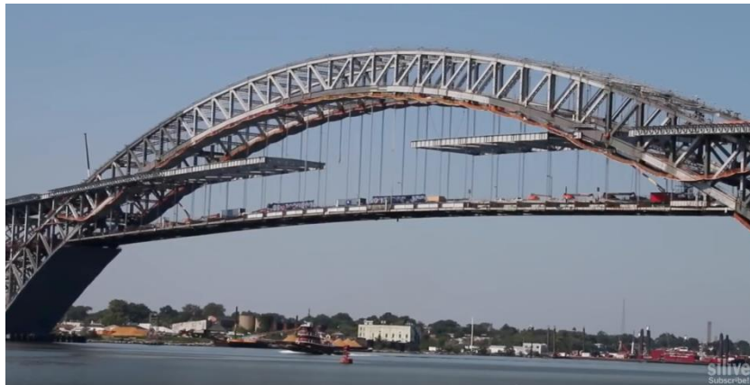
Εικόνα 1.6: Η κατασκευή του νέου καταστρώματος [6]
