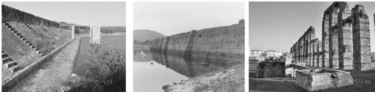
Εικόνα 2.3 Σύστημα νερού στη Μέριδα: (αριστερά) Φράγμα Cornalvo κοντά στη Μέριδα. (μεσαίο) φράγμα Proserpina κοντά Merida. Και (δεξιά) τμήμα γέφυρας υδραγωγείου Los Milagro στην Rio Albarregas στη Μέριδα Πηγή: (Mays et al., 2007).
