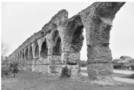
Εικόνα 2.4 Υδραγωγείο του ποταμού Gier κοντά Charonost Γαλλία Πηγή : (Mays et al., 2007)
