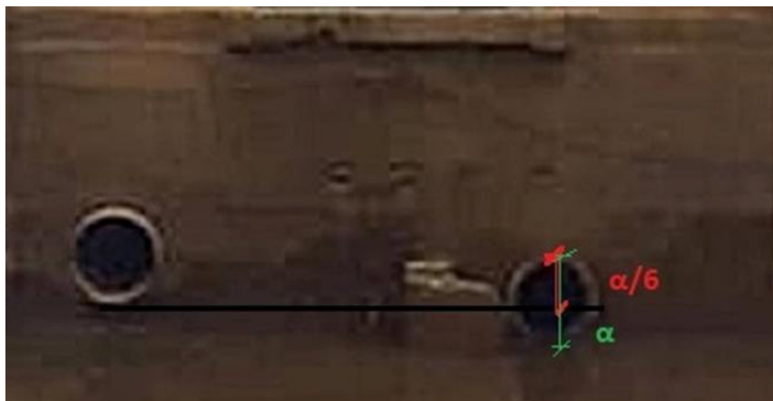
Εικόνα 4.2 Η υψομετρική διαφορά των οπών της Αδριάνειας Δεξαμενής. Πηγή: (Η Καθημερινή, 2019) μετά από προσαρμογή
