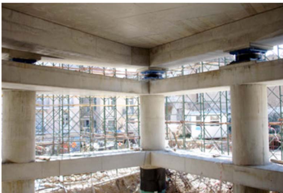
Εικόνα 3.1: Εφέδρανα ολίσθησης στο Μουσείο της Ακρόπολης
