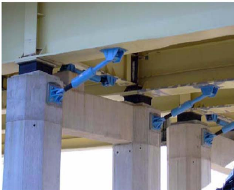
Εικόνα 3.3: Αποσβεστήρες, Ρίο-Αντίριο
