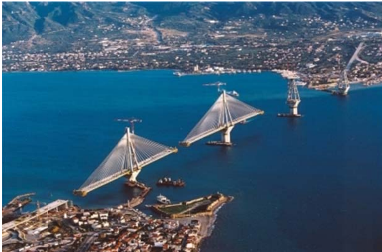
Εικόνα 1.11: Γέφυρα Ρίου- Αντίρριου (φάση κατασκευής)
