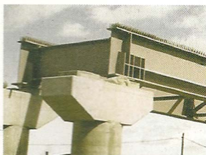
Σχήμα 1.8: Εγκάρσιες ενισχύσεις και διαφράγματα στις περιοχές των στηρίξεων
