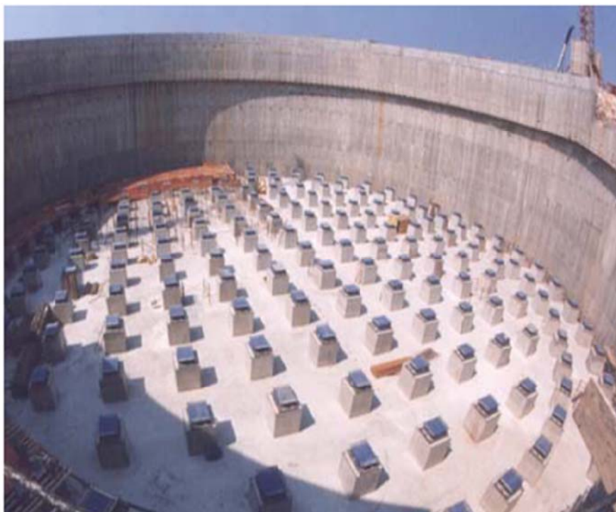
Εικόνα 3.2: Δεξαμενή αποθήκευσης υγροποιημένου φυσικού αερίου
