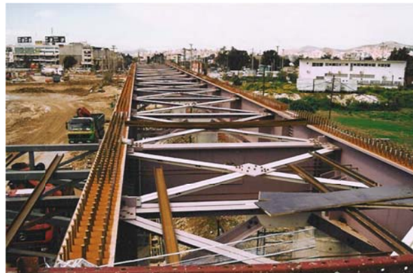
Εικόνα 1.2: Άνω οριζόντιος δικτυωτός σύνδεσμος
