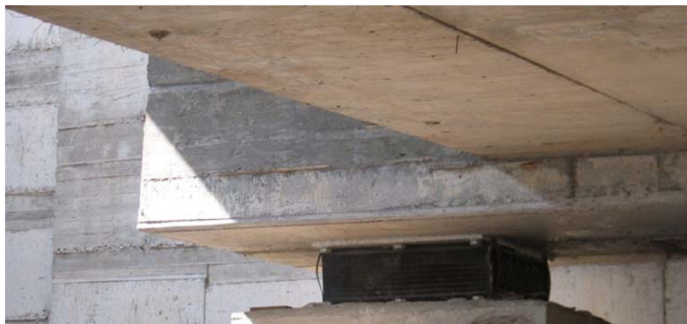
Εικόνα 3.5: Ελαστομεταλλικό εφέδρανο
