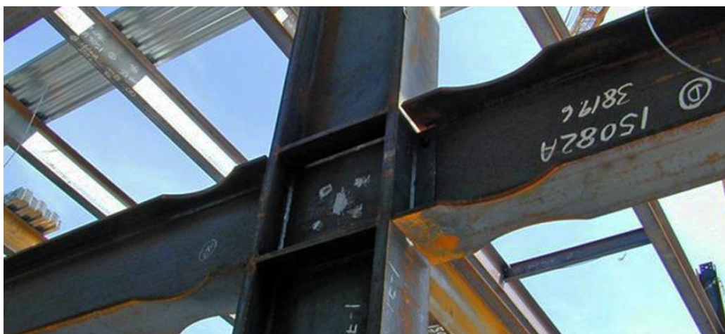
Σχήμα 8.1: Τυπική διαμόρφωση ακτινικά απομειωμένης διατομής δοκού με βάση τα Διεθνή Πρότυπα (από Lundopsahl)
