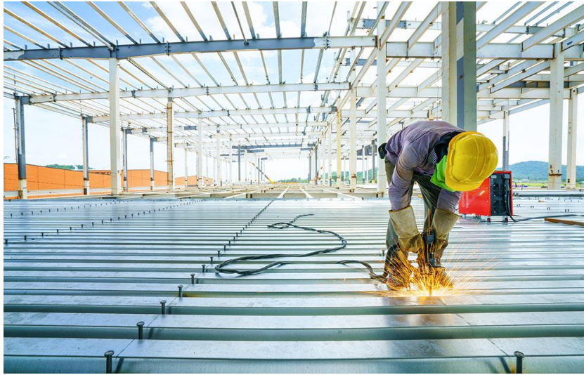
Σχήμα 4.11: Συγκόλληση διατμητικών ήλων κεφαλής δια μέσω του χαλυβδόφυλλου (από Metal Deck UK)
