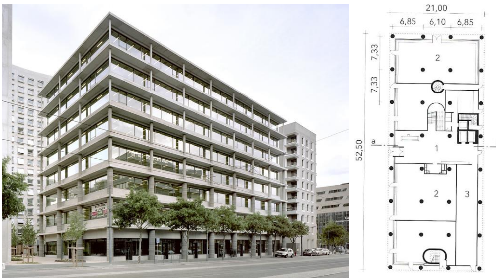
Σχήμα 1.1: Προς μελέτη οκτώοροφο κτίριο σκυροδέματος στην συνοικία La Confluence Îlot A3 στην Lyon (από Archdaily, 2018). Οι πλευρές της κατόψεως είναι 19.80m x 51.31m.
