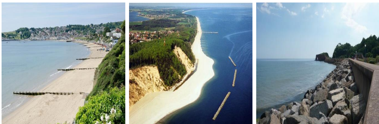
Εικόνα 2. 2: Έργα προστασίας ακτής κατά σειρά: πρόβολοι, κυματοθραύστες, θωράκιση με ογκολίθους. (Πηγές: pixels.com, Dr.B.Garawell, wikipedia.org)
