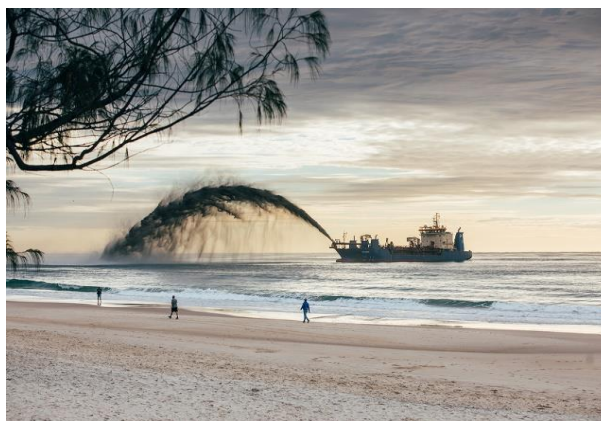
Εικόνα 2. 11: Στιγμιότυπο αναπλήρωσης ακτής. (Πηγή: goldcoast.qld.gon.au )
