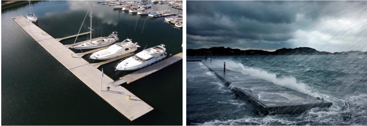
Εικόνα 2. 7: Πλωτοί κυματοθραύστες για δημιουργία μαρίνας (αριστερά) και σε μεγάλα ύψη κύματος (δεξιά). (Πηγή: www.sfmarina.com )
