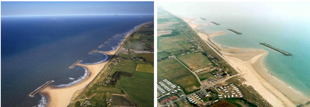
Εικόνα 2. 5: Σύστημα παράλληλων κυματοθραυστών στο οποίο διακρίνονται οι δύο μηχανισμοί προσχώσεως. (Πηγές: aeroengland.co.uk , www.ingenia.org.uk )
