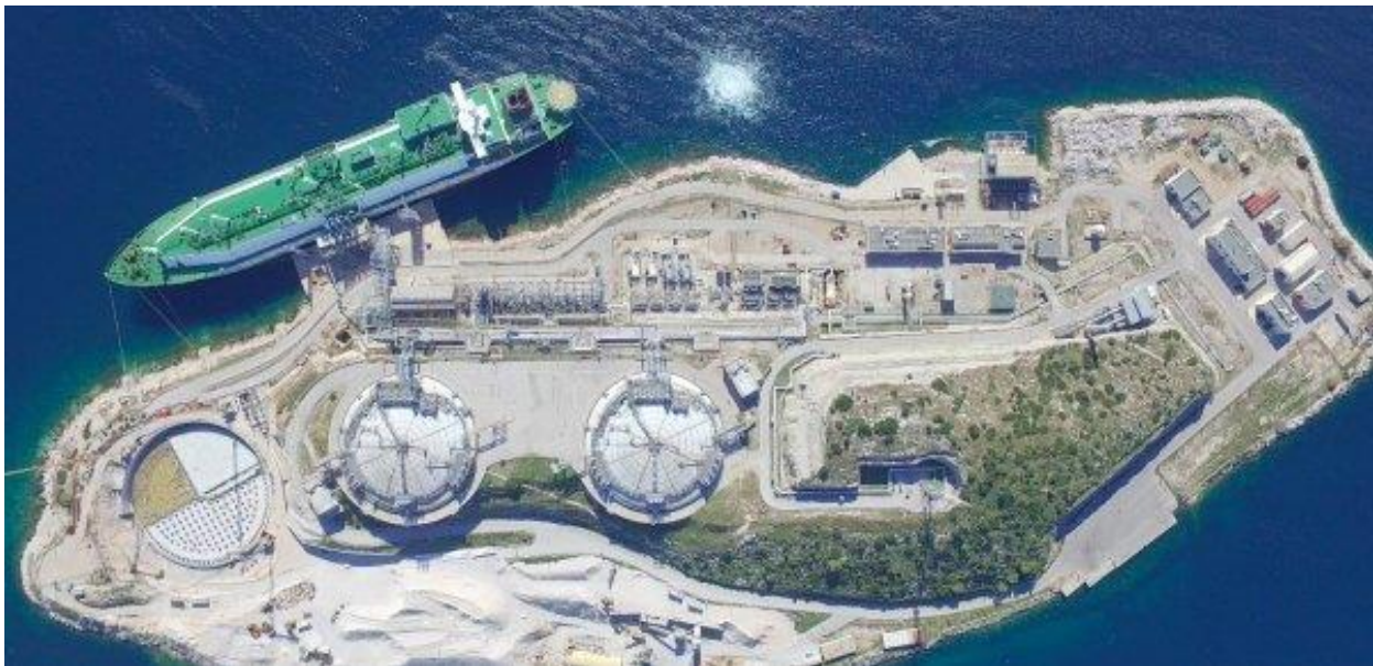
Εικόνα 6: Ο τερματικός σταθμός υγροποιημένου φυσικού αερίου στη Ρεβυθούσα [154]
