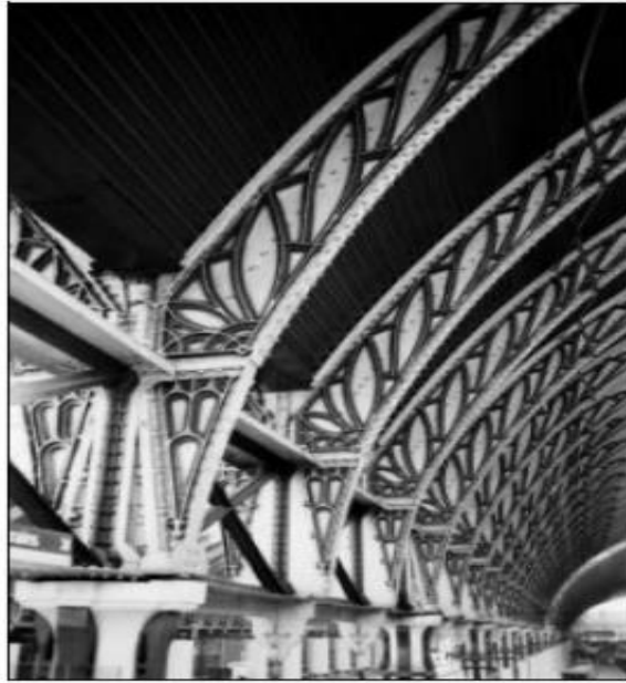
Σχήμα 3.2: Καμπύλος σφυρήλατος σίδηρος με διακοσμητικές προσθήκες από χυτοσίδηρο.
