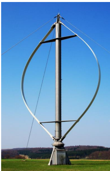
Εικόνα 3.4: Τυπική σύγχρονη ανεμογεννήτρια κατακόρυφου άξονα περιστροφής (πηγή: Profilnet)
