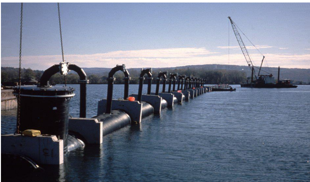
Σχήμα 1-2: Διαχυτήρες με κυκλικά στόμια, λίμνη Cayuga, USA (Πηγή: Mixing Processes and Mixing Zone Analysis G.H. Jirka)
