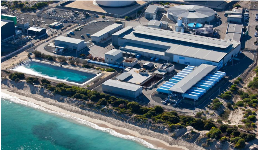
Σχήμα 1-1: Μονάδα αφαλάτωσης στο Perth της Αυστραλίας. (Πηγή: https://www.suezwaterhandbook.com/case-studies/desalination/Perth-reverse-osmosis-desalination-plant-Australia )
