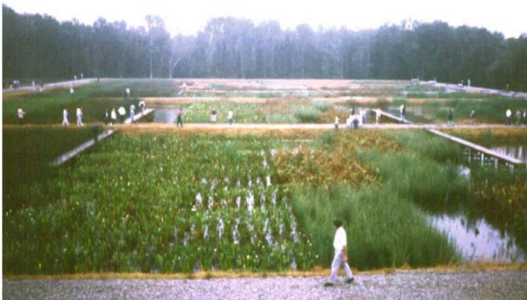
Σχήμα 2.17: Εικόνα τεχνητού υγροβιότοπου με πλήθος ειδών αναδυόμενων φυτών για τη δευτεροβάθμια επεξεργασία λυμάτων στη Florida (Vyrmazal & Kropfelona, 2008)
