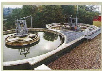
Εικόνα 5: εγκατάσταση επεξεργασίας στραγγισμάτων σε Χ.Υ.Τ.Α.
