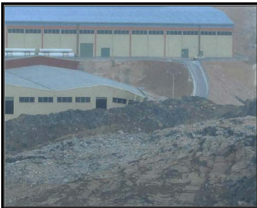
Εικόνα 8: Κατολίσθηση Απορριμμάτων Χ.Υ.Τ.Α. Δυτικής Αττικής – τα απορρίμματα έφτασαν ως το εργοστάσιο ανακύκλωσης
