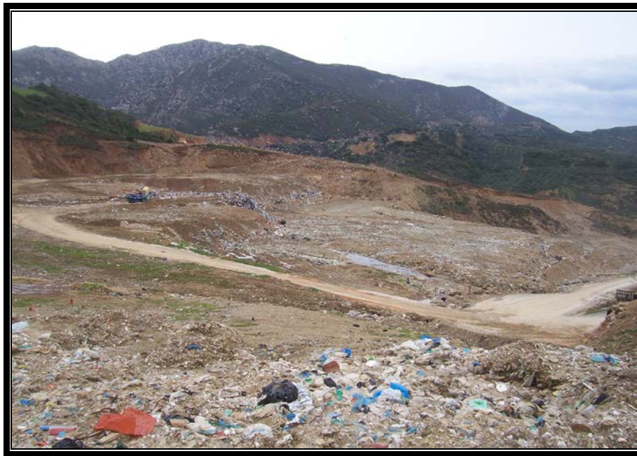
Εικόνα 26: Γενική άποψη Χ.Α.Δ.Α. Πέρα Γαληνών
