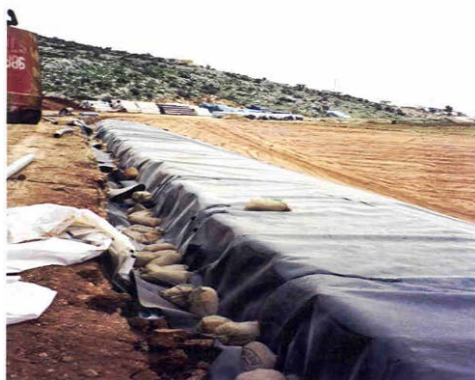
Εικόνα 3: εφαρμογή συστήματος στεγάνωσης σε Χ.Υ.Τ.Α.
