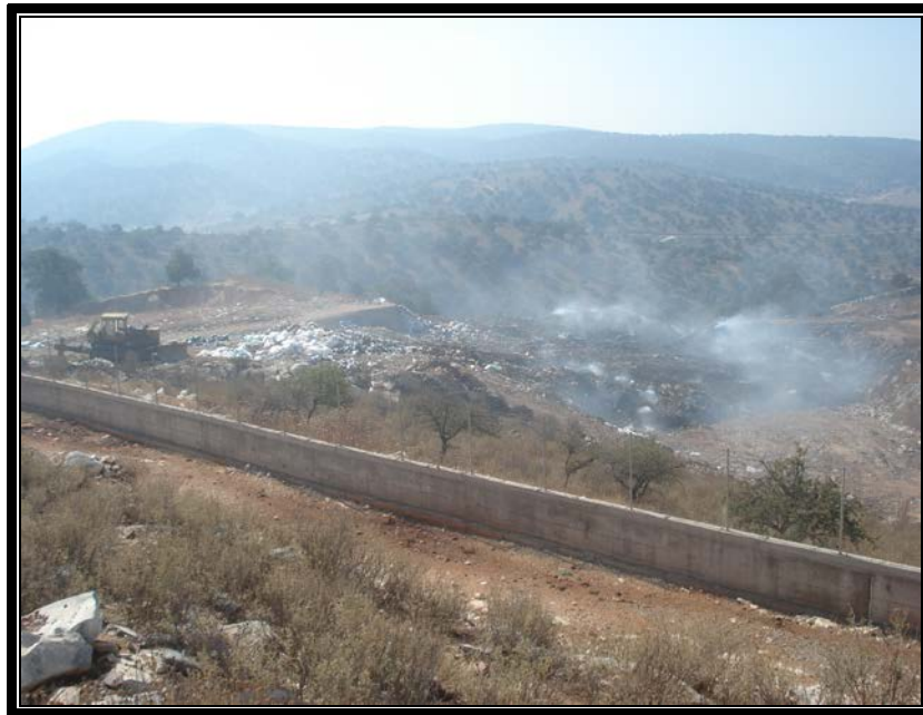
Εικόνα 20: Γενική άποψη πυρκαγιάς Χ.Α.Δ.Α. Αστακού
