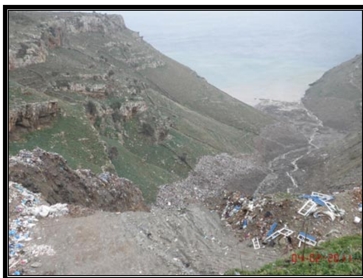
Εικόνα 28: Γενική κατολίσθησης απορριμμάτων Χ.Α.Δ.Α. Άνδρου
