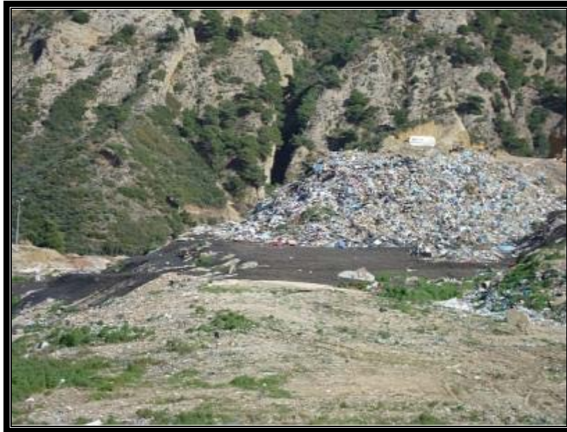
Εικόνα 11: Κατολίσθηση στον Χ.Υ.Τ.Α. Πάτρας
