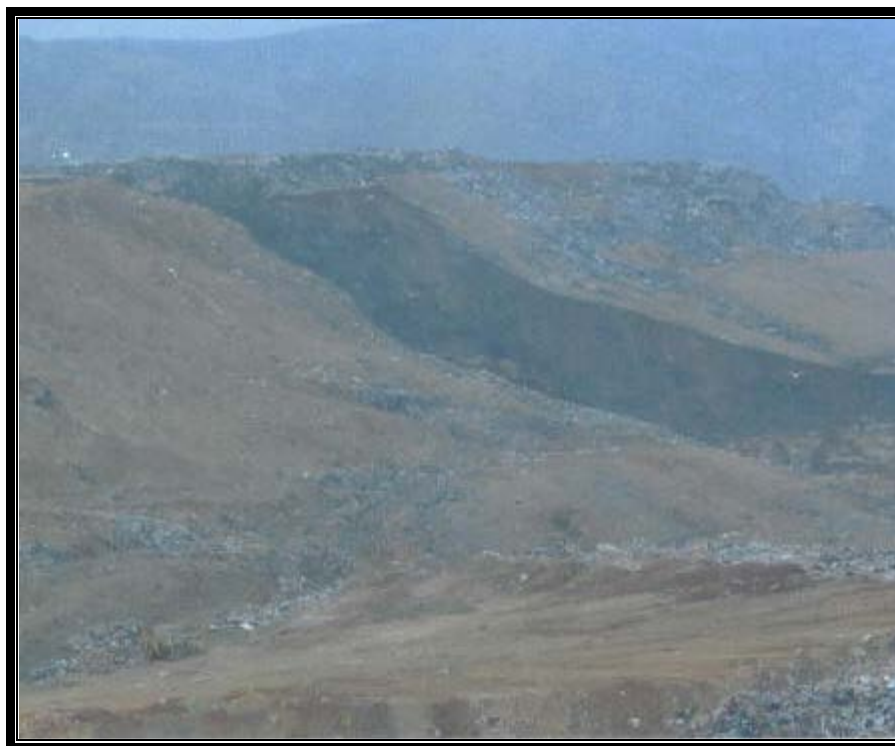
Εικόνα 7: Κατολίσθηση Απορριμμάτων Χ.Υ.Τ.Α. Δυτικής Αττικής
