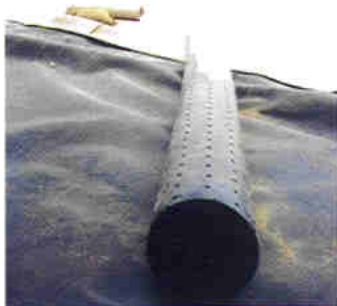
Εικόνα 4: αγωγός συλλογής στραγγισμάτων σε Χ.Υ.Τ.Α.
