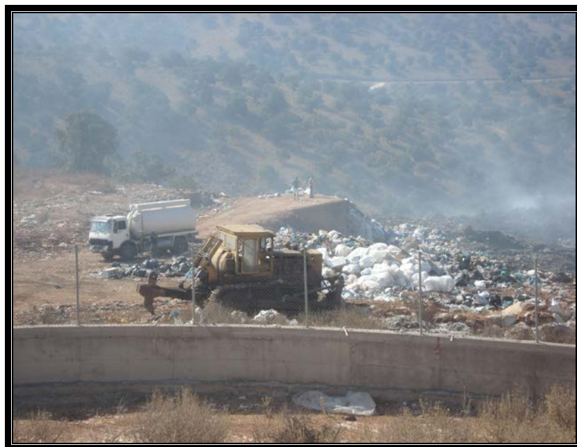
Εικόνα 21: Γενική άποψη πυρκαγιάς Χ.Α.Δ.Α. Αστακού
