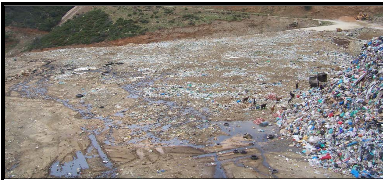
Εικόνα 2: ανεξέλεγκτη διαφυγή στραγγισμάτων από Χ.Α.Δ.Α.
