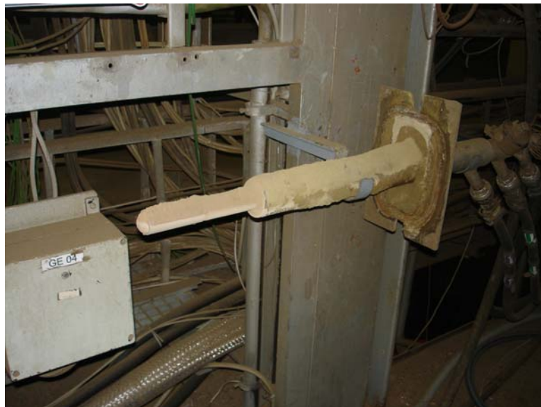
(Σχήμα 4.10) : Τυπική διάταξη λήπτη επικαθίσεων
