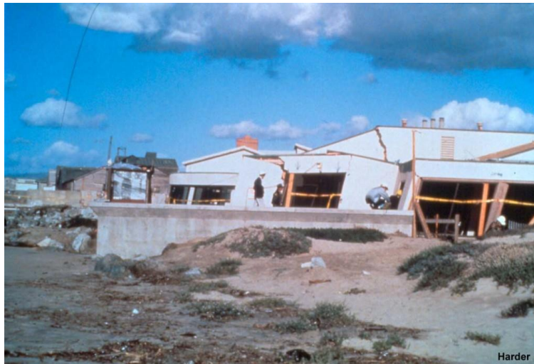
Σχήμα 2.2: Οριζόντια εξάπλωση κατασκευής στη περιοχή Moss Landing Marine Laboratory (περιοχή #4, Boulanger et al, 1997 )
