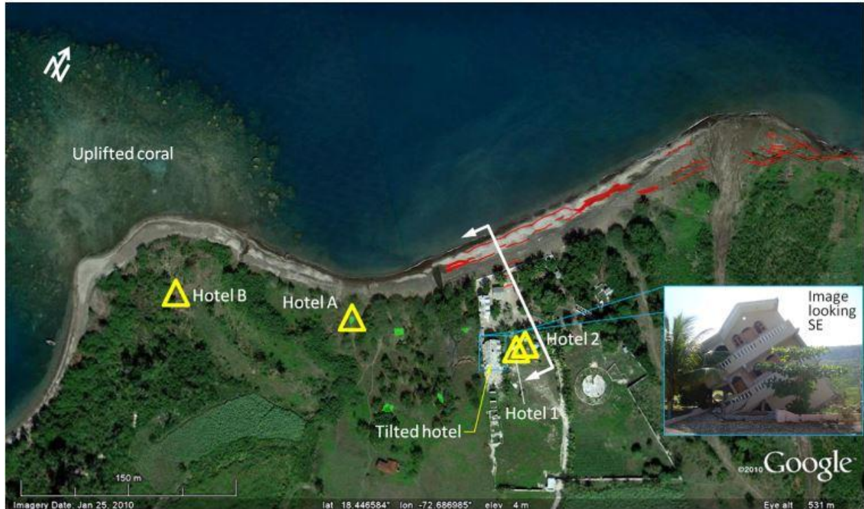
Σχήμα 2.4: Αστοχία ξενοδοχείου και εδάφους λόγω ρευστοποίησης (Olson et al, 2011)
