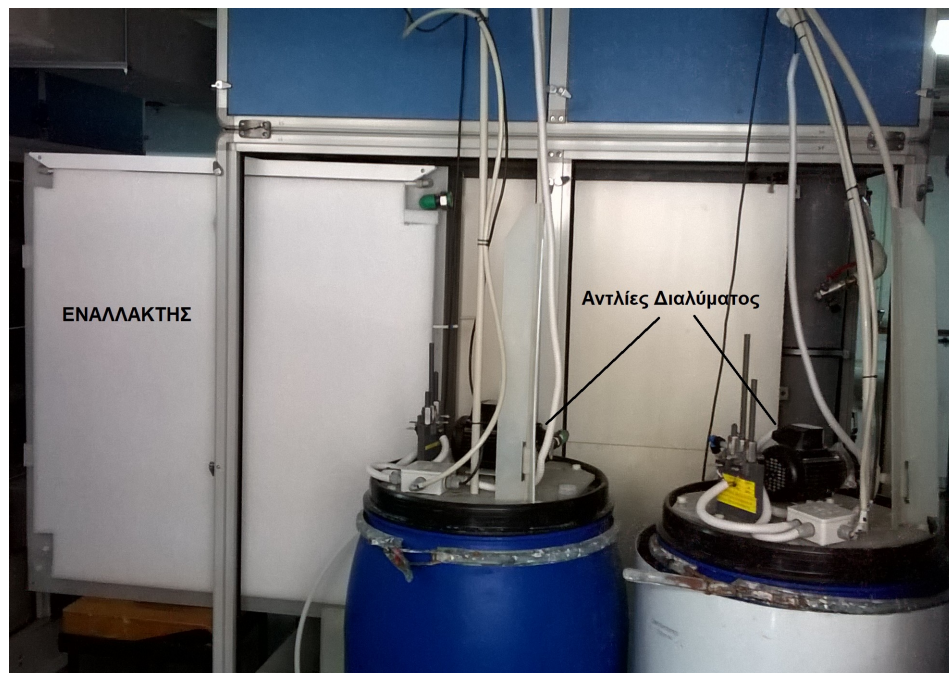
Εικόνα 10: Εναλλάκτης Αναγεννητή κατά την ώρα της αντικατάστασης
