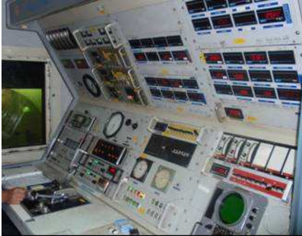
Εικόνα 5.1 Διάταξη Ελέγχου της Ισχύος του Κινητήρα και στο Δοκιμαστήριο της EAB
