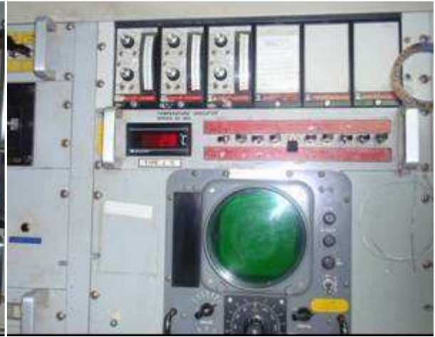
Εικόνα 5.10 Καταγραφή Θερμοκρασίας Εισαγωγής και Προβλεπόμενο Σύστημα Ελέγχου Συστήματος Ανάφλεξης
