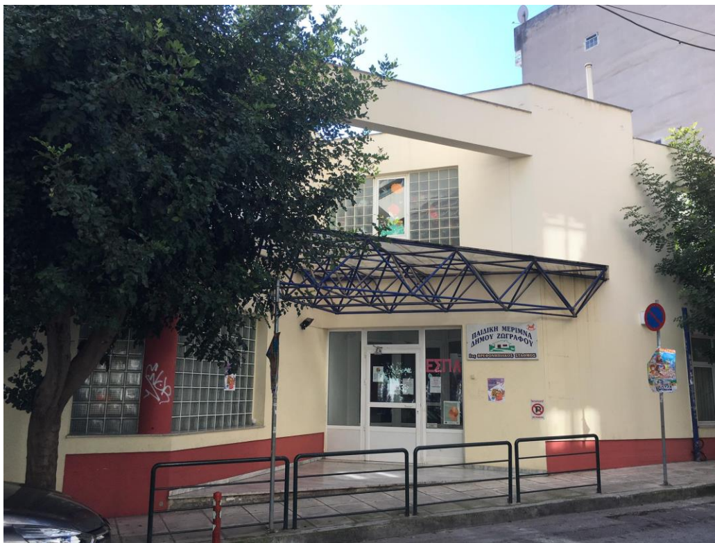
Σχήμα 1.1 Εξωτερική άποψη του υφιστάμενου κτιρίου
