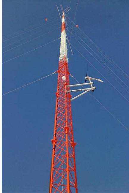
Εικόνα 1.2: Ιστός τριγωνικής και σταθερής διατομής.
