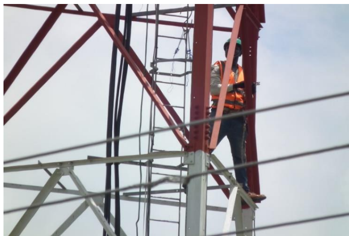
Εικόνα 1.5: Ιστός με χρήση L beam
