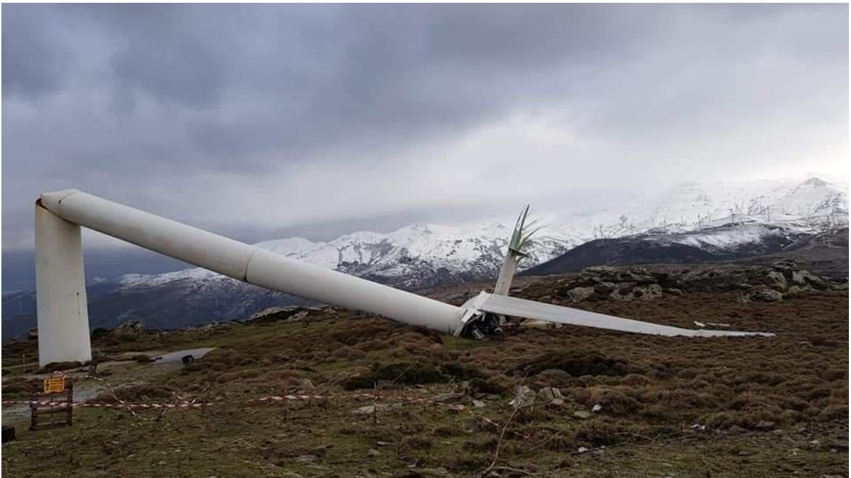
Εικόνα 1.18: Αστοχία πυλωνα ανεμογεννήτριας στην Εύβοια, κατά τα ακραία καιρικά φαινόμενα του «Ηφαιστίωνα», στις 09/01/2020
