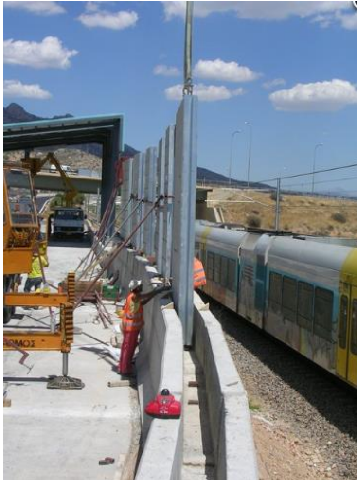
Εικόνα 23: Τοποθέτηση ηχοπετασμάτων από σκυρόδεμα και ηχοαπορροφητικά υλικά στο τμήμα του προαστιακού κοντά στο Αεροδρόμιο
