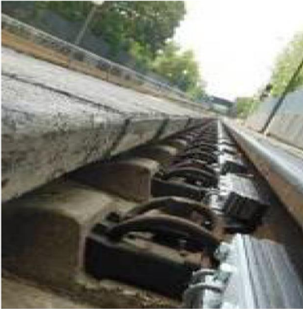
Εικόνα 28: Τοποθέτηση ηχητικών αποσβεστήρων σιδηροτροχιάς στη γραμμή 1 του Αττικό Μετρό (Konstantinos Vogiatzis &, Patrick Vanhonacker, 2015)
