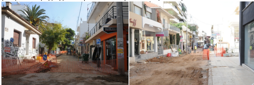
Εικόνα 44& 45: Έργα πεζοδρόμησης επί της Χαϊμαντά Πηγή: Δήμος Χαλανδρίου
