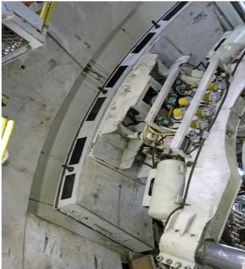
Εικόνα 2.4: Σύστημα τοποθέτησης προκατ. στοιχείων μετρό Αγ. Βαρβάρας (Γιαταγάνα, 2014)
