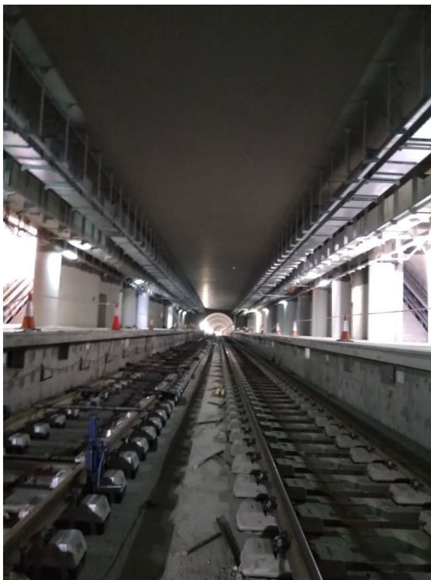
Εικόνα 1.2: Σήραγγα TBM από το Σταθμό ΑΓΙΑ ΒΑΡΒΑΡΑ
