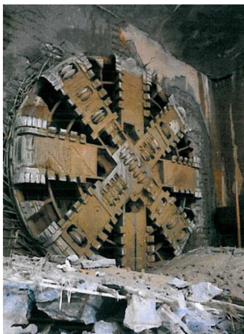
Εικόνα 2.2: Κεφαλή μηχανήματος EPB σε ξετρύπωμα σταθμού (Γιαταγάνα, 2014)
