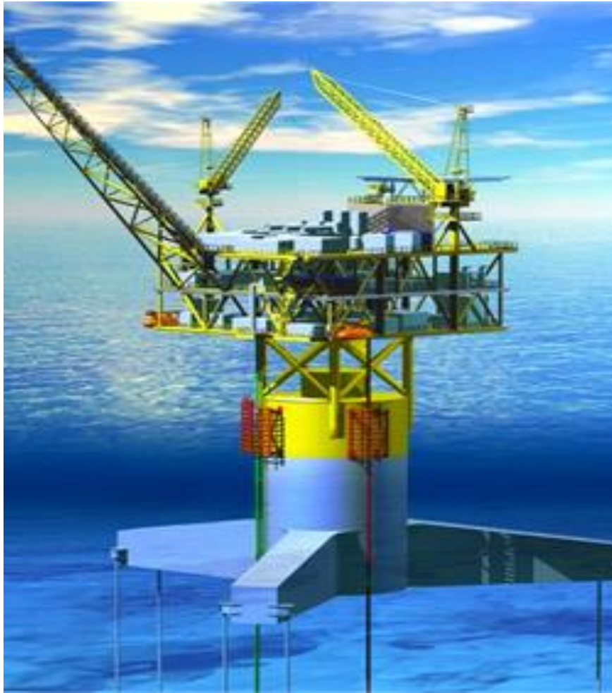
Σχήμα 7: Πλατφόρμα τύπου tension legs [38].
