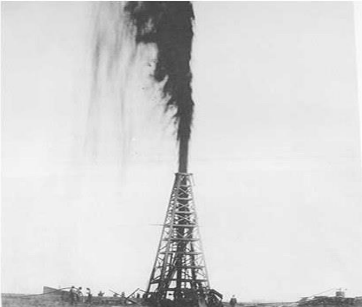
Σχήμα 15: Blowout σε εγκατάσταση άντλησης πετρελαίου, Spindletop Texas (1901). Στην εικόνα φαίνεται ο πίδακας πετρελαίου που σχηματίζεται από την ακατάσχετη ροή προς την επιφάνεια. Αυτή η κατάσταση παρουσία σπινθήρα ακολουθείται από ανάφλεξη του πίδακα με καταστροφικές συνέπειες.
