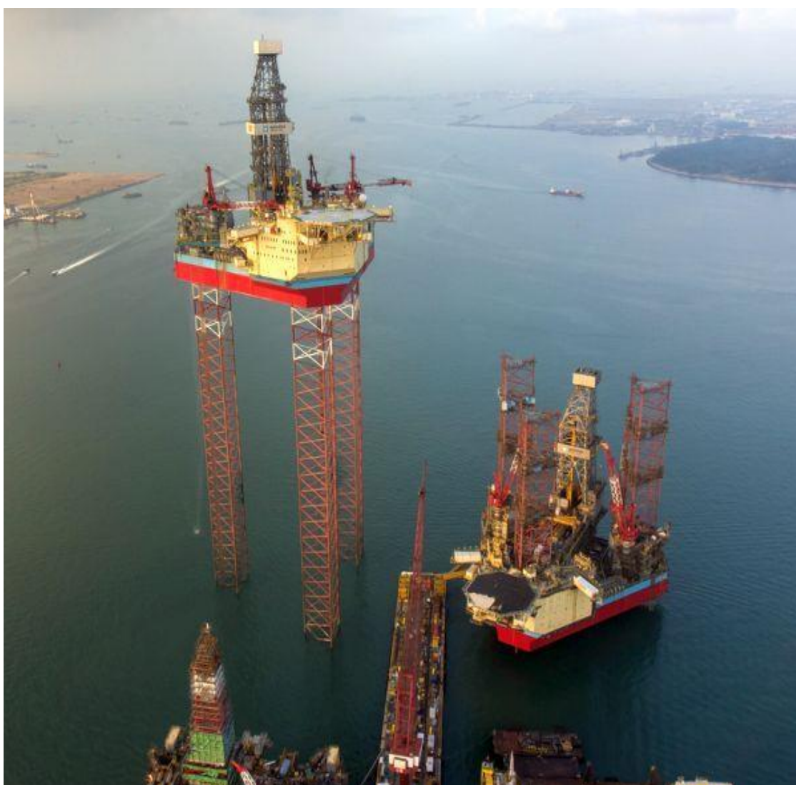
Σχήμα 11: Πλατφόρμα jackup με τους πυλώνες κατεβασμένους κατά την διαδικασία τοποθέτησης της [48].
