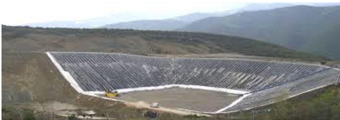
Σχήμα 10: Στεγανοποιημένος Χώρος Υγειονομικής Ταφής (ΧΥΤΑ ΑΡΤΑΣ)
