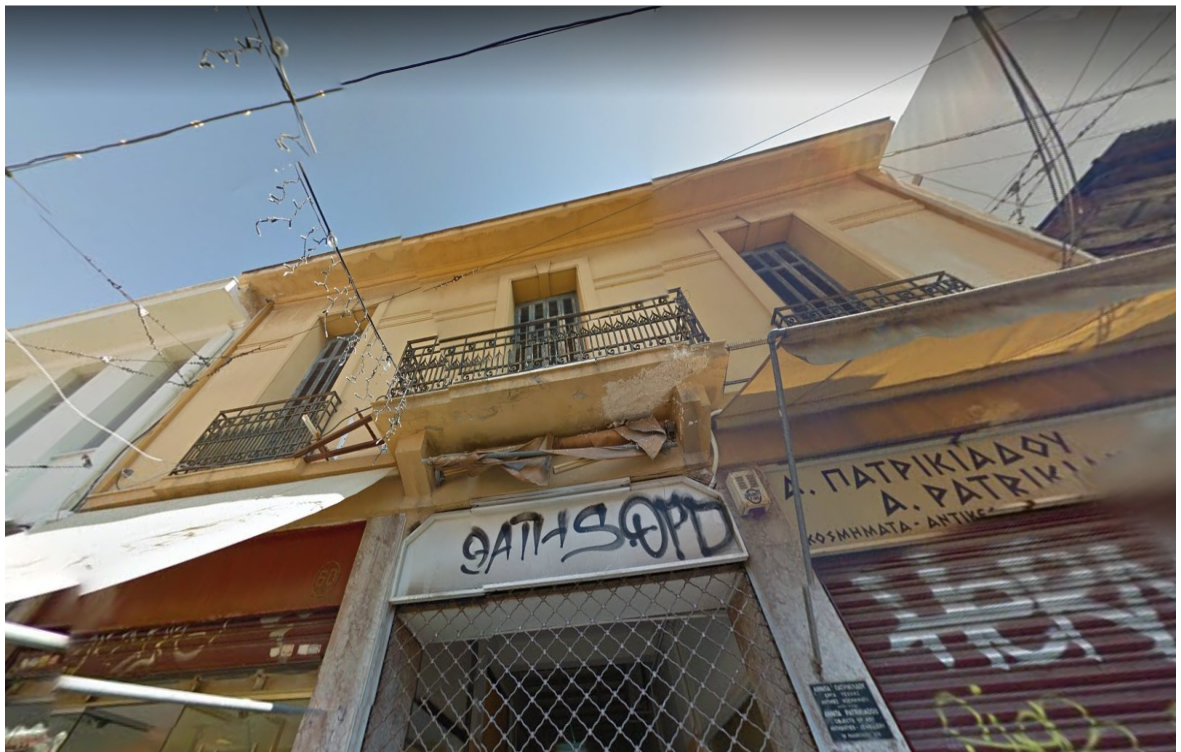
Σχήμα 3.2: Φωτογραφία πρόσοψης του κτιρίου, 2019
