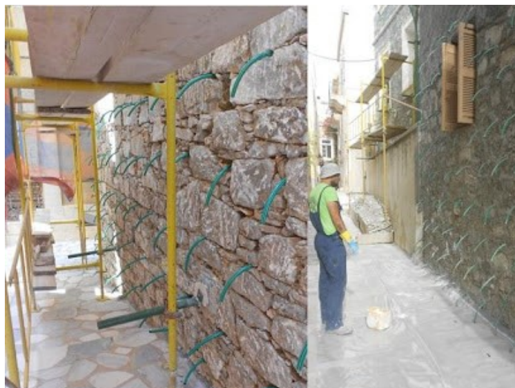
Σχήμα 6.18: Ενίσχυση φέρουσας τοιχοποιίας με ενέσεις ενεμάτων
