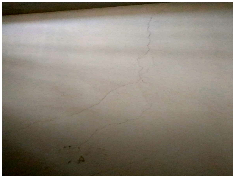
Σχήμα 4.2: Αστοχία της τοιχοποιίας i) στον όροφο του ισογείου (στο βάθος της στοάς), ii) και iii) στον πρώτο όροφο του κτιρίου
