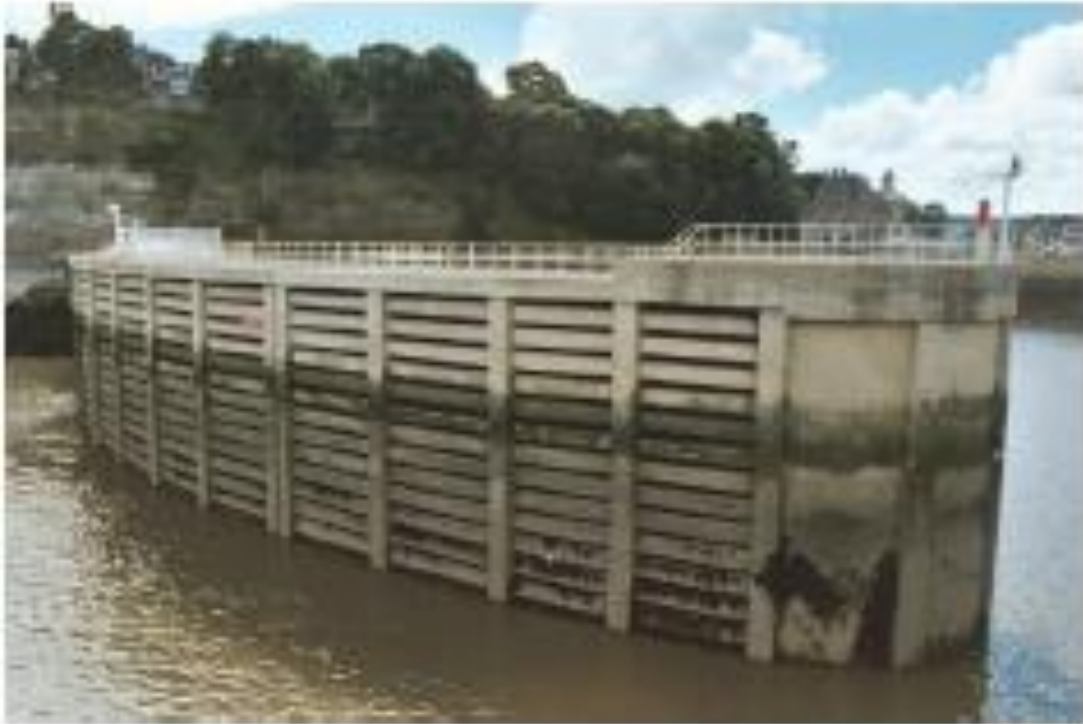
Σχήμα 16: Μορφή διάτρητου κυματοθραύστη με κατακόρυφο μέτωπο (Πηγή: Eurotop II 2016)
