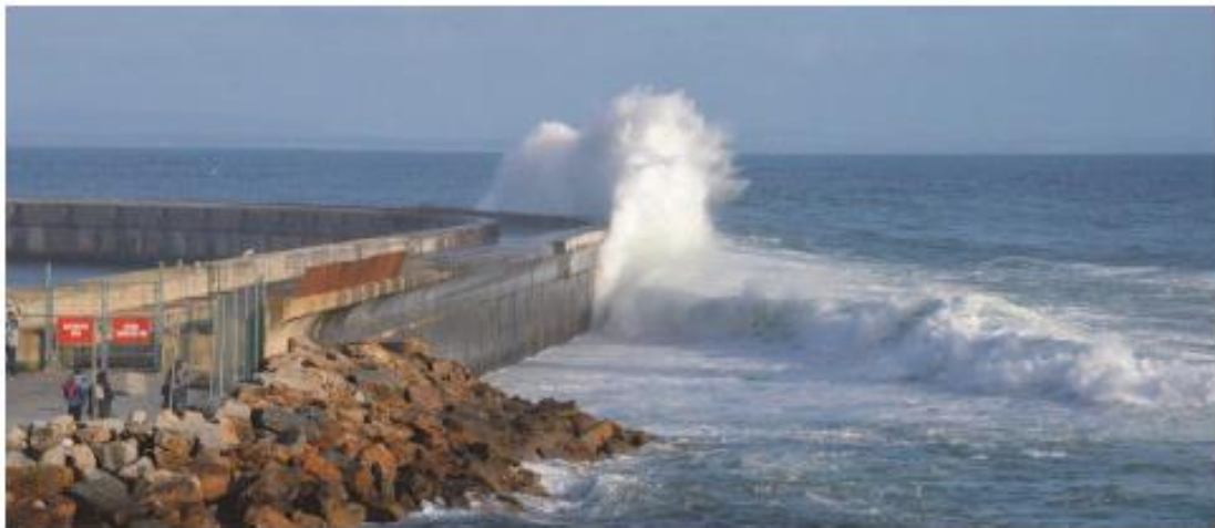
Σχήμα 14: Κυματοθραύστης με γωνιώδη παραπετάσματα (Πηγή: Eurotop II 2016)
