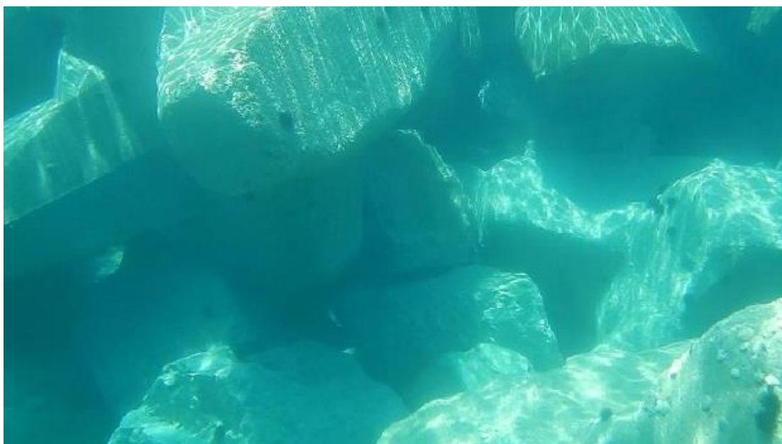
Σχήμα 53: Λίθοι σε ακάλυπτα από ακρόποδα τμήματα του πρανούς (Πηγή: Ε.Λ.Ε. Ε.Μ.Π.,2018).
