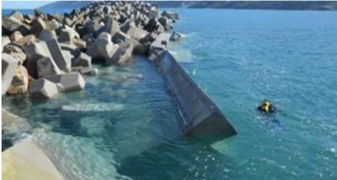
Σχήμα 34: Σημείο υποχώρησης κρηπιδότοιχου (Πηγή: Wikipedia).
