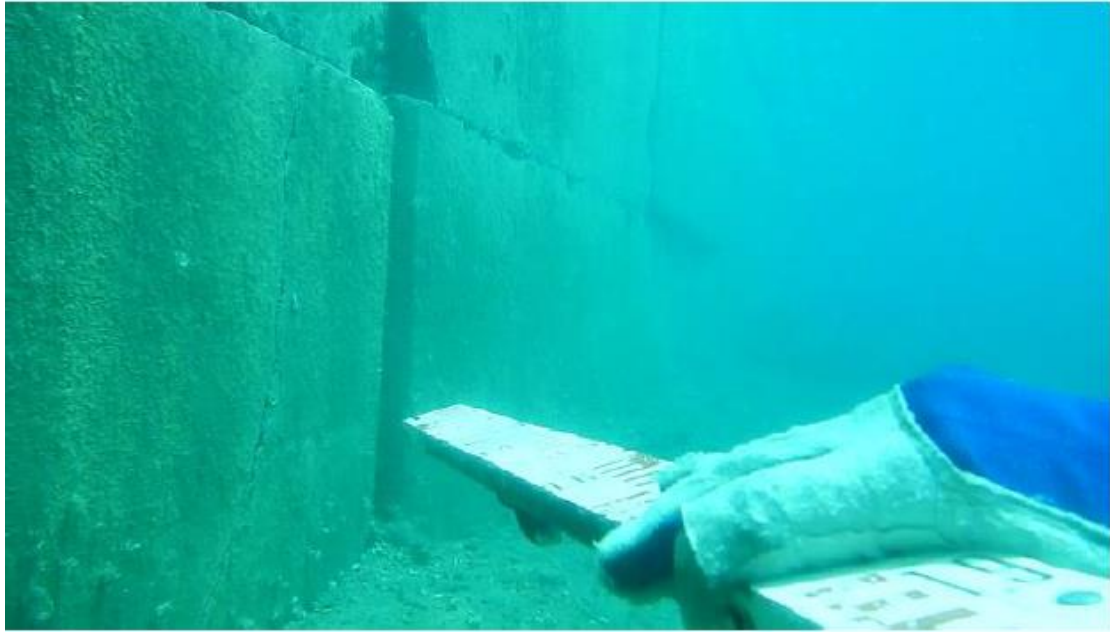
Σχήμα 49: Ρηγματώση στο βασικό Σ.Τ.Ο. στη δεύτερη στήλη από τη συναρμογή (Πηγή: Ε.Λ.Ε. Ε.Μ.Π., 2018).
