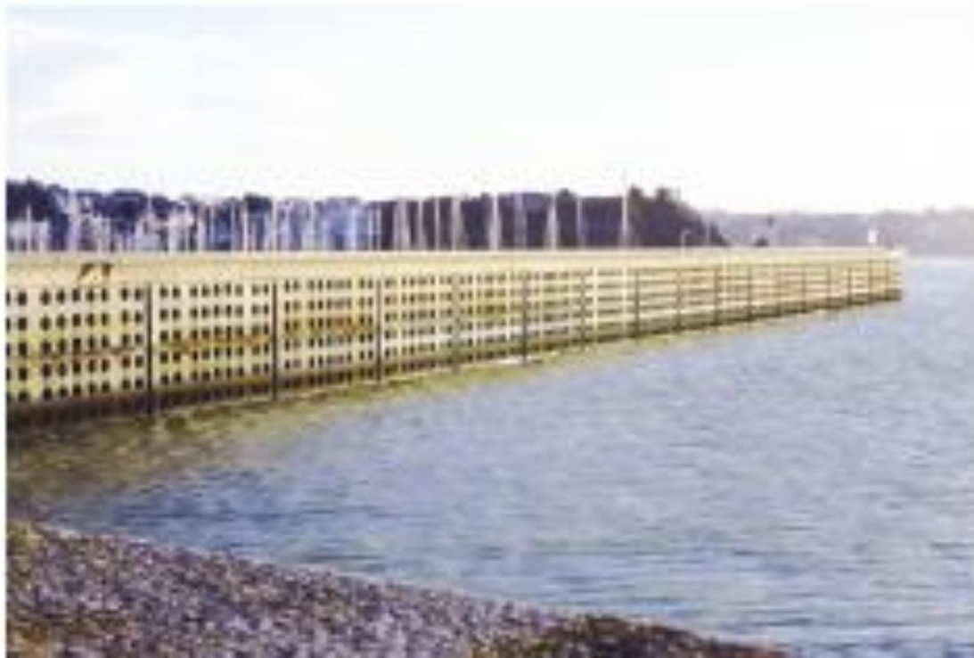
Σχήμα 15: Μορφή διάτρητου κυματοθραύστη με κατακόρυφο μέτωπο (Πηγή: Eurotop II 2016)
