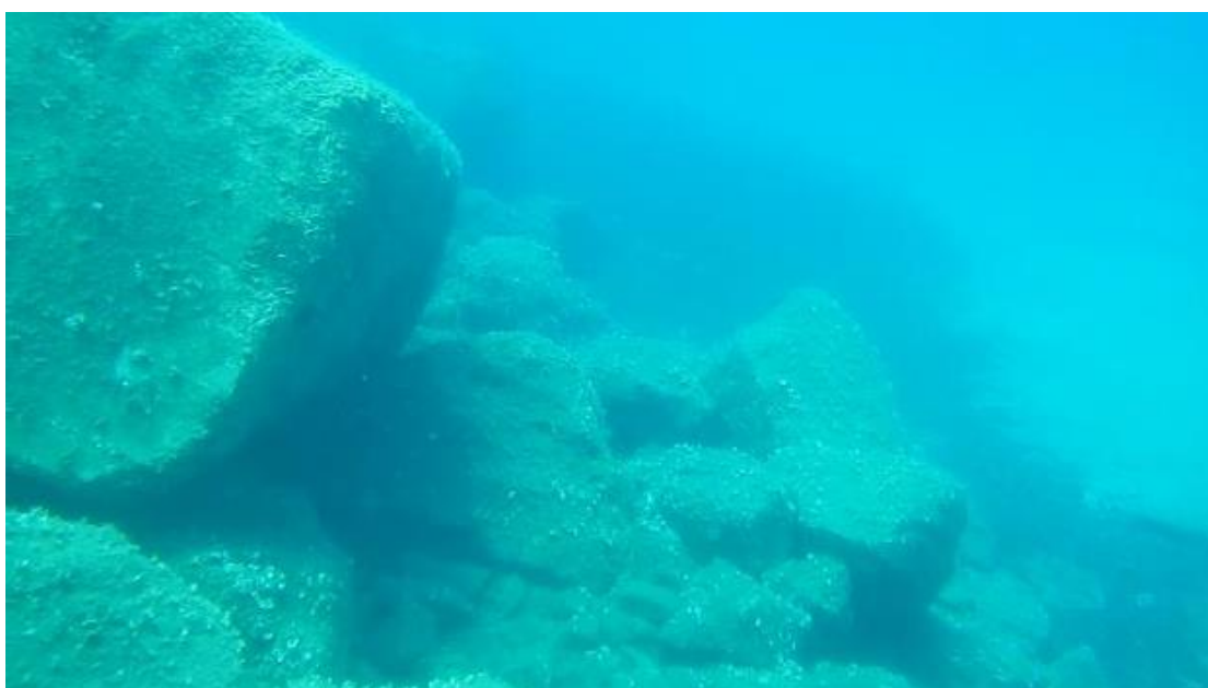
Σχήμα 54: Διαπίστωση ύπαρξης μικρού ύψους berm, με λίθους μικρότερης διαβάθμισης από την προβλεπόμενη (Ε.Λ.Ε. Ε.Μ.Π.,2018)
