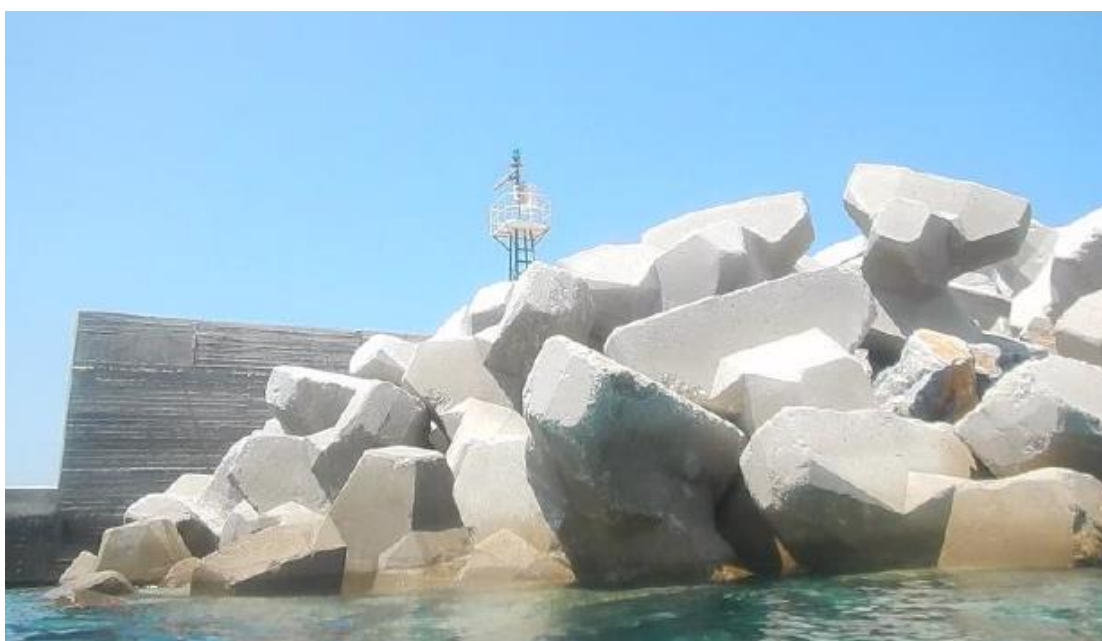
Σχήμα 52: Αποψη της κεφαλής του ακρομωλίου. Αριστερά διακρίνεται το τριγωνικό τμήμα χωρίς θωράκιση (Ε.Λ.Ε. Ε.Μ.Π., 2018).
