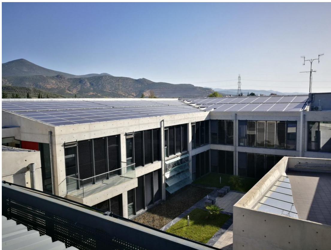
Εικόνα 14 : Τοποθέτηση φωτοβολταϊκών στη στέγη (γενική άποψη)
