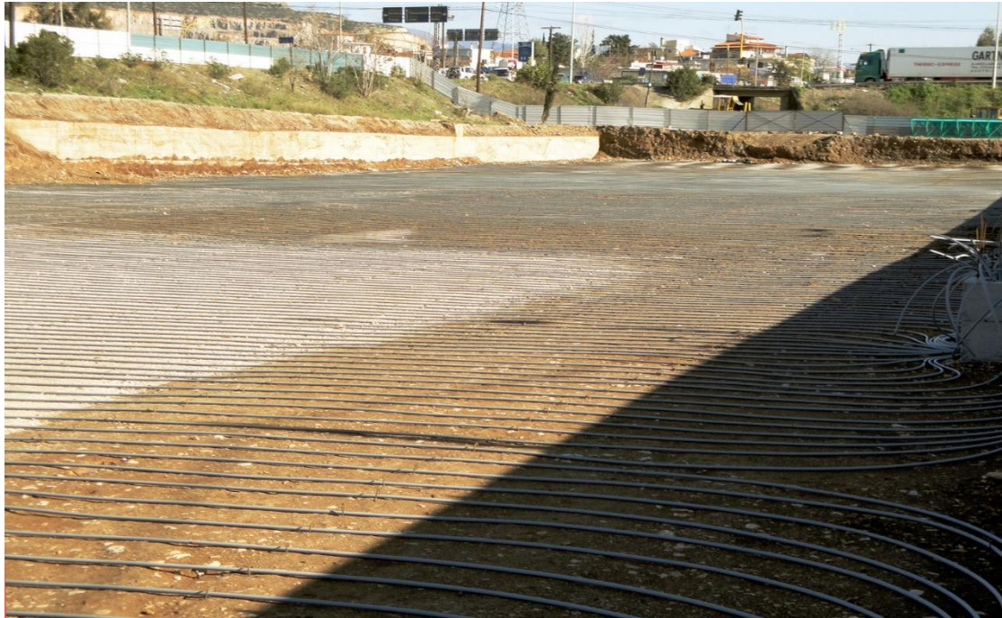
Εικόνα 7 : Τοποθέτηση σωληνώσεων πολυαιθυλενίου (κοντά)
