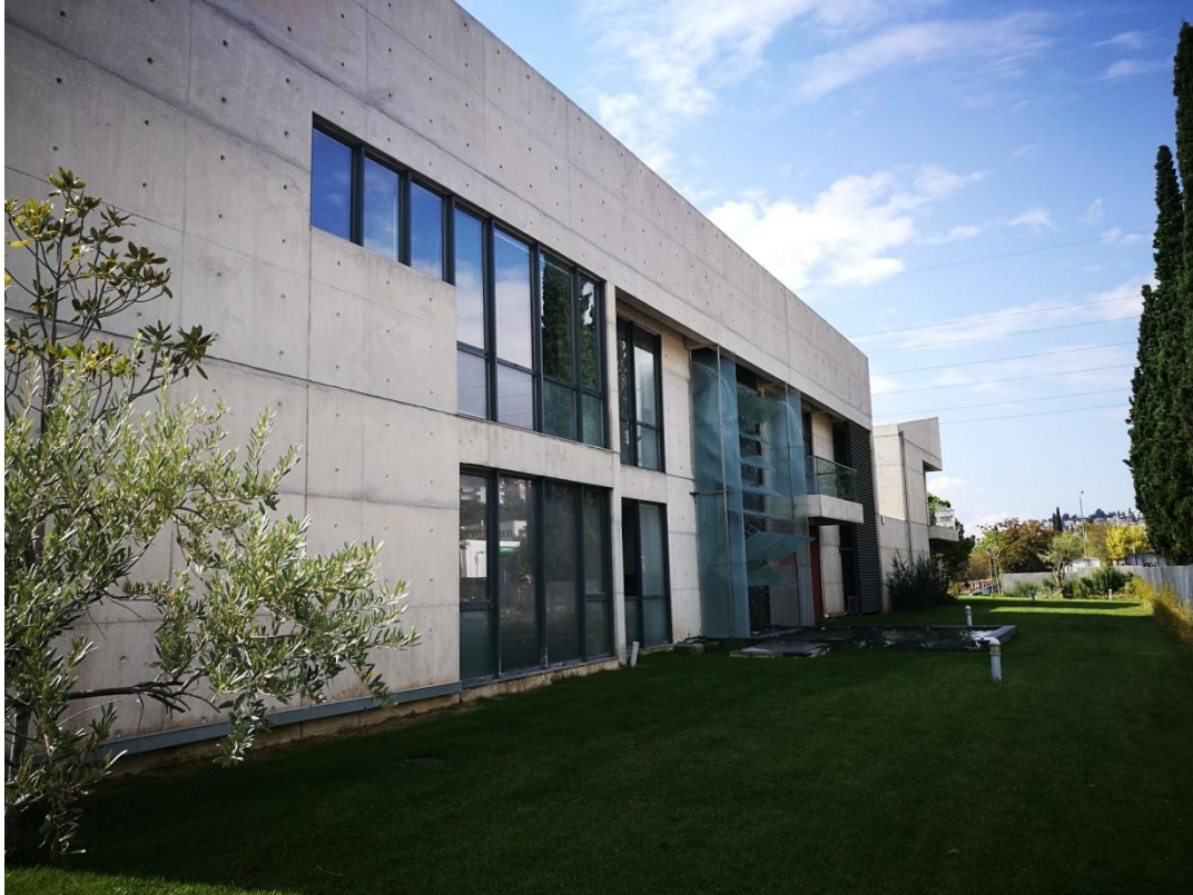
Εικόνα 5: Βόρεια όψη του κτηρίου της ΔΕΥΑ Λαμίας
