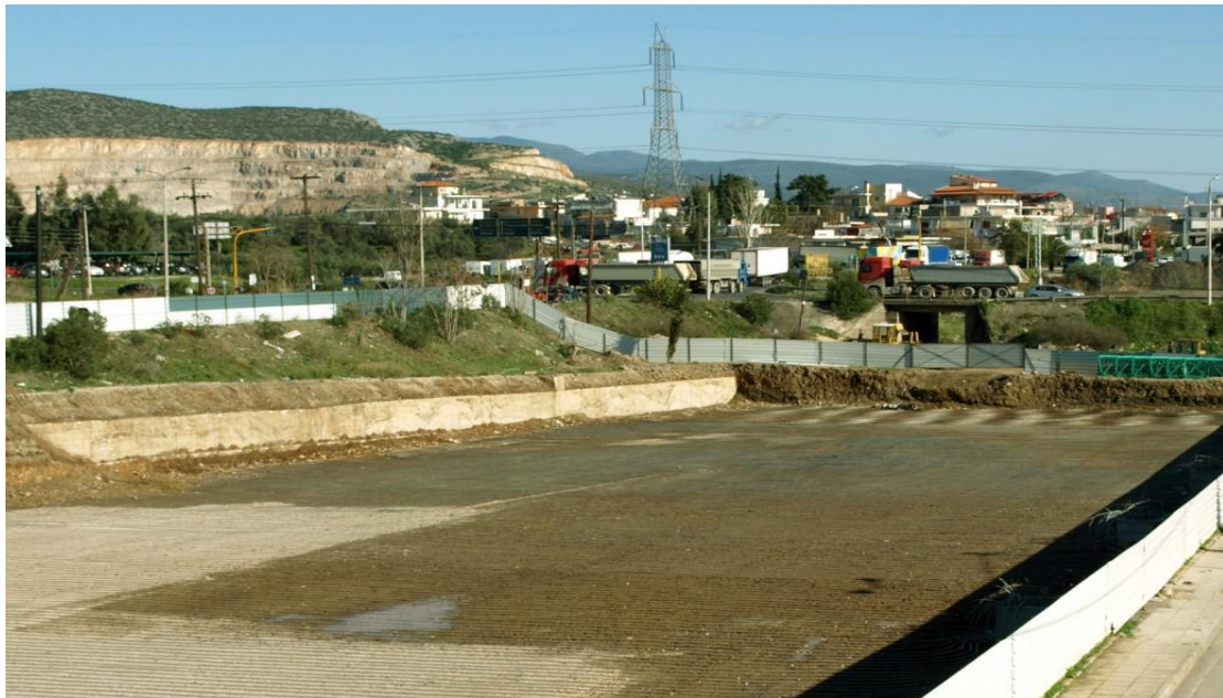
Εικόνα 6 : Σκάμμα έτοιμο για την τοποθέτηση του συστήματος γεωθερμίας
