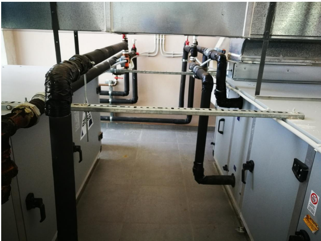
Εικόνα 11 : Τοποθέτηση κλιματιστικών μονάδων
