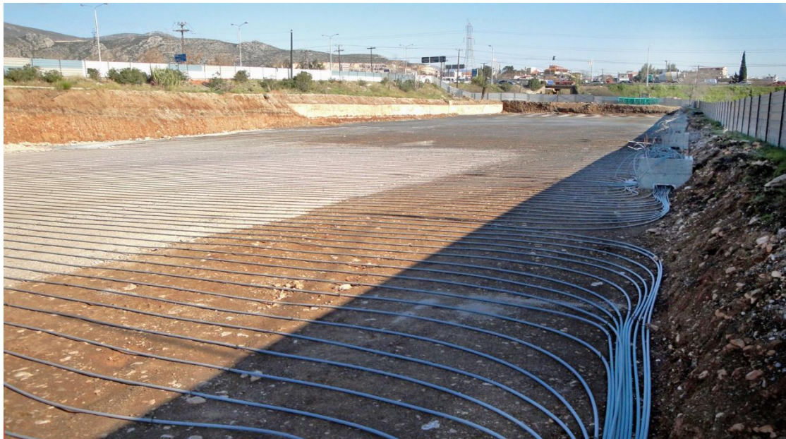
Εικόνα 8 : Τοποθέτηση σωληνώσεων πολυαιθυλενίου
