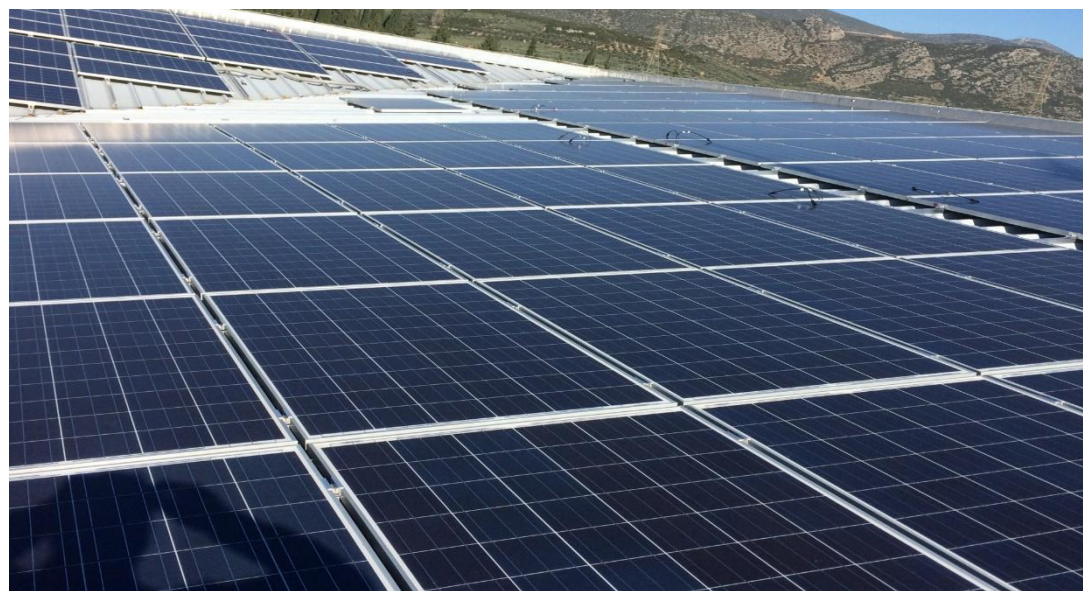
Εικόνα 15 : Τοποθέτηση φωτοβολταϊκών στη στέγη
