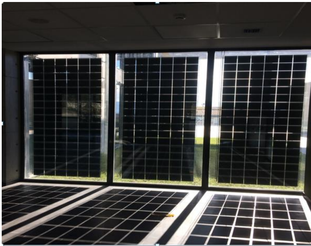
Εικόνα 16 : Τοποθέτηση φωτοβολταϊκών στις όψεις του κτηρίου
