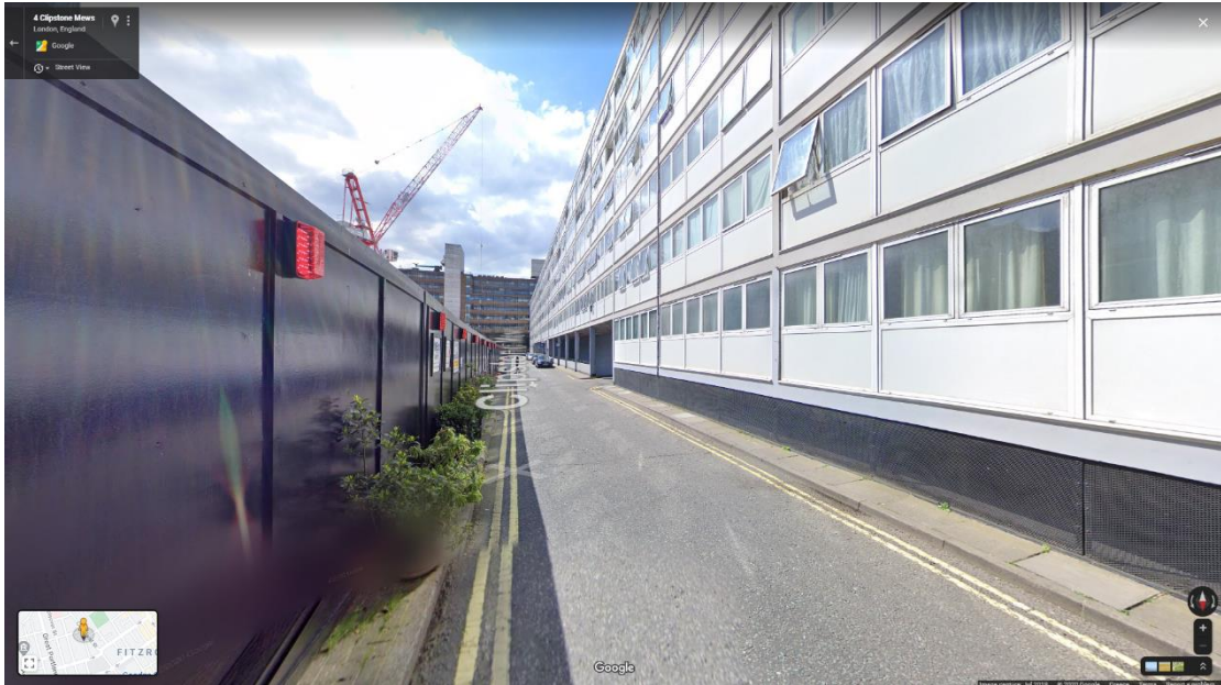
Εικόνα 3.15: Παράδειγμα τμήματος χωρίς δημόσιο φωτισμό: S5=0 (Πηγή: Google Street View)
