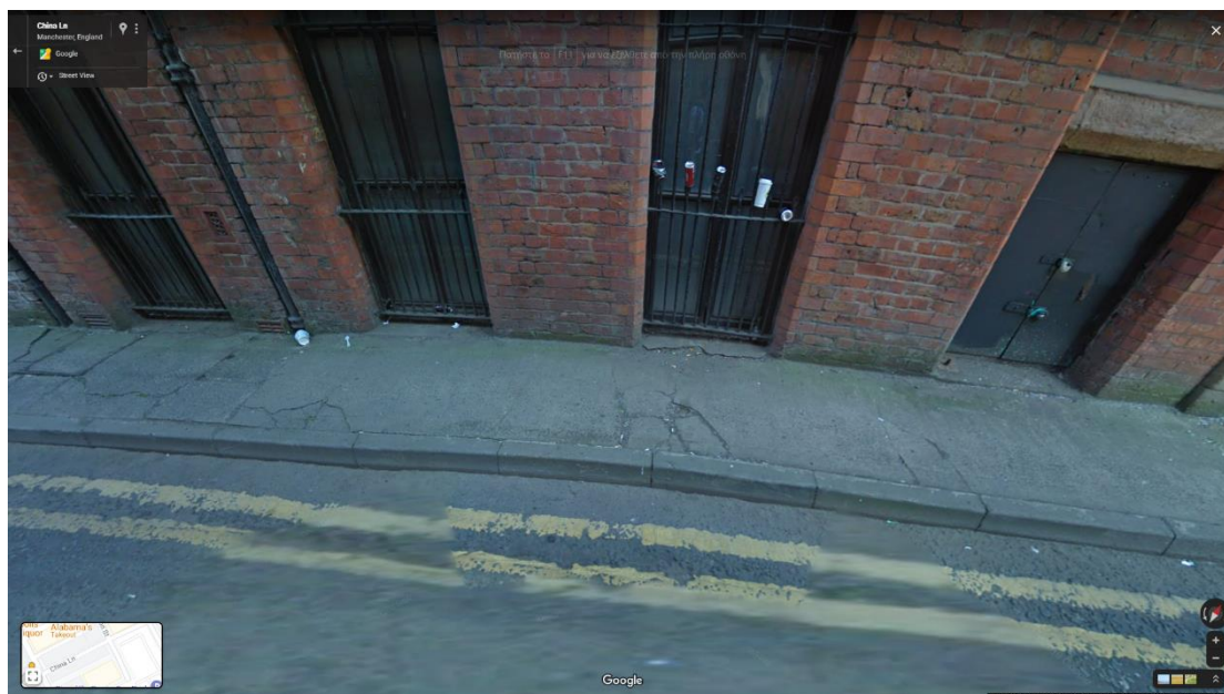
Εικόνα 3.24: Παράδειγμα τμήματος με πεζοδρόμιο με εμφανείς φθορές: S10=0 (Πηγή: Google Street View)
